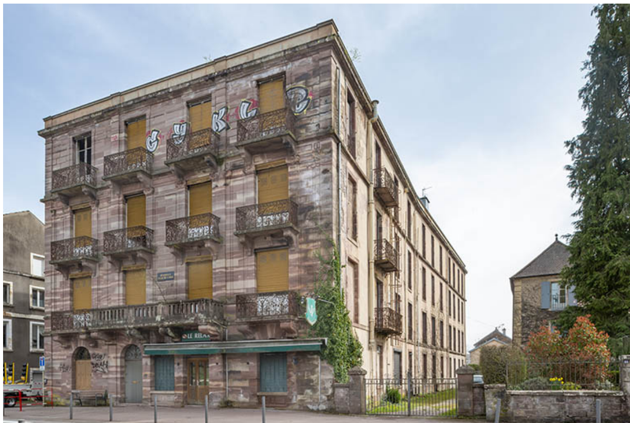
Vue d'ensemble depuis la rue des Thermes.
