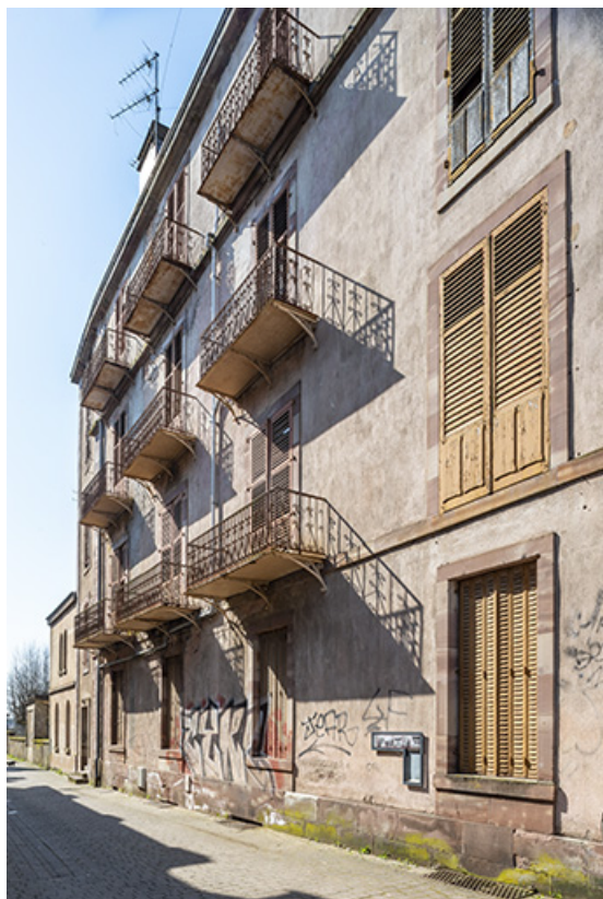
Façade du corps principal sur l'allée des Romains.
