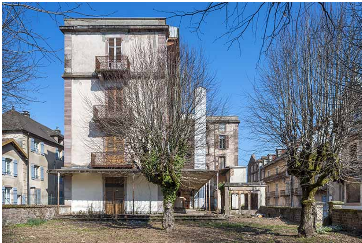
Extrémité de l'aile sud sur l'allée des Romains.
