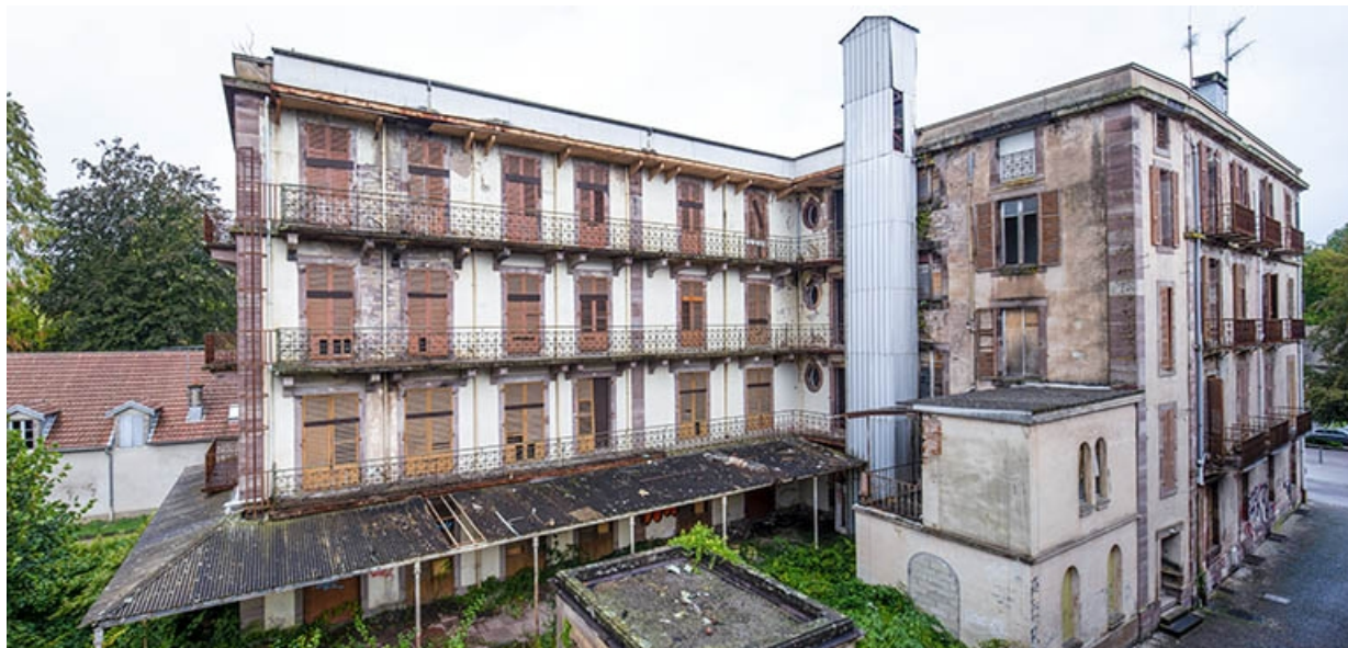
Façade de l'aile sud sur l'allée des Romains. 70, Luxeuil-les-Bains, 12 rue des Thermes
