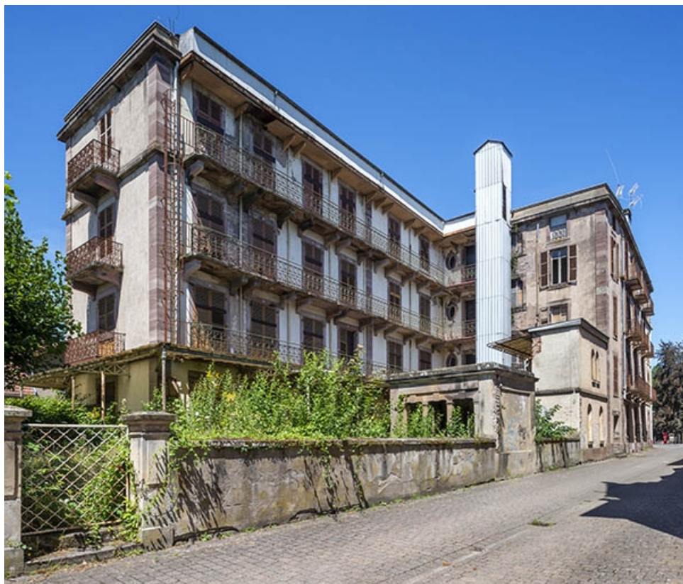
Façade de l'aile sud sur l'allée des Romains. 70, Luxeuil-les-Bains, 12 rue des Thermes
