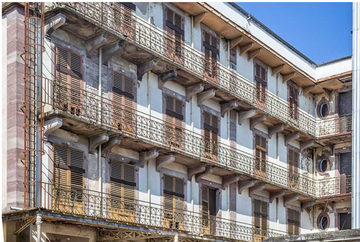
Façade de l'aile sud sur l'allée des Romains, détail.
