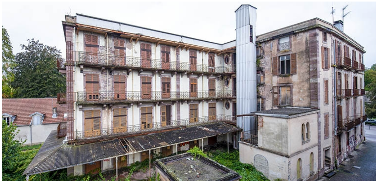
Façade de l'aile sud sur l'allée des Romains.
