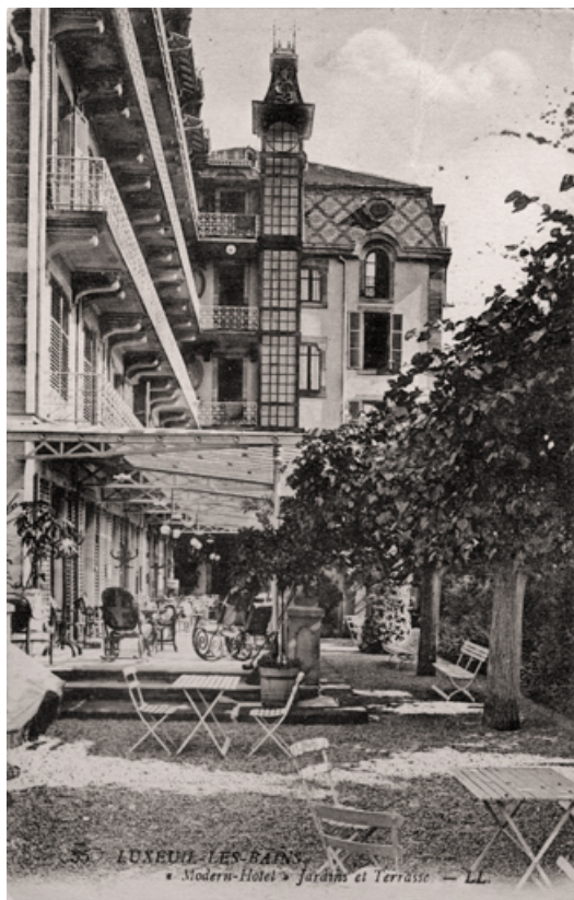
Façade sur l'allée des Romains (vers 1920). 70, Luxeuil-les-Bains, 12 rue des Thermes
