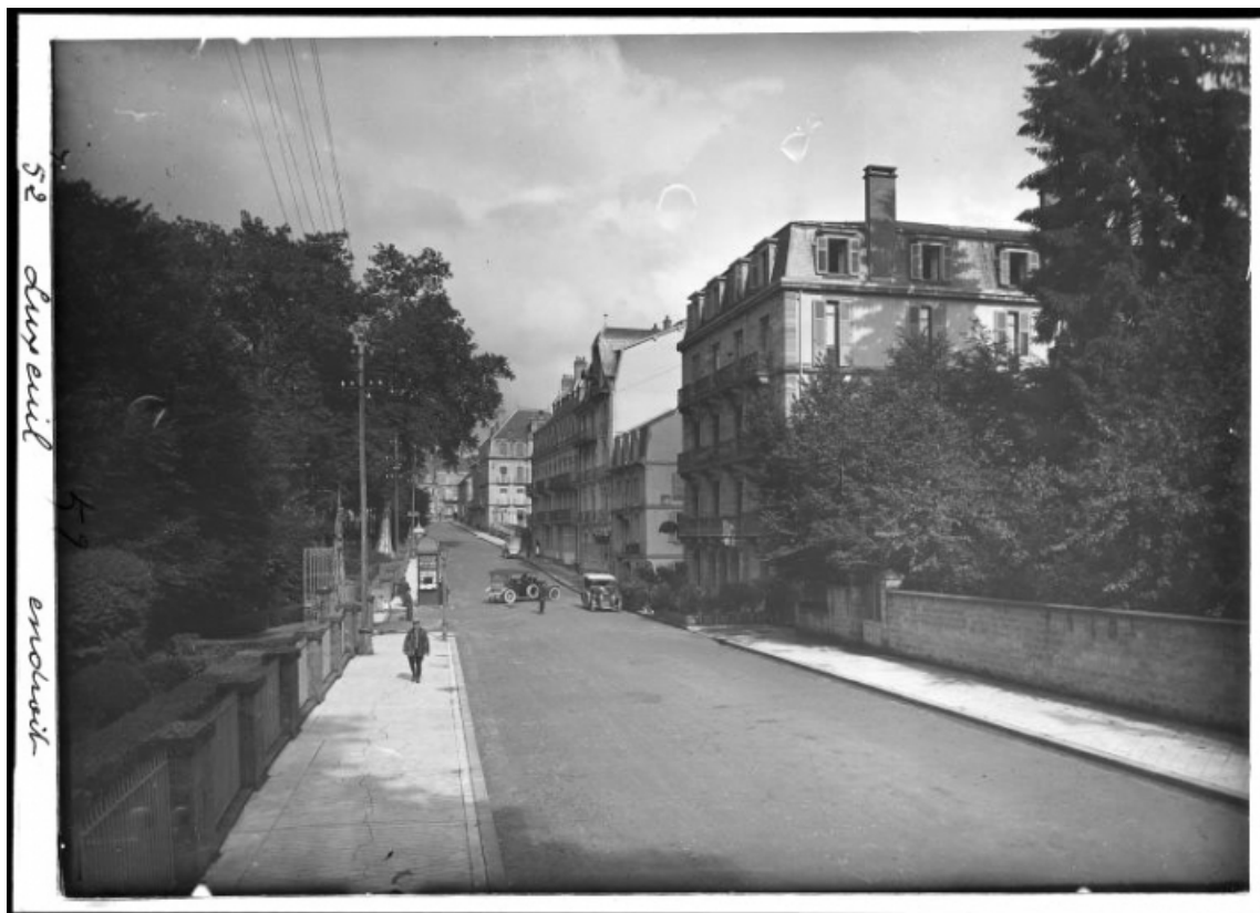
Vue ancienne (deuxième quart du 20e siècle).
