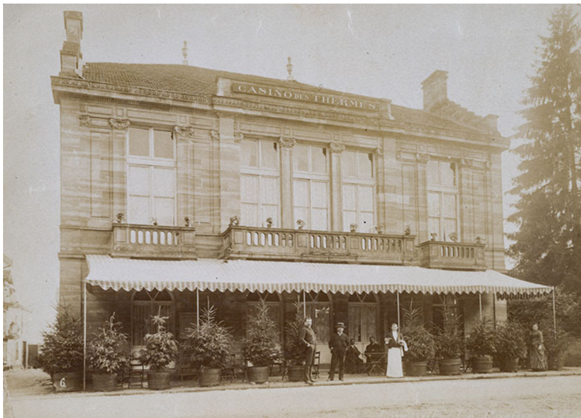
Façade du casino des thermes ("Salon Monnier") (vers 1880).
