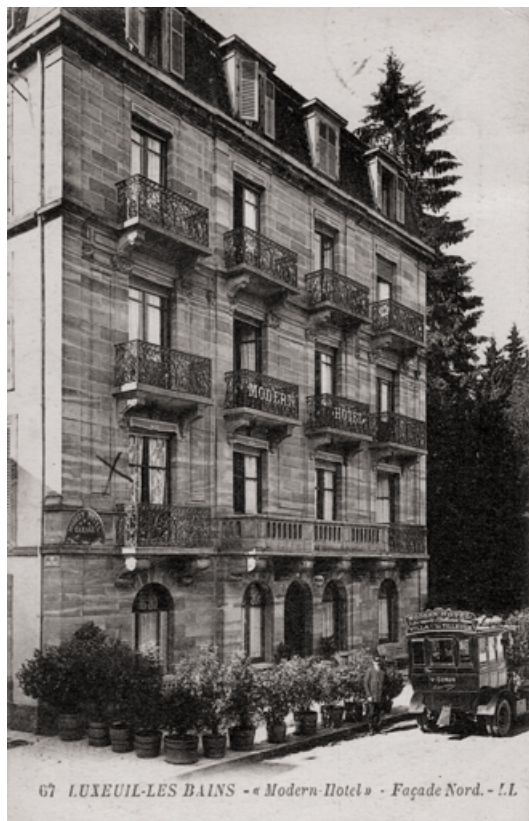
Façade sur la rue des Thermes (vers 1920). 70, Luxeuil-les-Bains, 12 rue des Thermes
