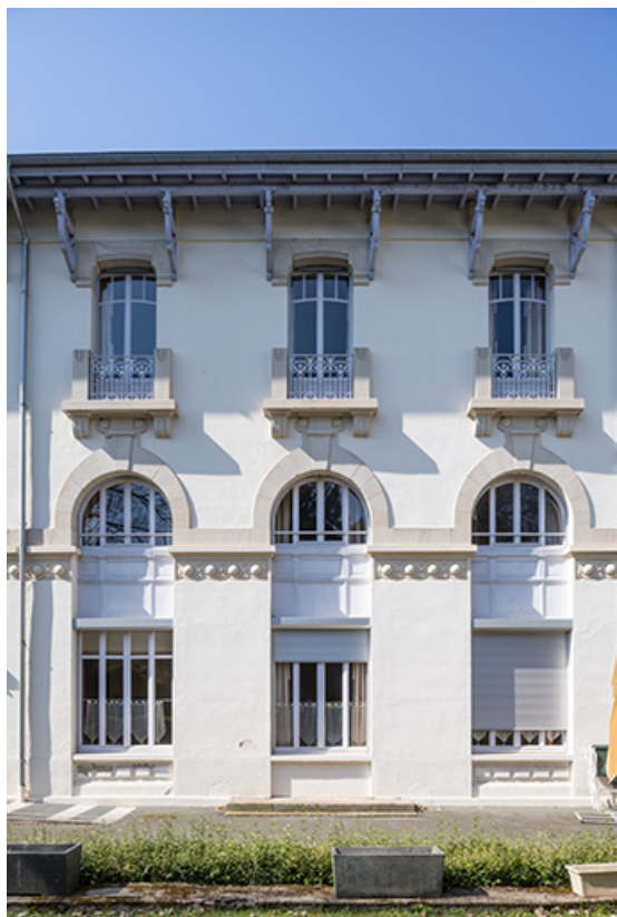
Façade est, vue de face, détail.
