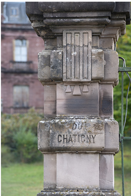
Portail de la clôture côté rue de Grammont, pilier. 70, Luxeuil-les-Bains, 10 rue de Grammont
