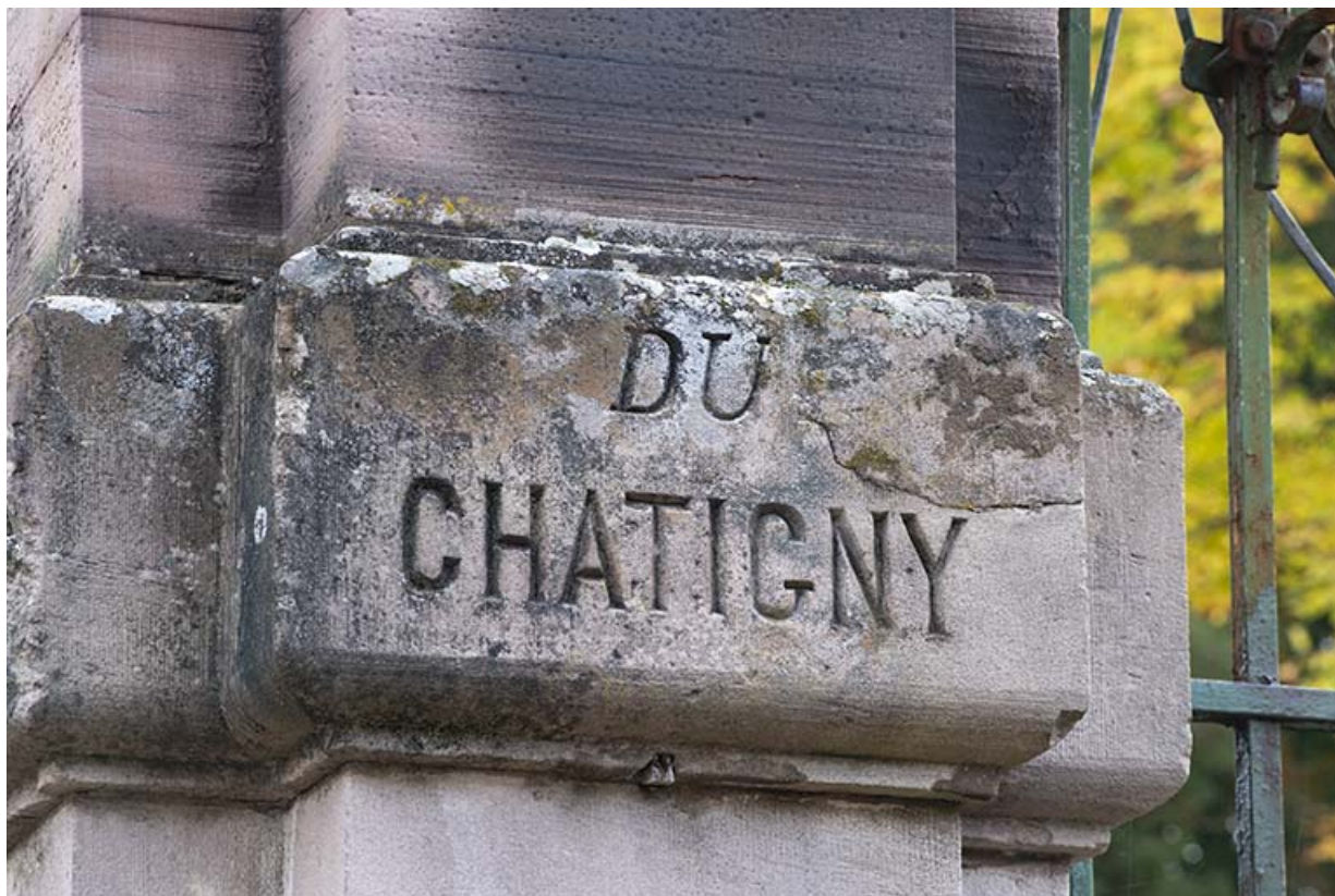
Portail de la clôture côté rue de Grammont, pilier : "DU CHATIGNY". 70, Luxeuil-les-Bains, 10 rue de Grammont
