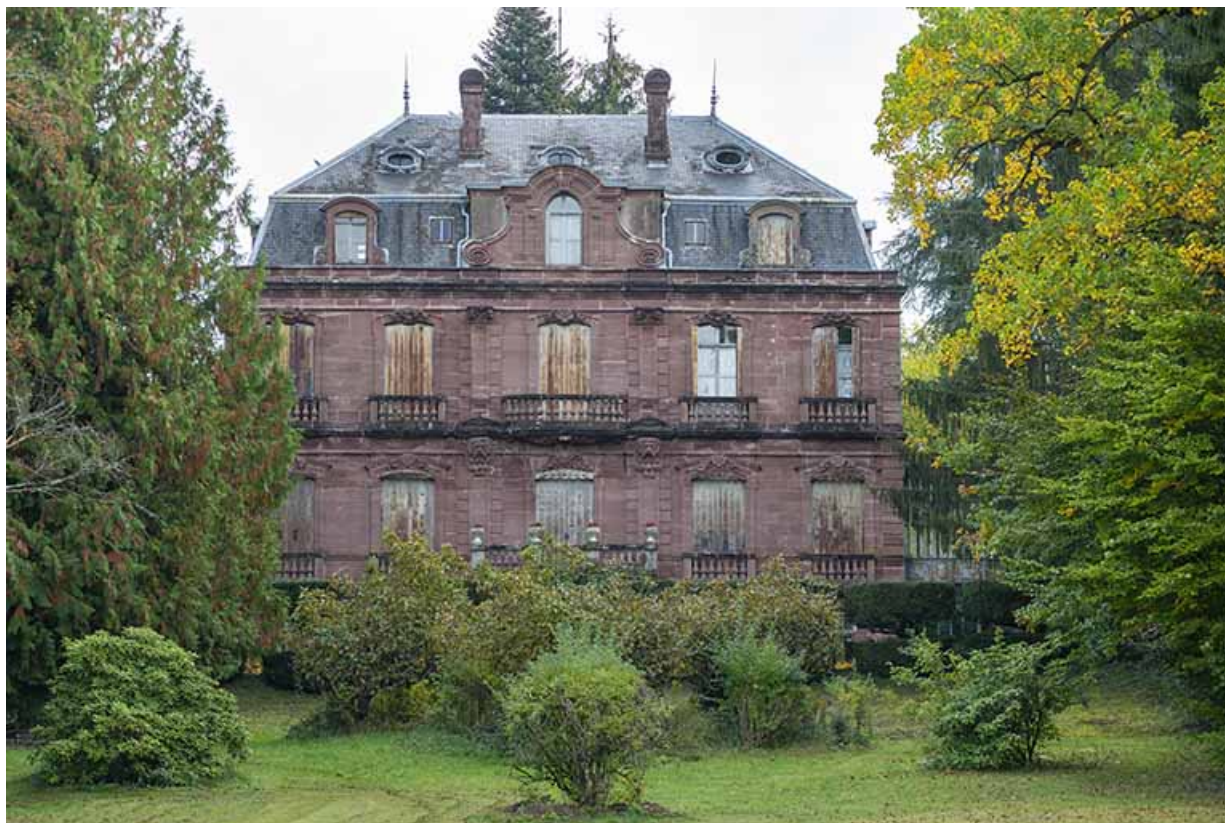
Façade principale, vue actuelle.
