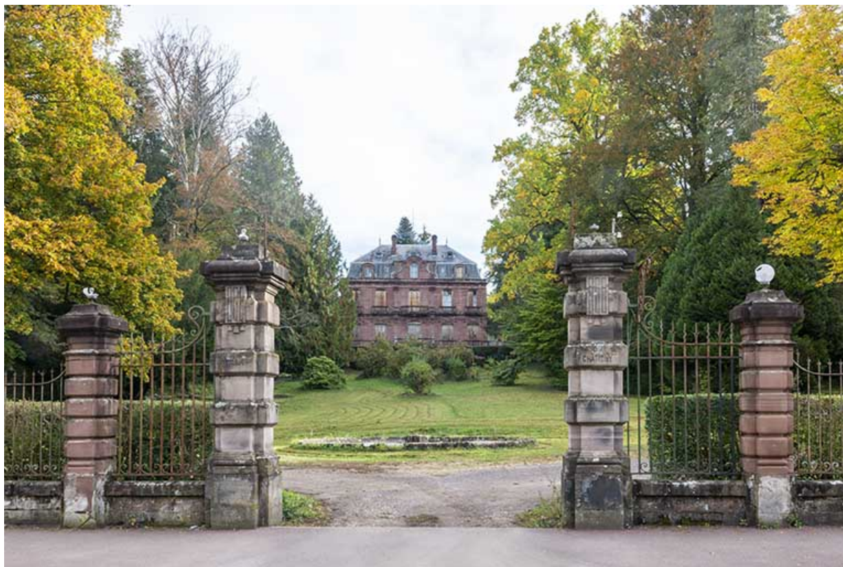
Portail de la clôture côté rue de Grammont.
