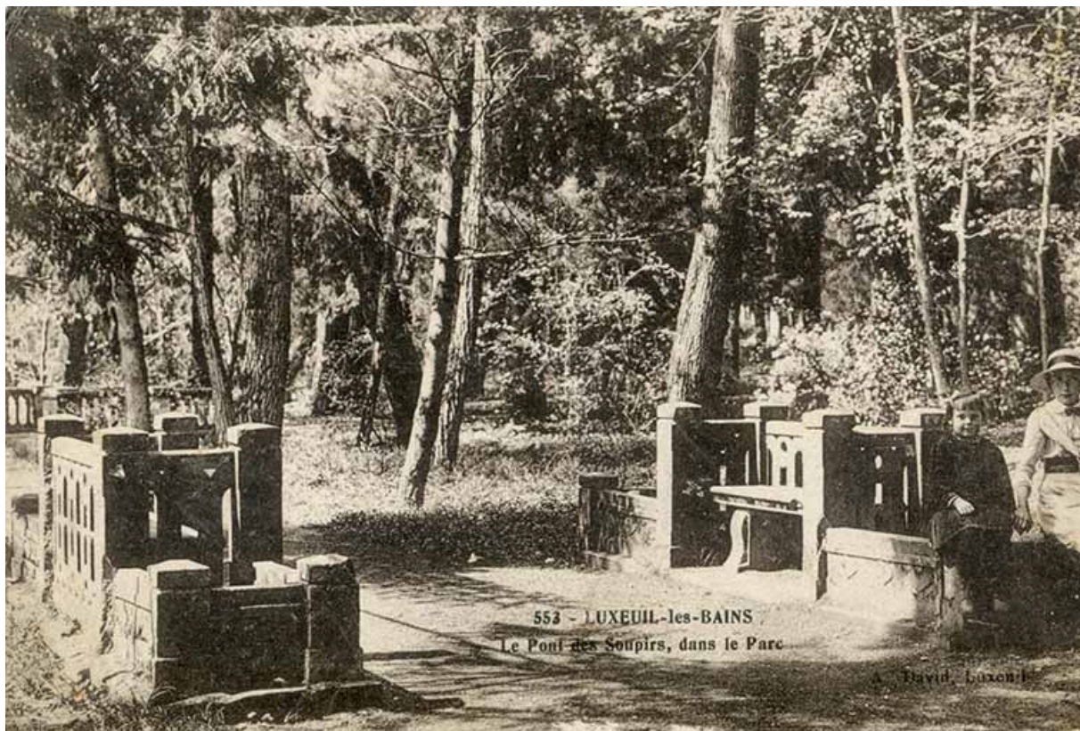
Pont en aval de l'île ("Pont des soupirs"). 70, Luxeuil-les-Bains, 3 rue des Thermes
