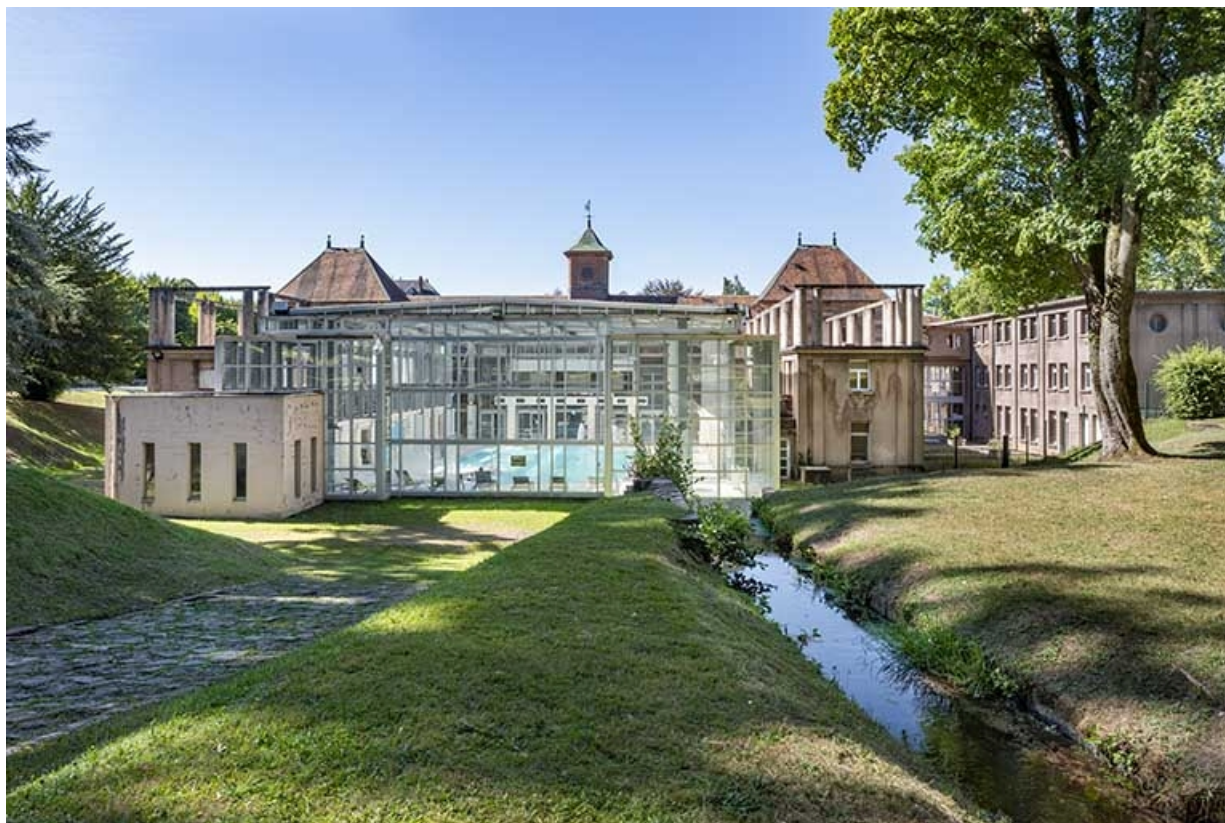
Vue en direction de l'établissement thermal.
