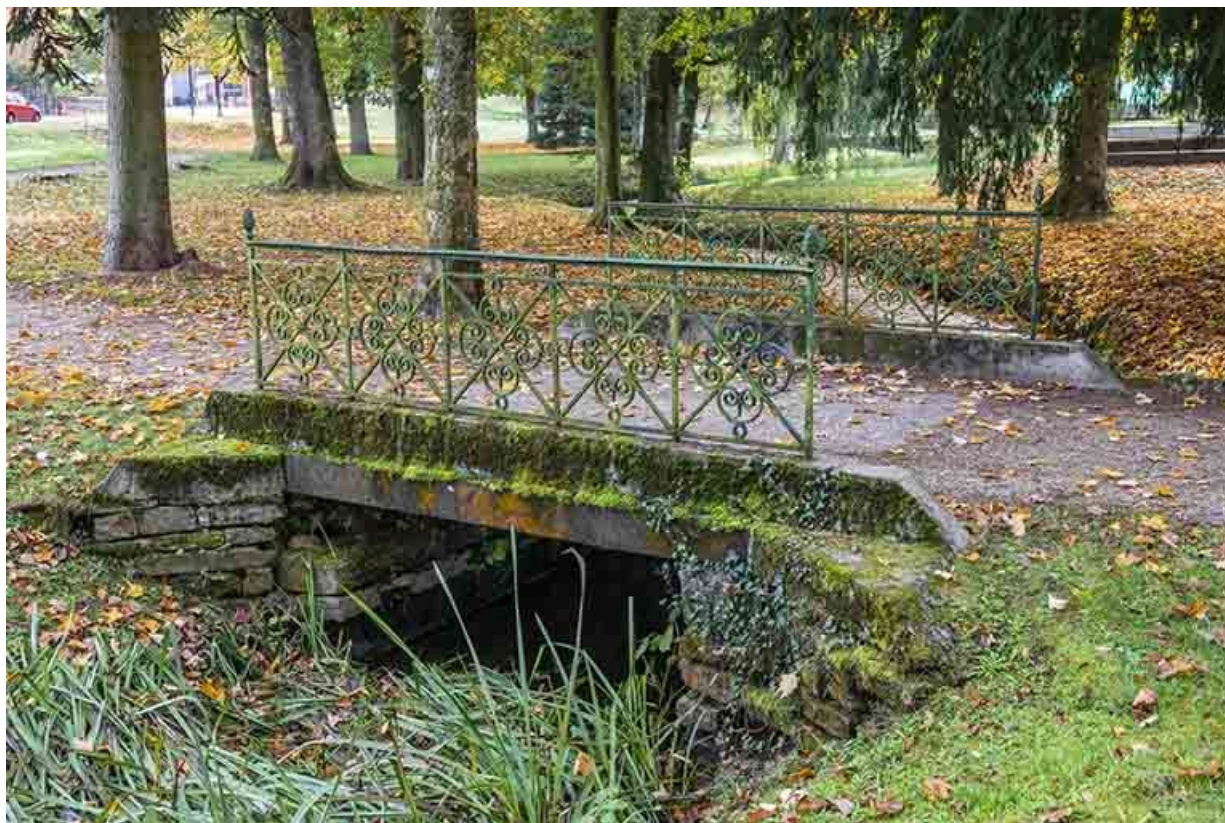
Pont à garde-corps en métal.
