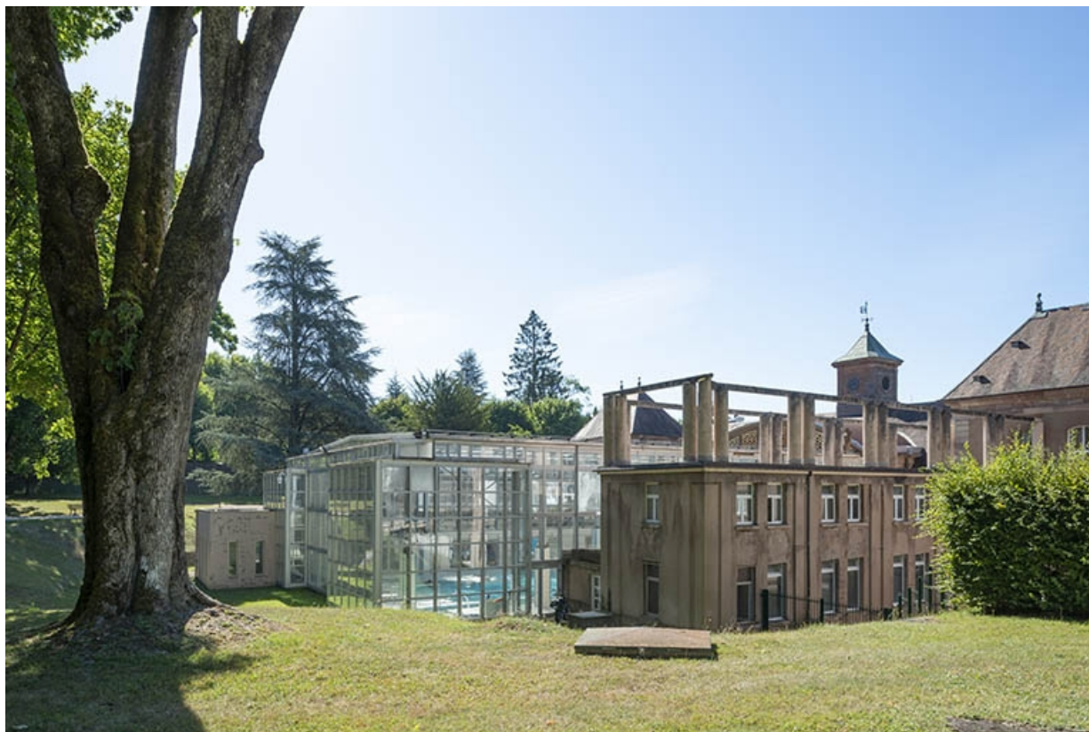
Vue en direction de l'établissement thermal.
