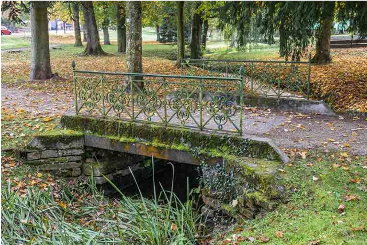
Pont à garde-corps en métal.
