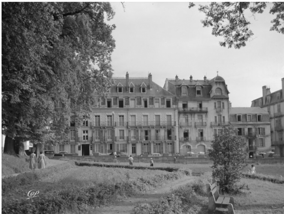
Façade nord, vue depuis le parc thermal au-delà de la rue des Thermes. 70, Luxeuil-les-Bains, 6 rue des Thermes
