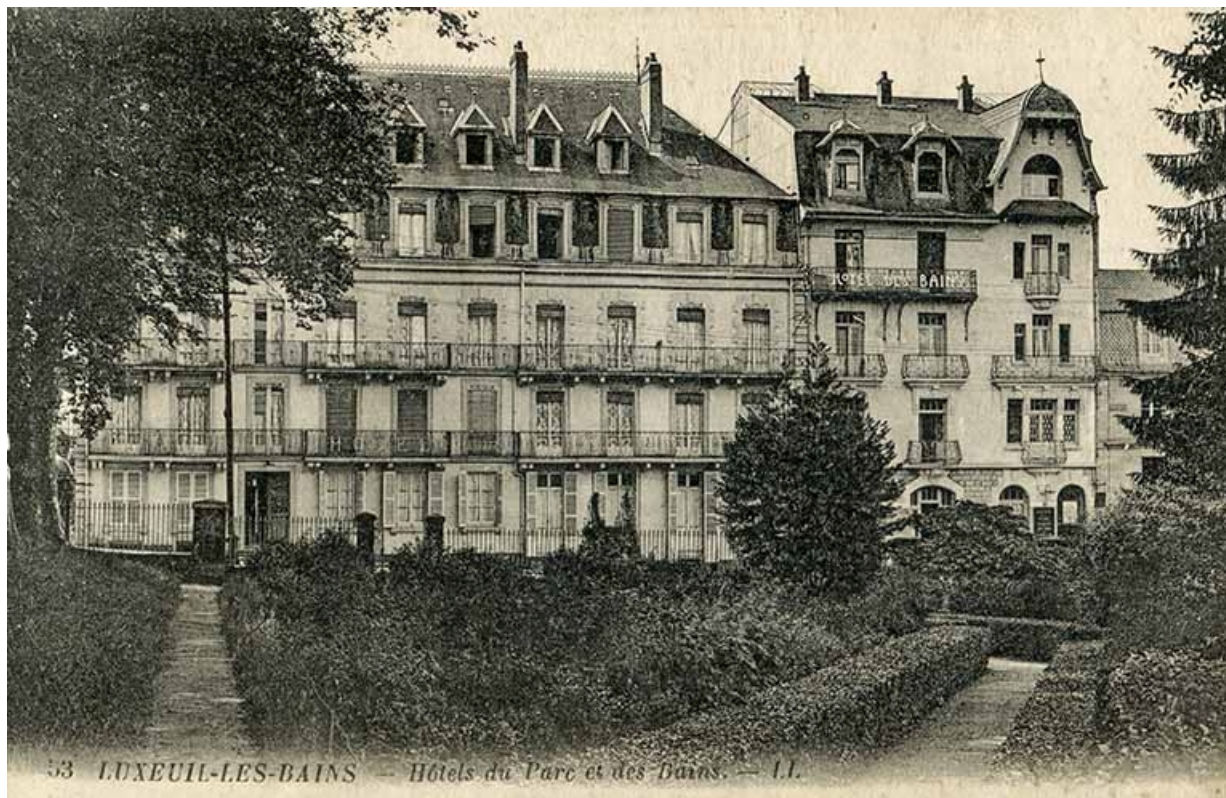
Façade nord, vue depuis le parc thermal au-delà de la rue des Thermes. 70, Luxeuil-les-Bains, 6 rue des Thermes
