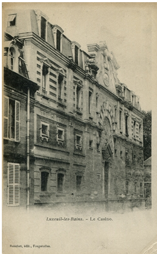
Façade sur la rue de Grammont, vue prise depuis l'est. 70, Luxeuil-les-Bains, 1 rue de Grammont
