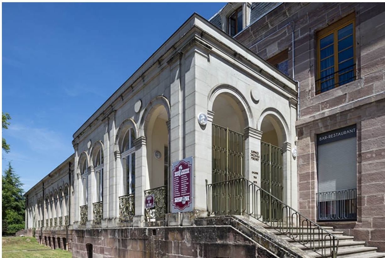
Galerie en façade ouest, vue depuis le sud (vue rapprochée).
