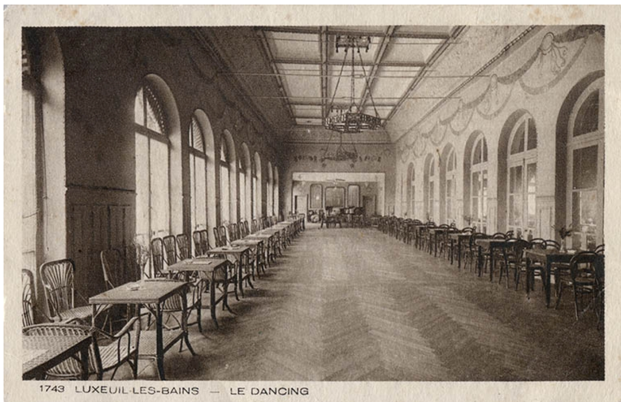
Galerie transformée en dancing, vue intérieure.
