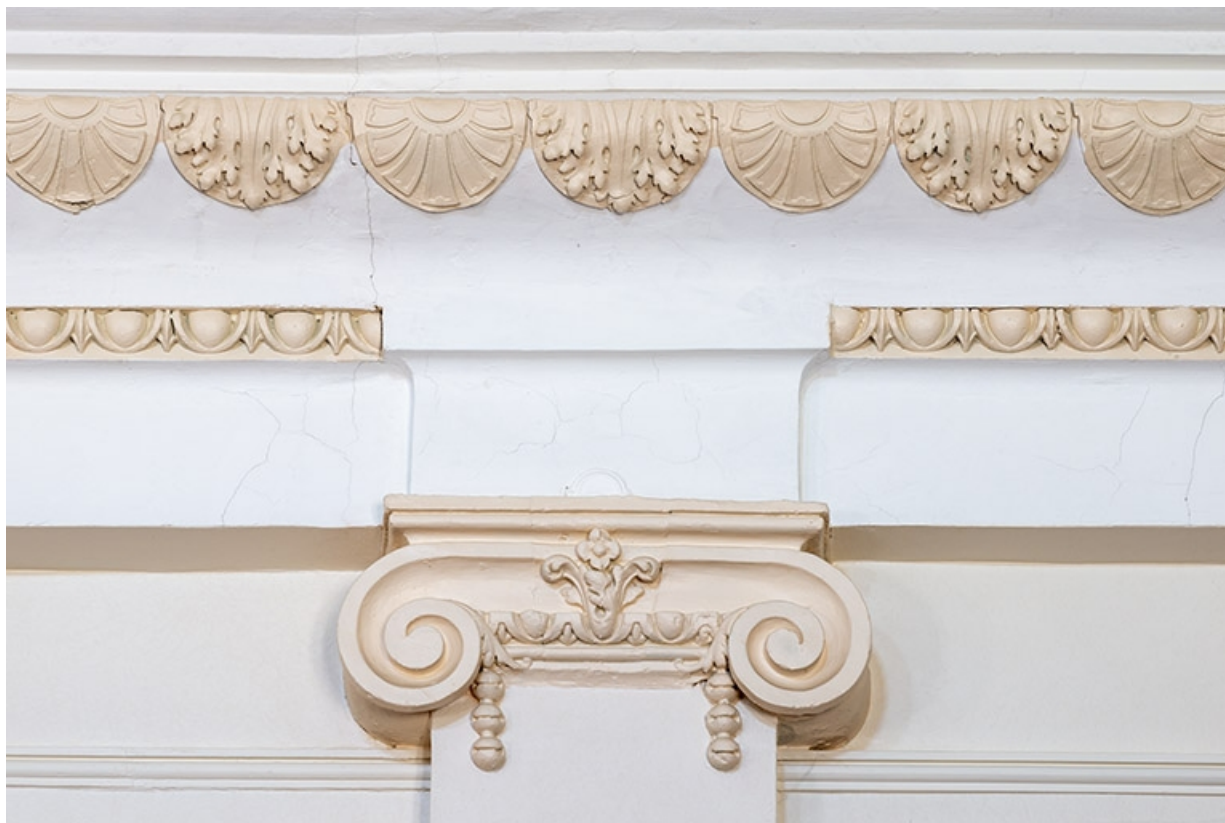
Salle : chapiteau surmontant un pilastre. 70, Luxeuil-les-Bains, 1 rue de Grammont
