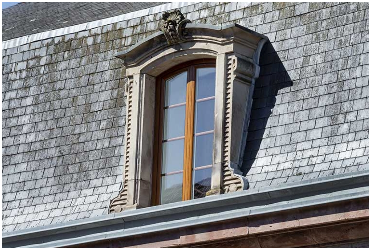
Maison Desgranges, lucarne est (lucarne centrale). 70, Luxeuil-les-Bains, 1 rue de Grammont
