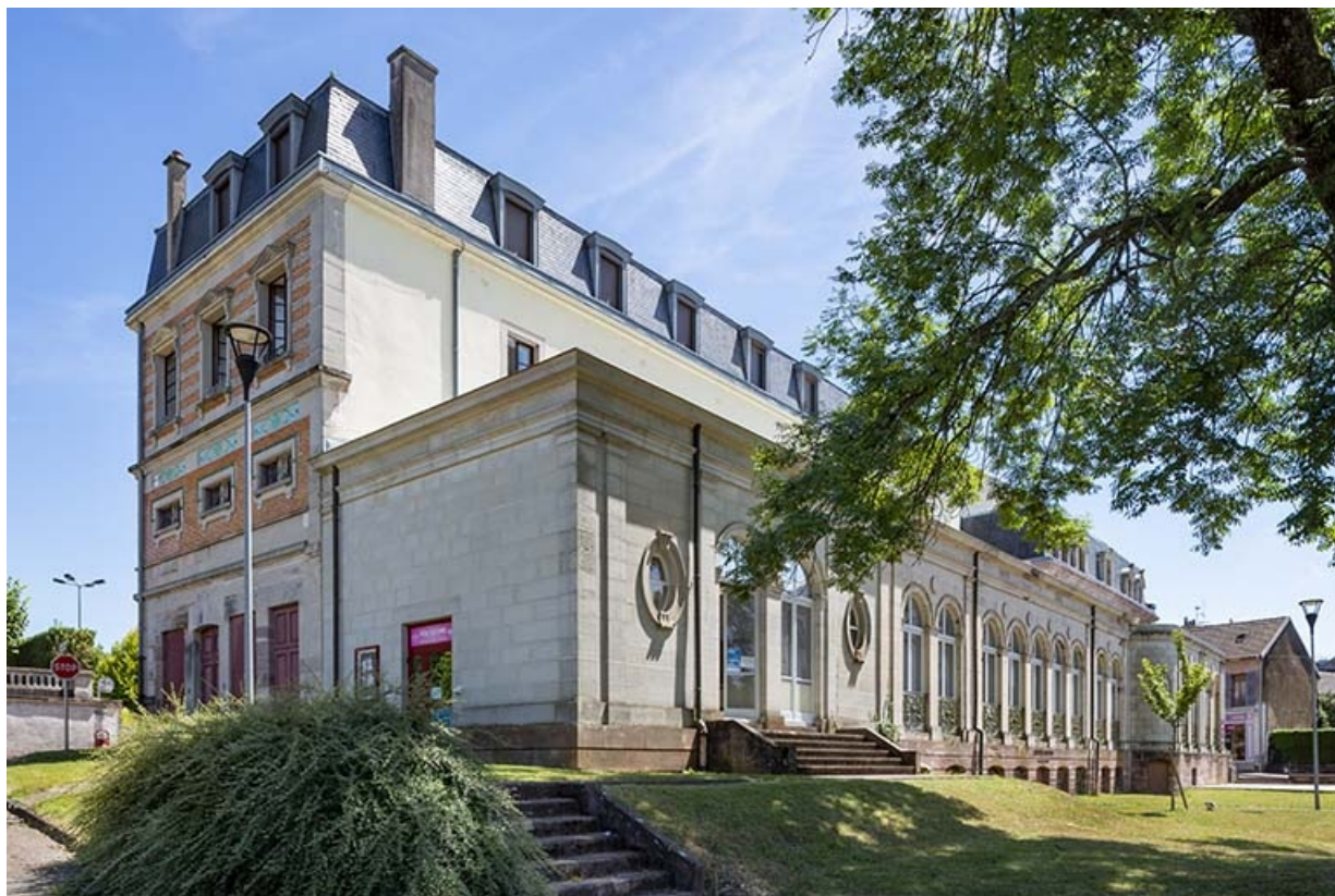
Galerie en façade ouest, vue depuis le nord-ouest.
