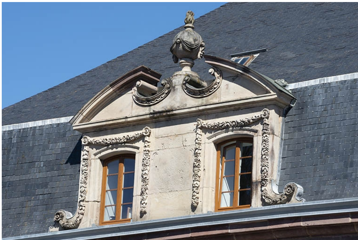
Maison Desgranges, lucarne sud.
