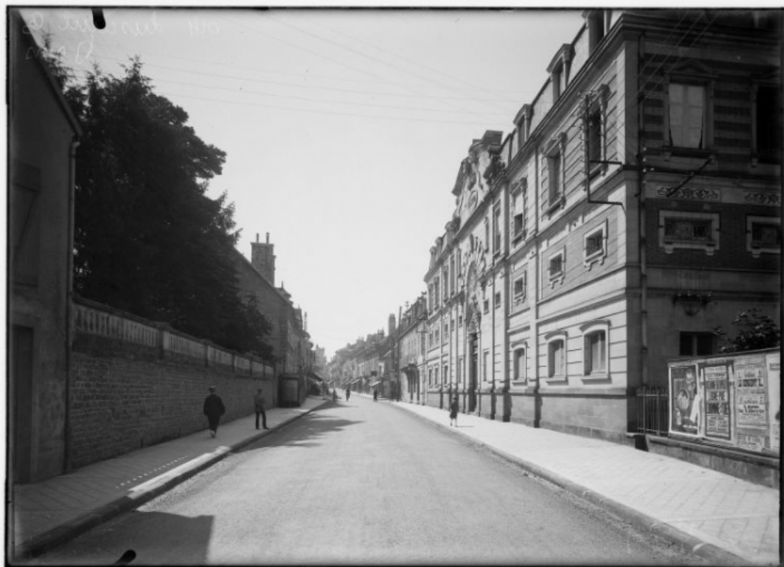
Façade sur la rue de Grammont, vue prise depuis le nord.
