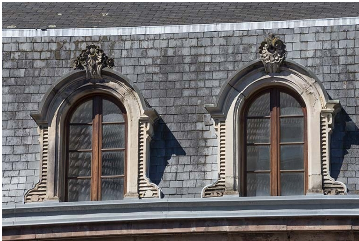
Maison Desgranges, lucarnes est (lucarnes latérales).
