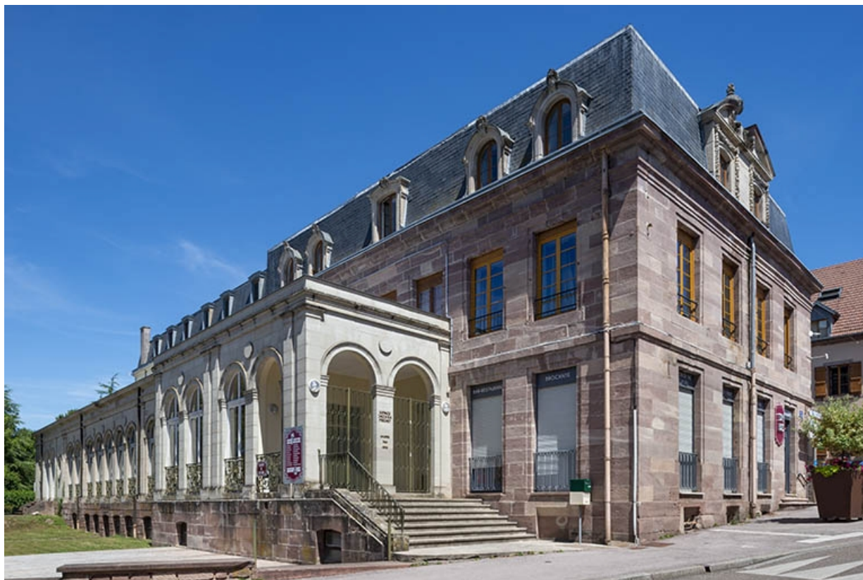
Galerie en façade ouest, vue depuis le sud.
