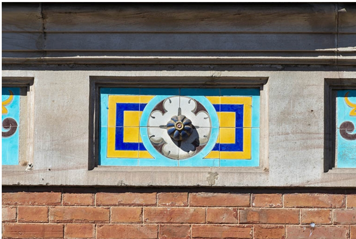
Façade sur la rue de Grammont, frise ornementale séparant le deuxième et le troisième niveau, détail. 70, Luxeuil-les-Bains, 1 rue de Grammont
