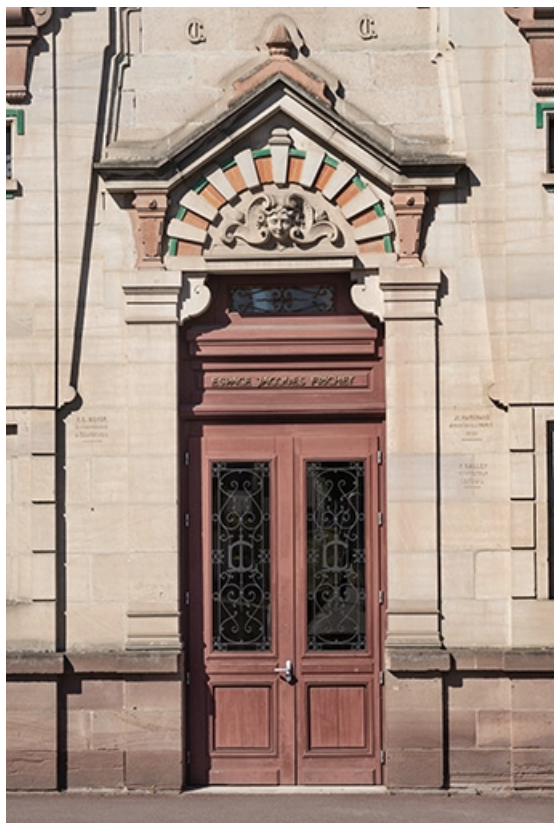
Façade sur la rue de Grammont, partie centrale, portail, détail. 70, Luxeuil-les-Bains, 1 rue de Grammont
