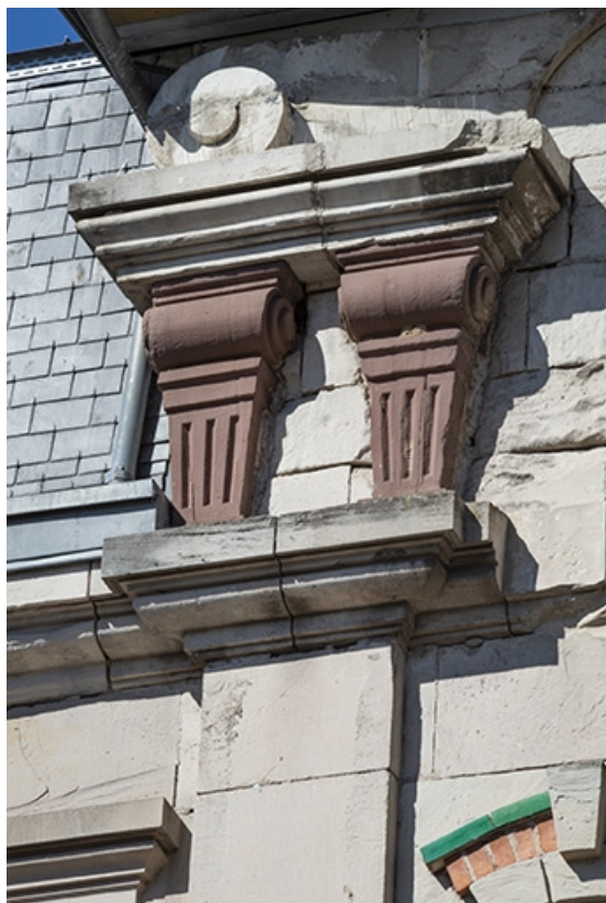
Façade sur la rue de Grammont, partie centrale, portail, détail : pilastres en gaine jumelés surmontés d'une volute. 70, Luxeuil-les-Bains, 1 rue de Grammont
