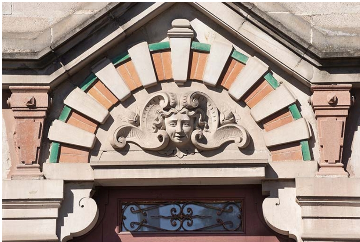
Façade sur la rue de Grammont, partie centrale, portail, détail : tympan (tête dans un cartouche). 70, Luxeuil-les-Bains, 1 rue de Grammont
