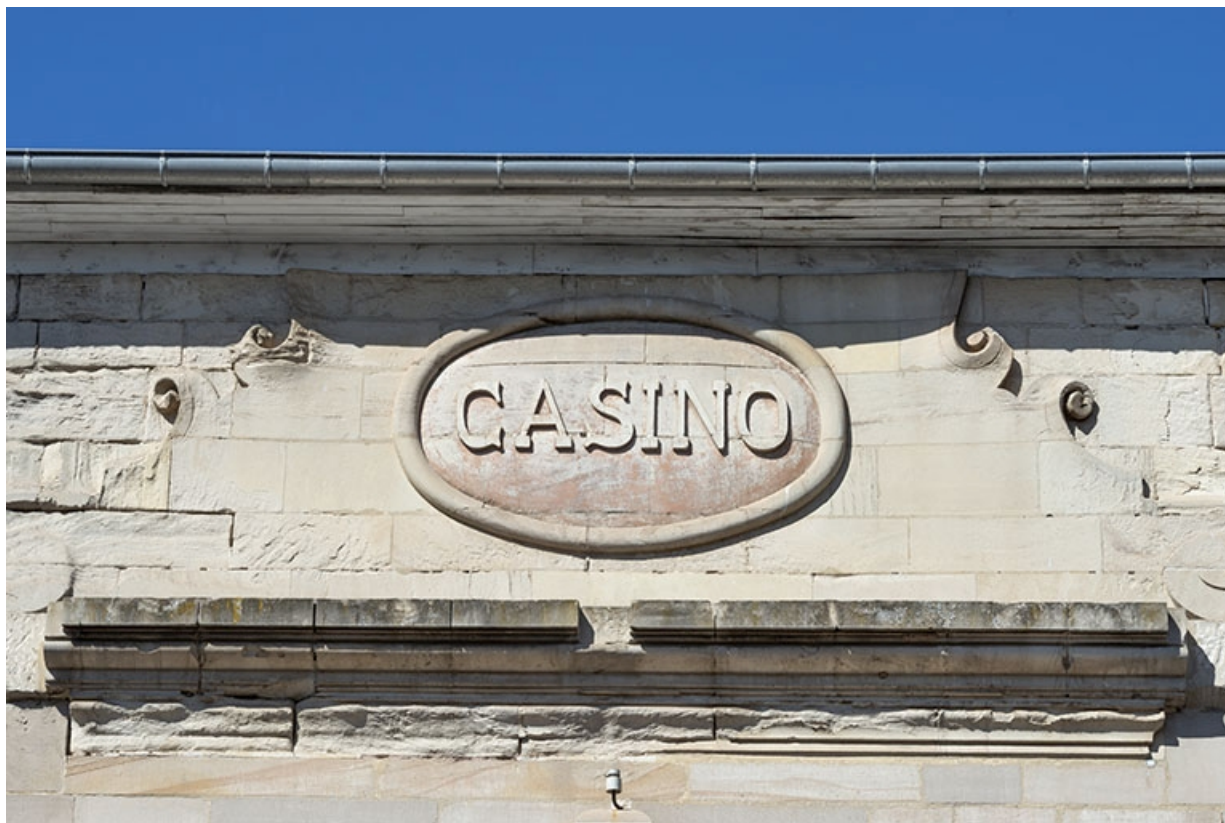
Façade sur la rue de Grammont, partie centrale, inscription : "CASINO". 70, Luxeuil-les-Bains, 1 rue de Grammont
