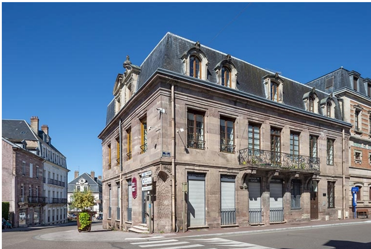
Maison Desgranges, façade sud et façade est. 70, Luxeuil-les-Bains, 1 rue de Grammont
