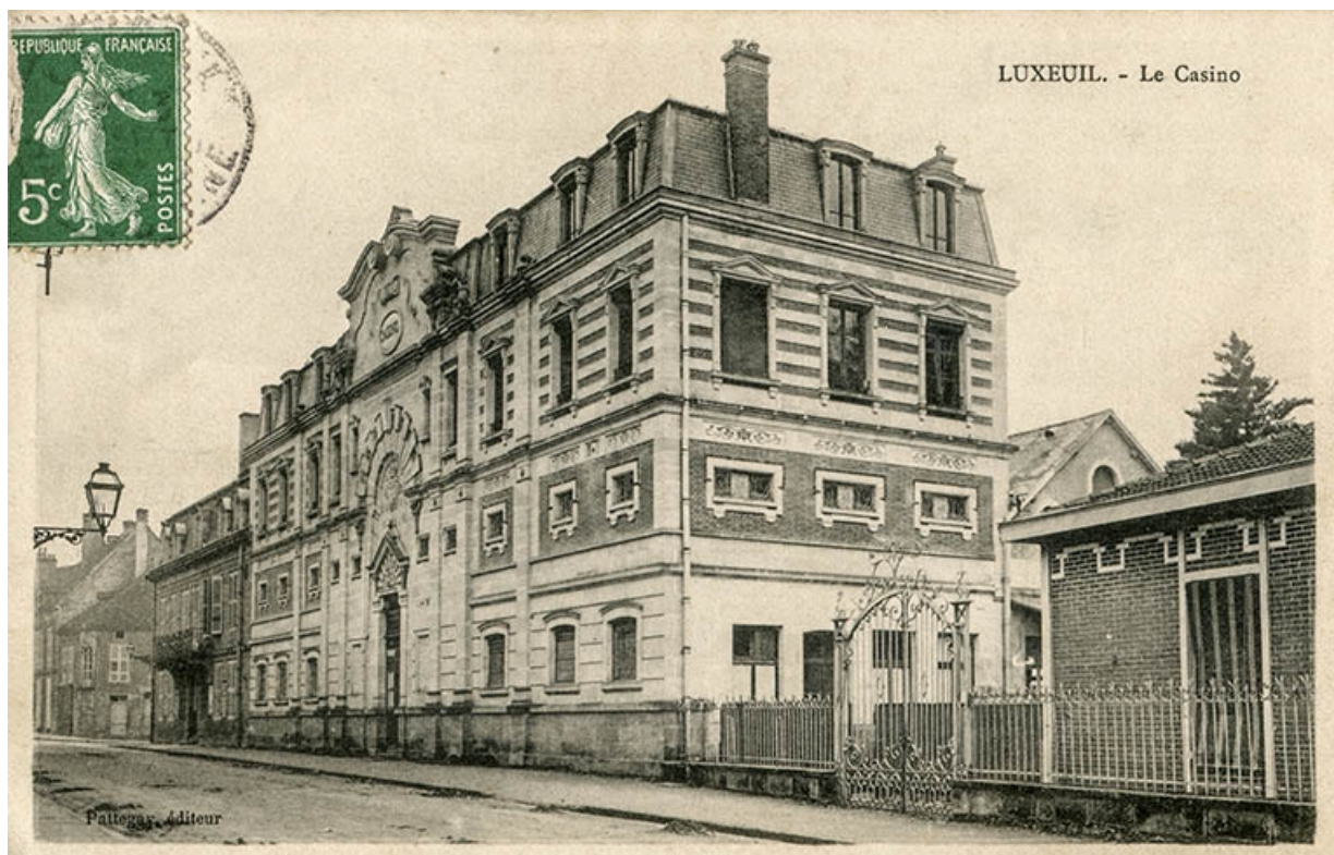
Façade sur la rue de Grammont, vue prise depuis le nord-est.
