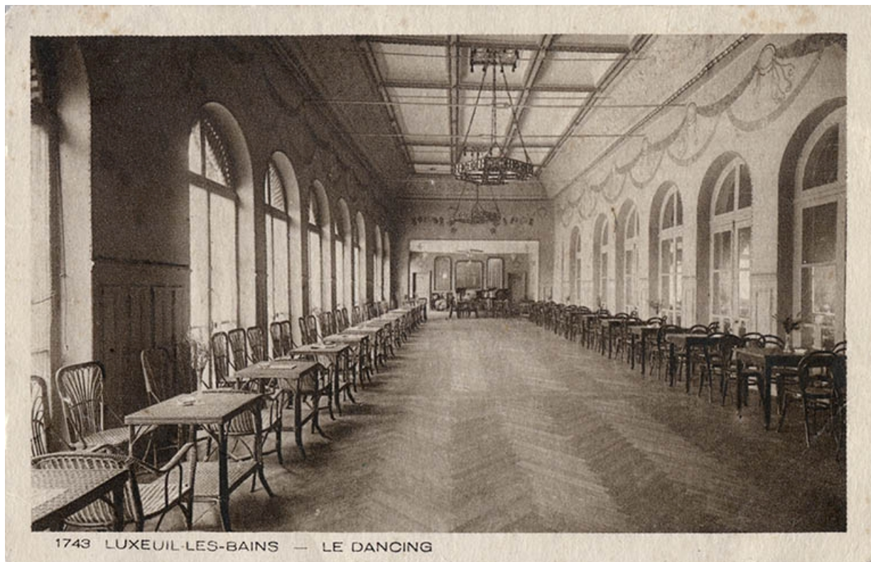
Galerie transformée en dancing, vue intérieure.
