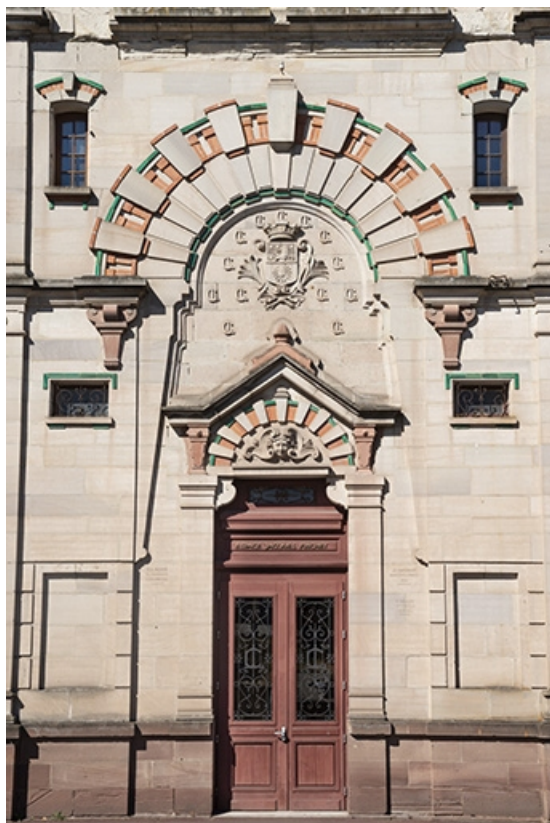
Façade sur la rue de Grammont, partie centrale, portail. 70, Luxeuil-les-Bains, 1 rue de Grammont
