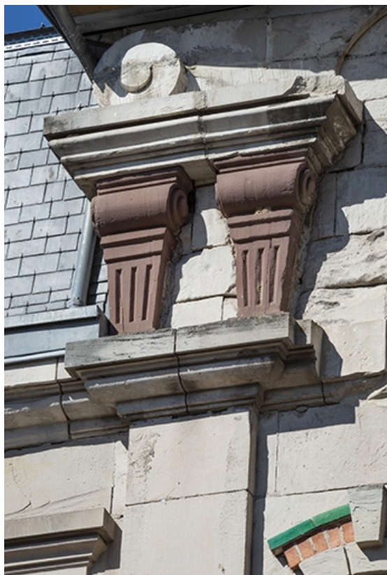
Façade sur la rue de Grammont, partie centrale, portail, détail : pilastres en gaine jumelés surmontés d'une volute. 70, Luxeuil-les-Bains, 1 rue de Grammont
