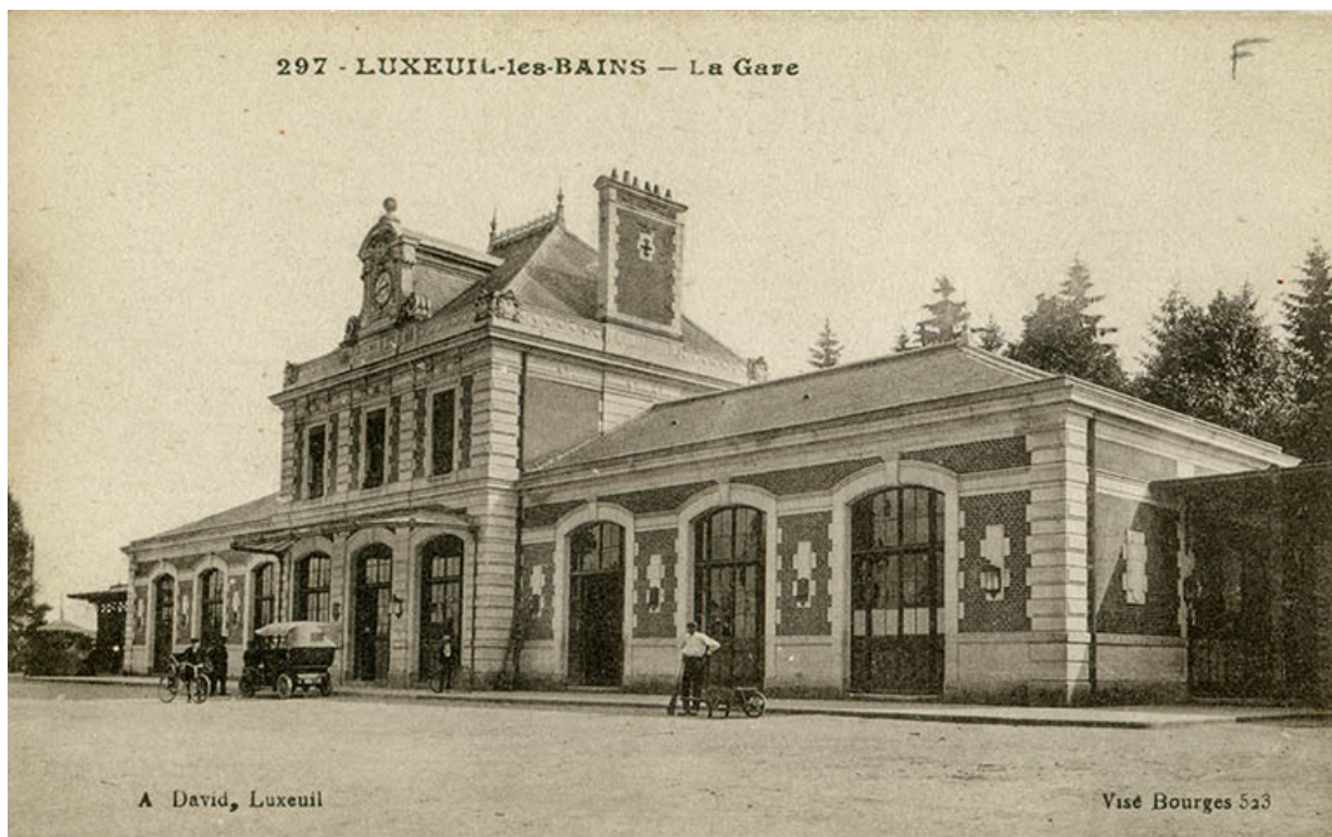
Façade, vue de trois quarts (vue ancienne).
