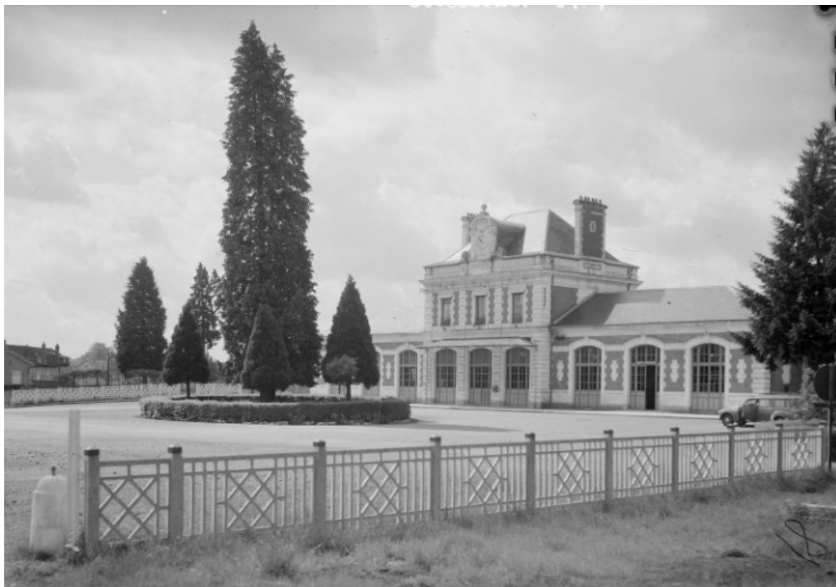
Façade, vue de trois quarts (vue ancienne).
