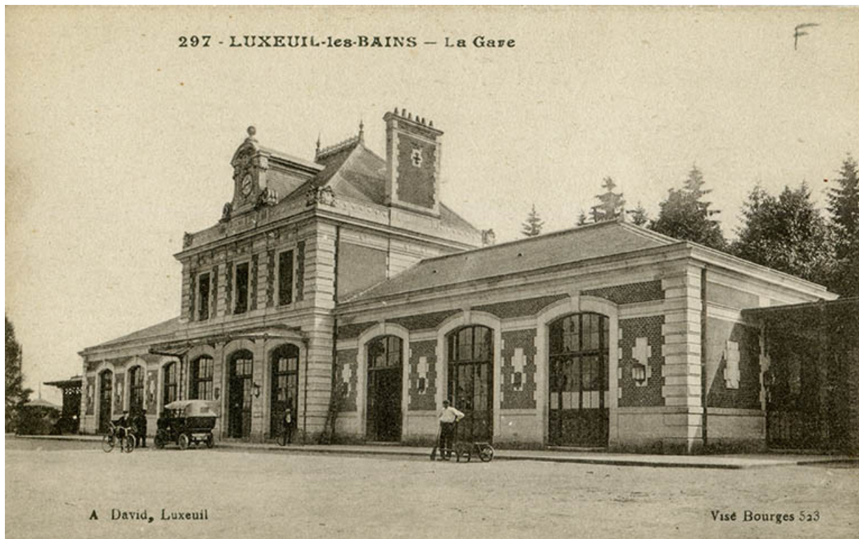
Façade, vue de trois quarts (vue ancienne).
