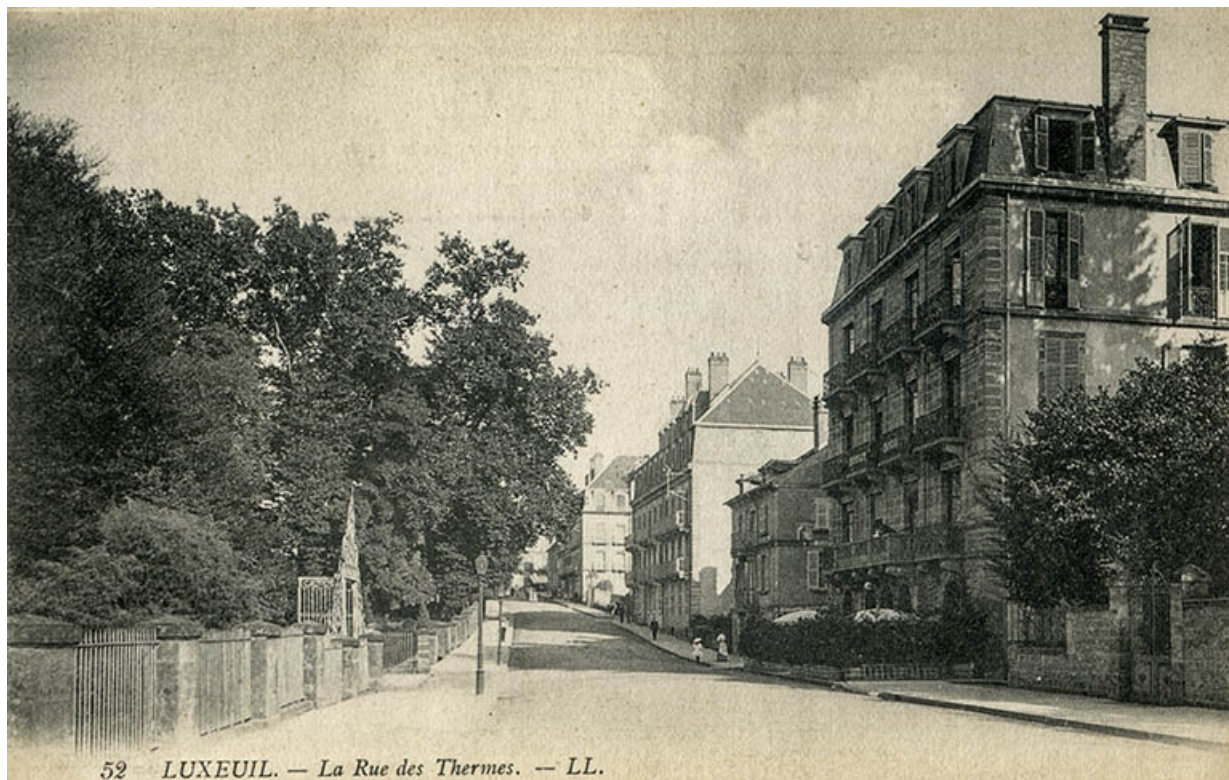
Rue des Thermes, vue en direction de l'est.
