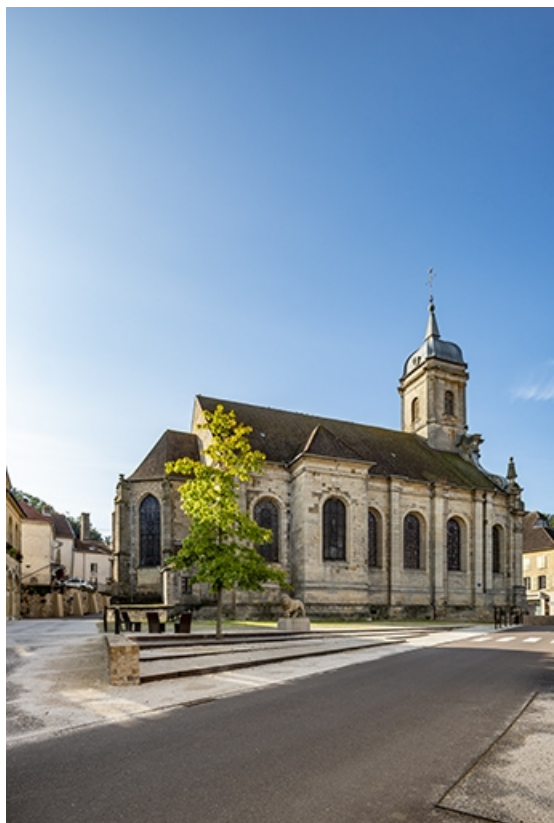
La nef, le transept et le chevet de trois quarts arrière gauche.
