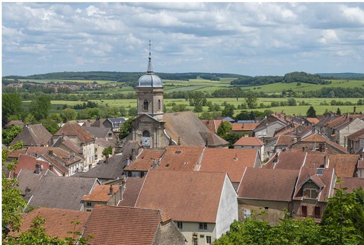
Vue générale depuis le sud-ouest.
