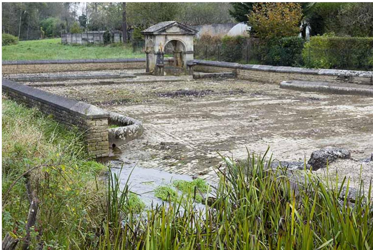
Place de la fontaine vue depuis le pont.
