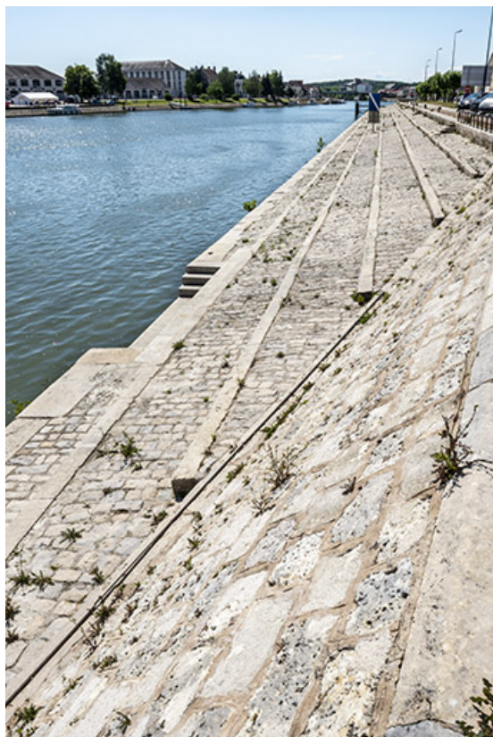
Détail de la maçonnerie du quai.
