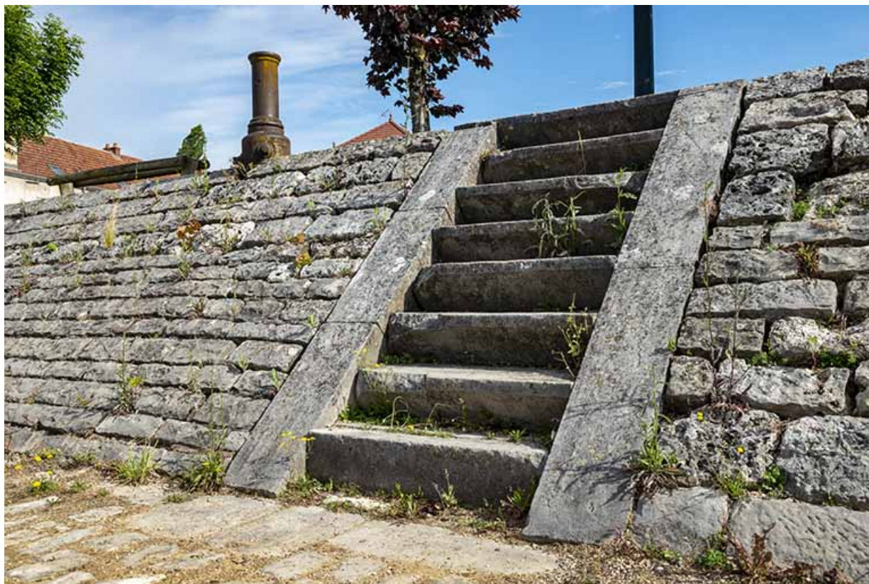
Marches pour accéder depuis le chemin de halage à la rue.
