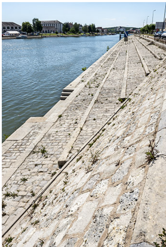
Détail de la maçonnerie du quai.
