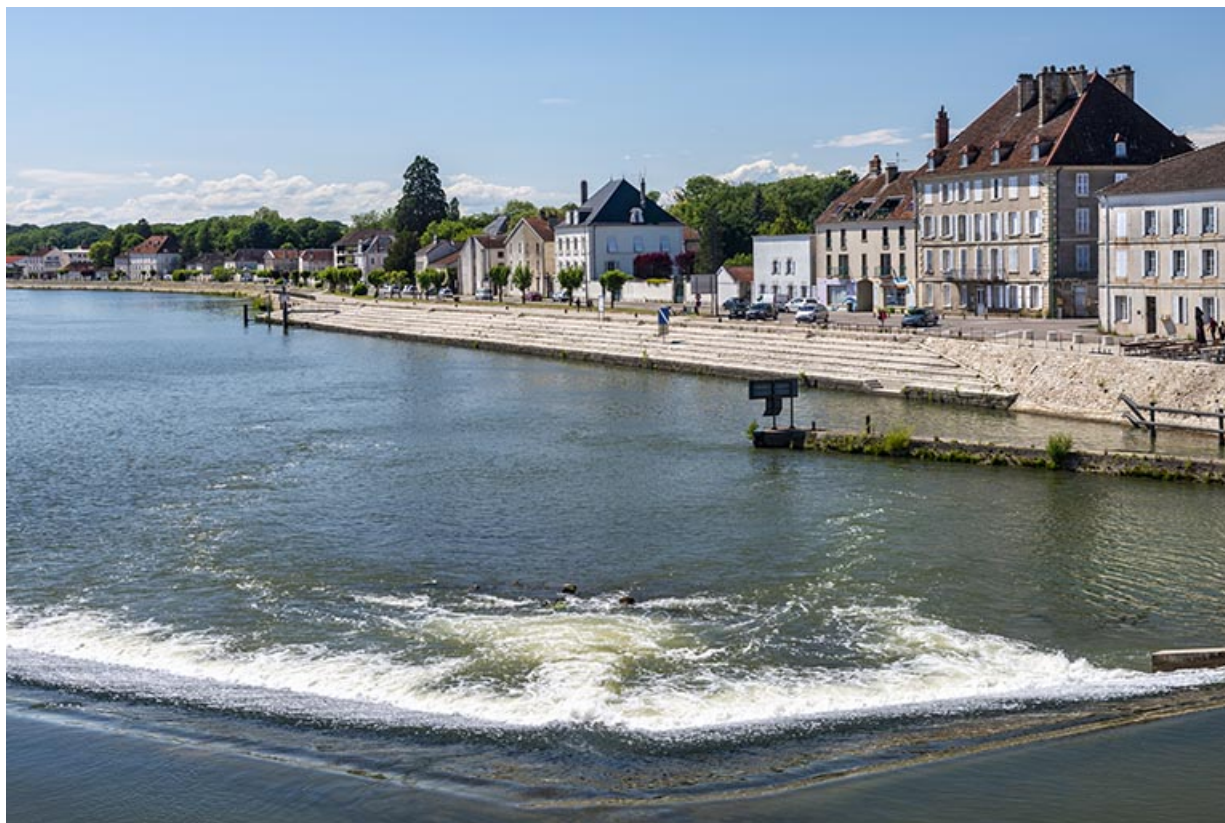
Vue générale du quai prise depuis le pont. 70, Gray quai Villeneuve
