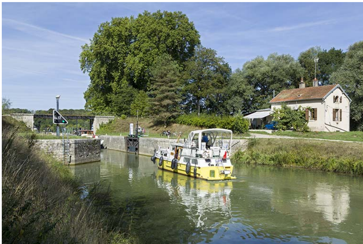
Vue générale depuis l'amont.
