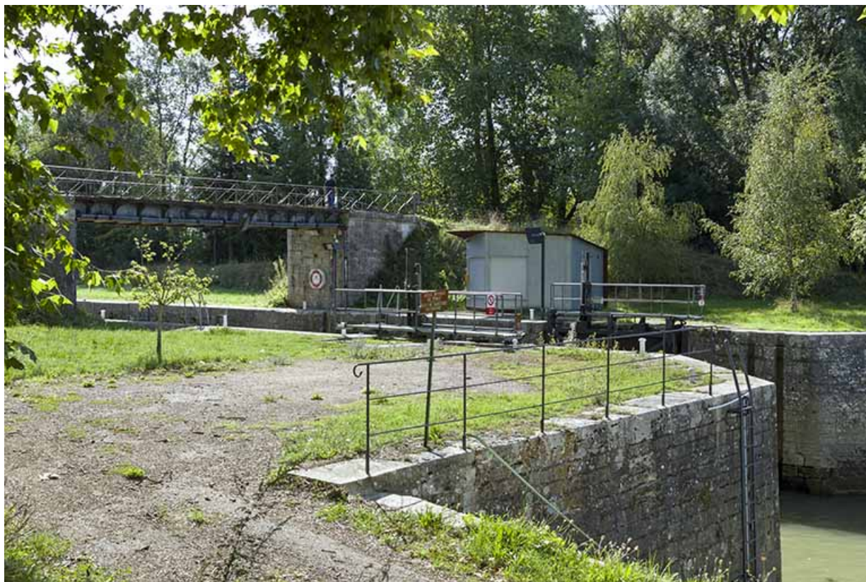
Le poste de commande de l'écluse.
