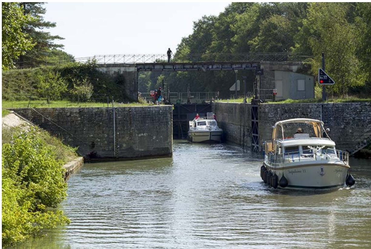
L'écluse depuis l'aval. 70, Mantoche
