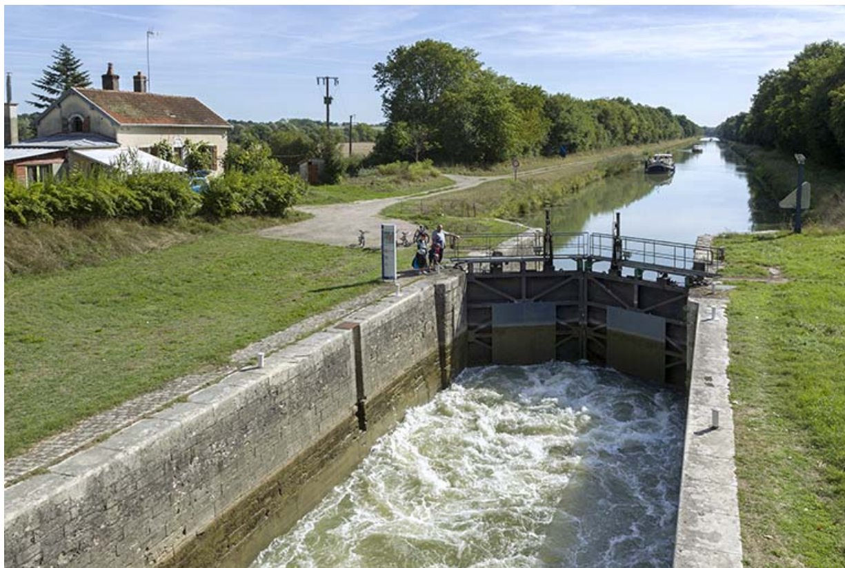
Le sas de l'écluse.
