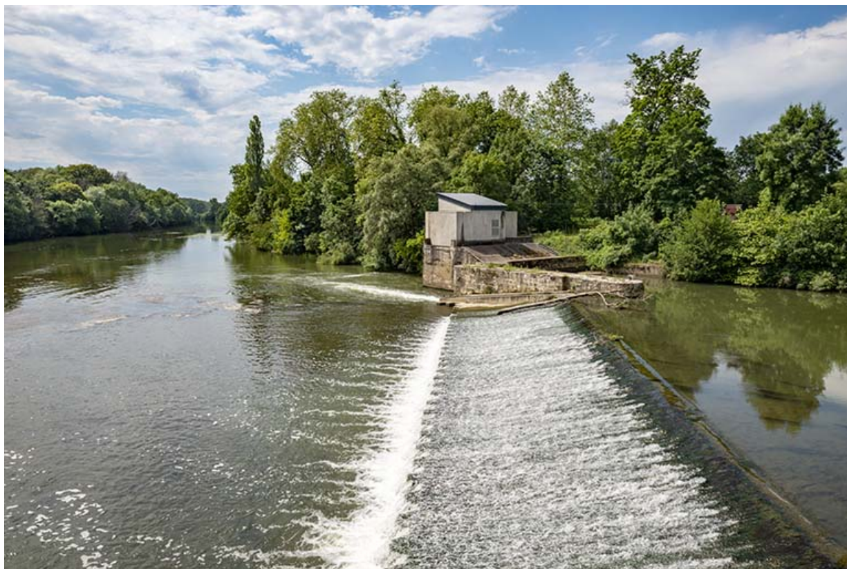
Vue générale sur le déversoir.
