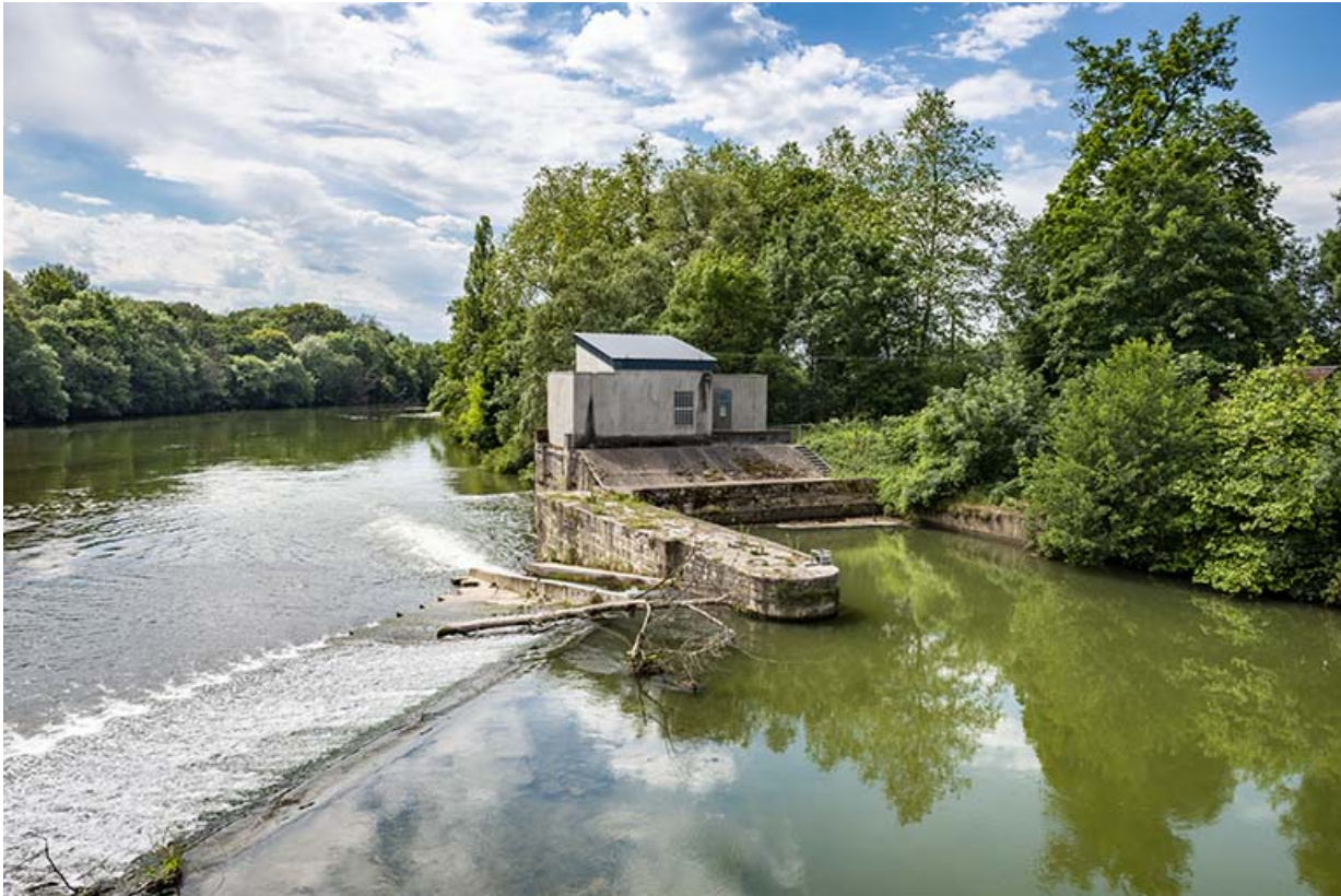
Digue maçonnée où se situait l'ancien pertuis. 70, Apremont
