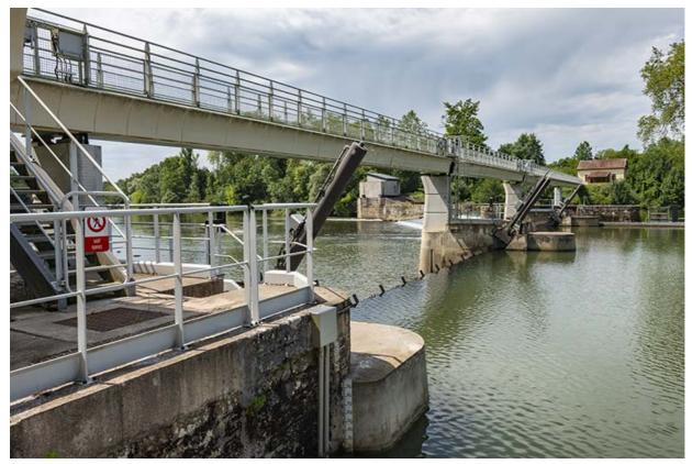
Le barrage à clapets.
