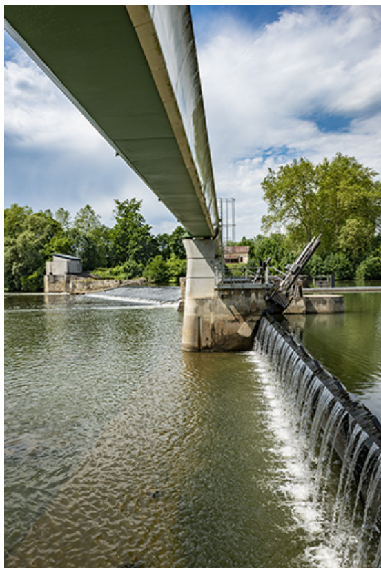
Barrage mobile d'Apremont.
