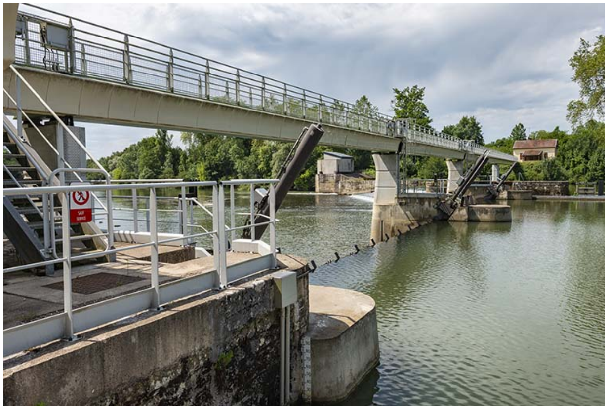
Le barrage à clapets.
