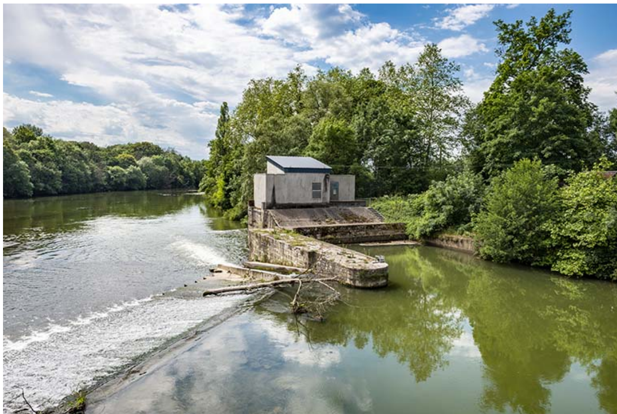
Digue maçonnée où se situait l'ancien pertuis.
