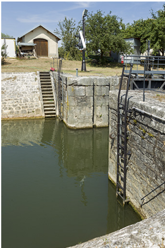
Vue sur la tête de l'écluse.
