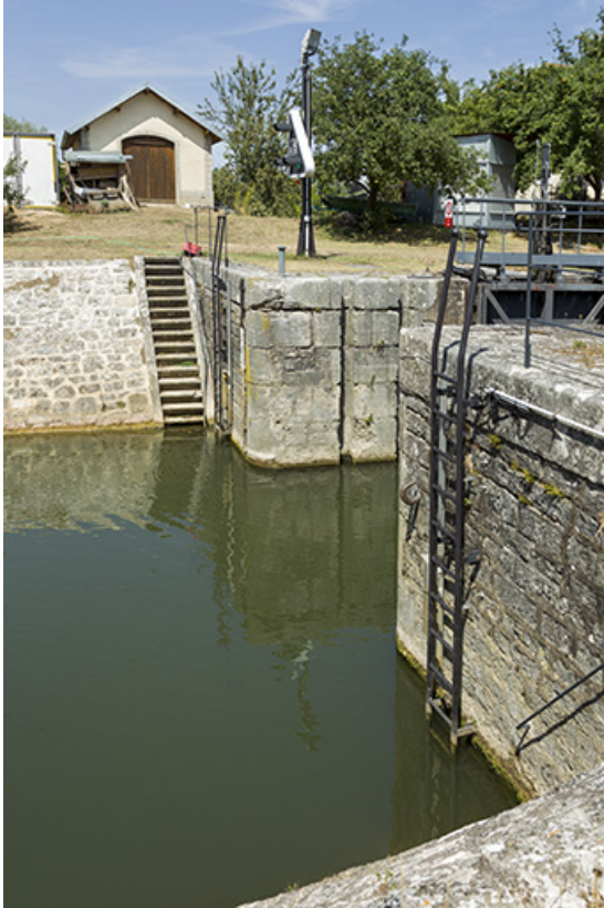
Vue sur la tête de l'écluse.
