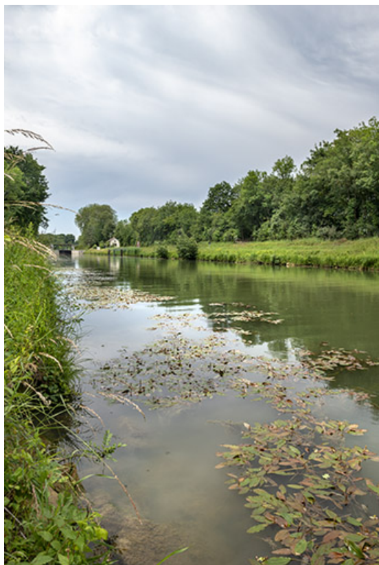
le canal de navigation, vue vers l'aval.
