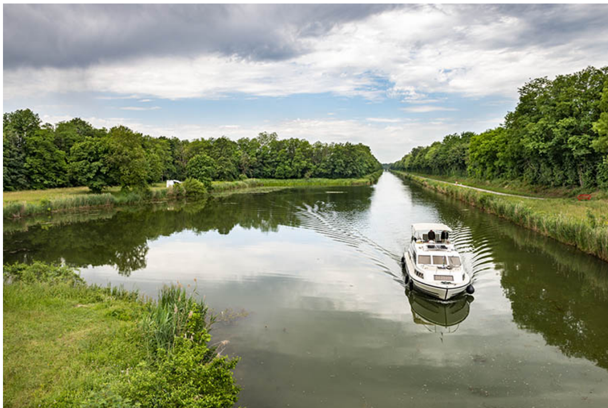
Vue aval de la dérivation avec la gare d'eau. 70, Apremont
