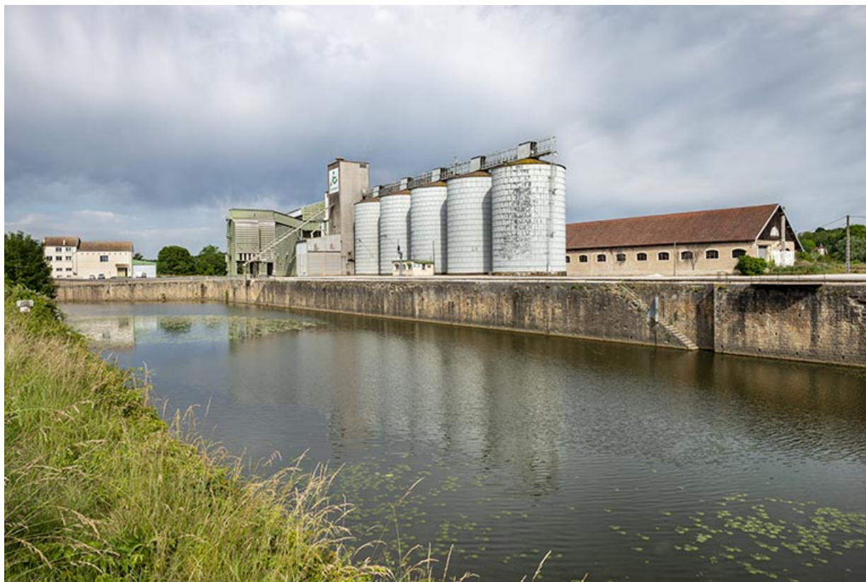
Bassin de l'ancienne gare fluviale.
