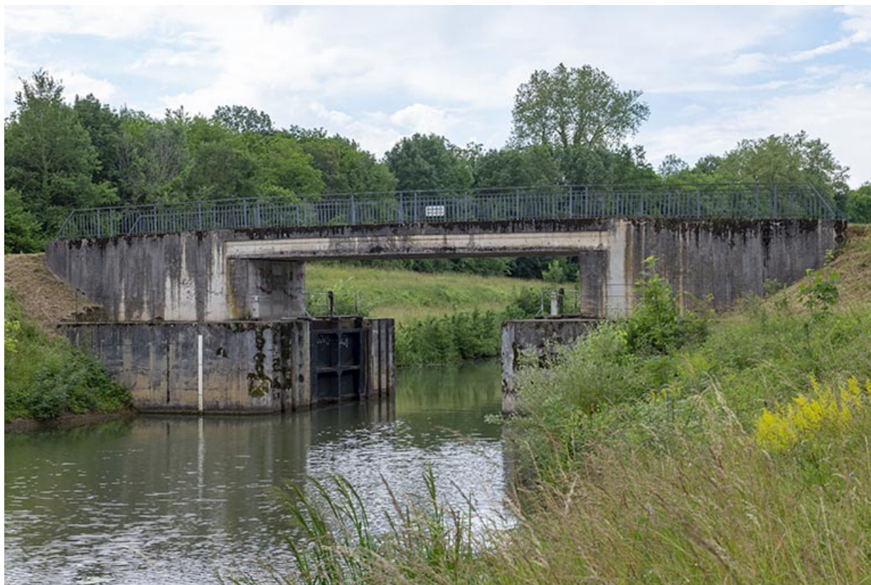
La porte de garde protégeant la dérivation.
