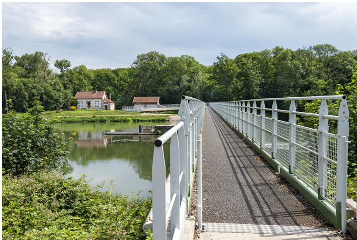
Barrage d'Apremont et la maison du barragiste sur la rive opposée. 70, Apremont
