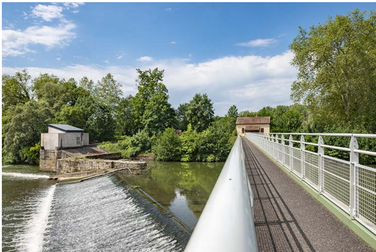
Barrage d'Apremont, vue depuis la passerelle. 70, Apremont
