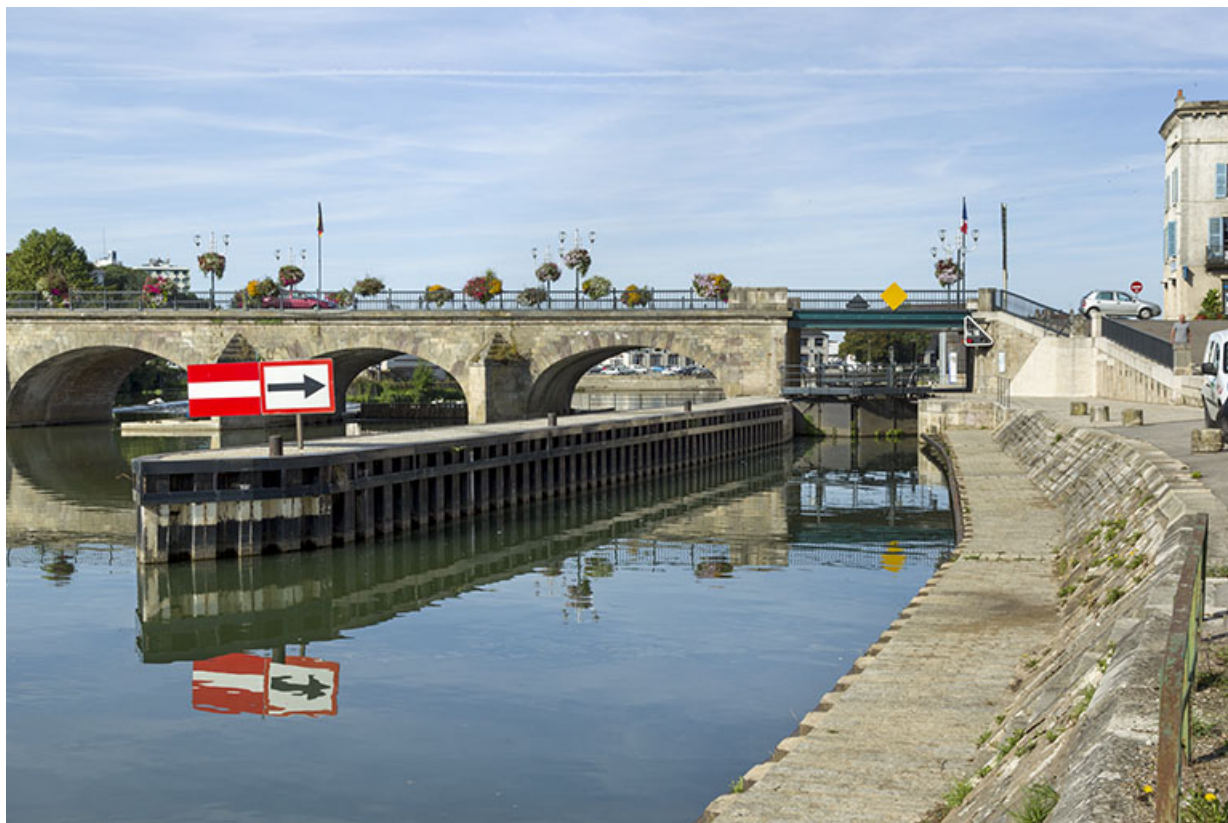
L'écluse, vue depuis l'amont.
