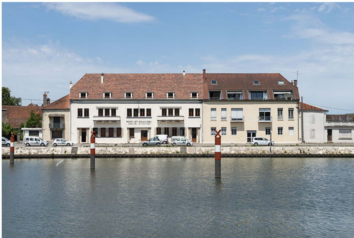
La subdivision, vue de la façade antérieure avec le quai Vergy. 70, Gray
