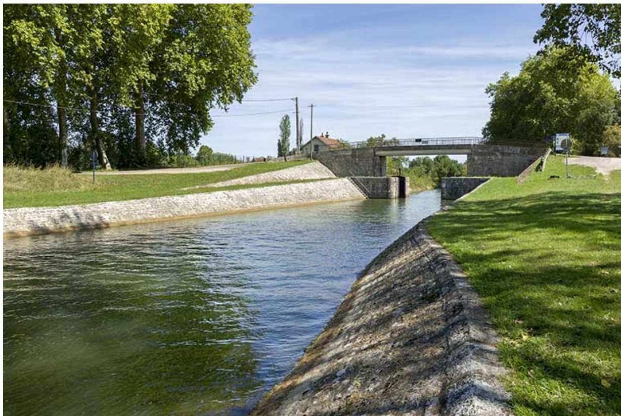
Vue depuis l'aval de la porte de garde et la maison du barragiste en arrière-plan. 70, Rigny
