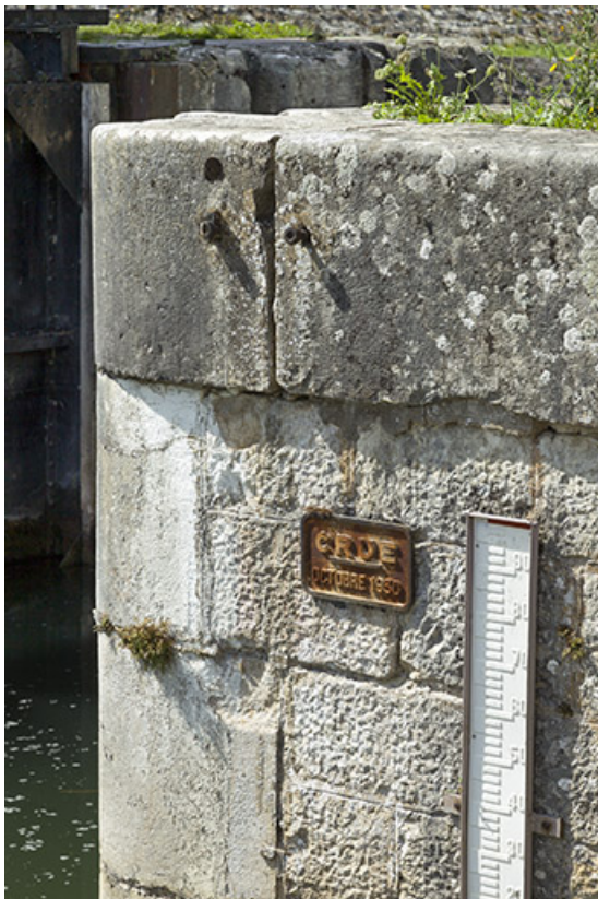
Repère de crue et échelle limnimétrique, porte de garde. 70, Rigny
