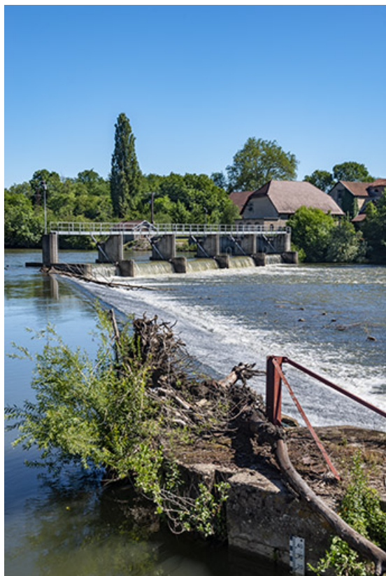
Culée du barrage.
