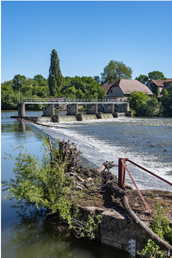
Culée du barrage.
