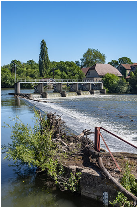
Culée du barrage.
