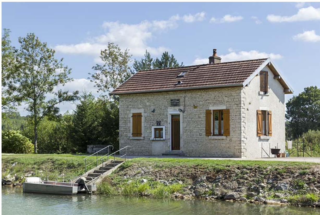
La maison de l'éclusier.
