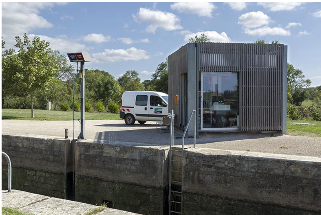
Poste de commande. 70, Savoyeux
