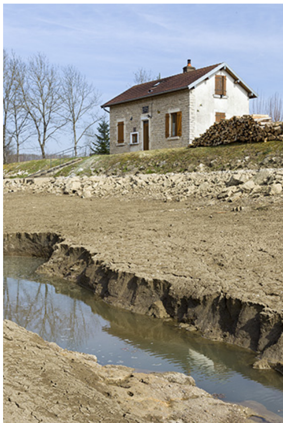
Le chenal de navigation mis hors d'eau.
