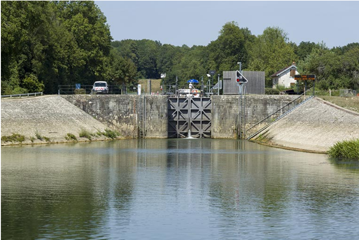
Vue aval, avec les perrés maçonnés.
