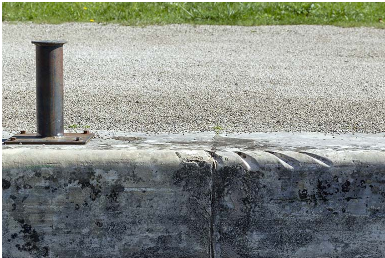
Traces des cordes qui servaient à amarrer les péniches.
