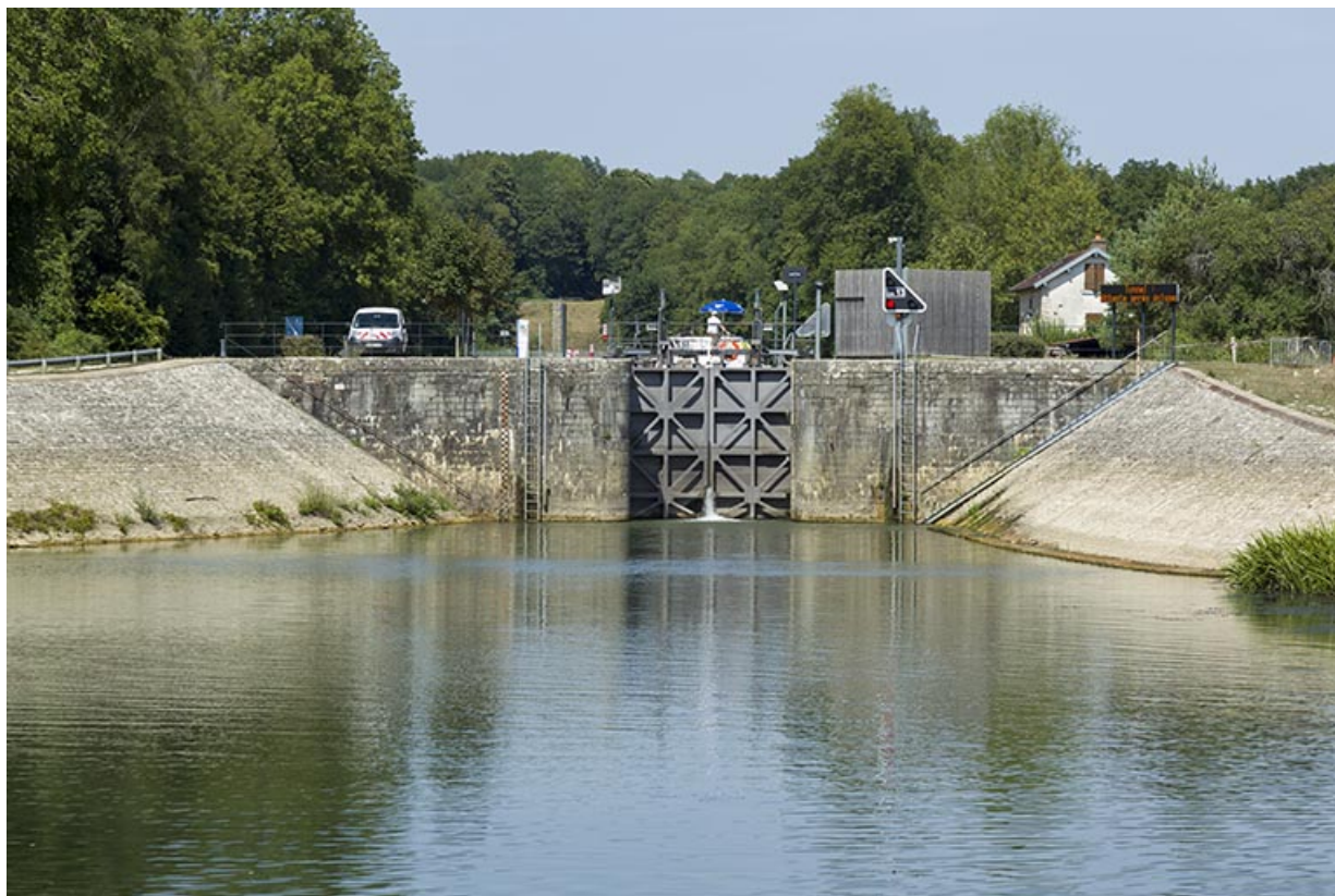
Vue aval, avec les perrés maçonnés.
