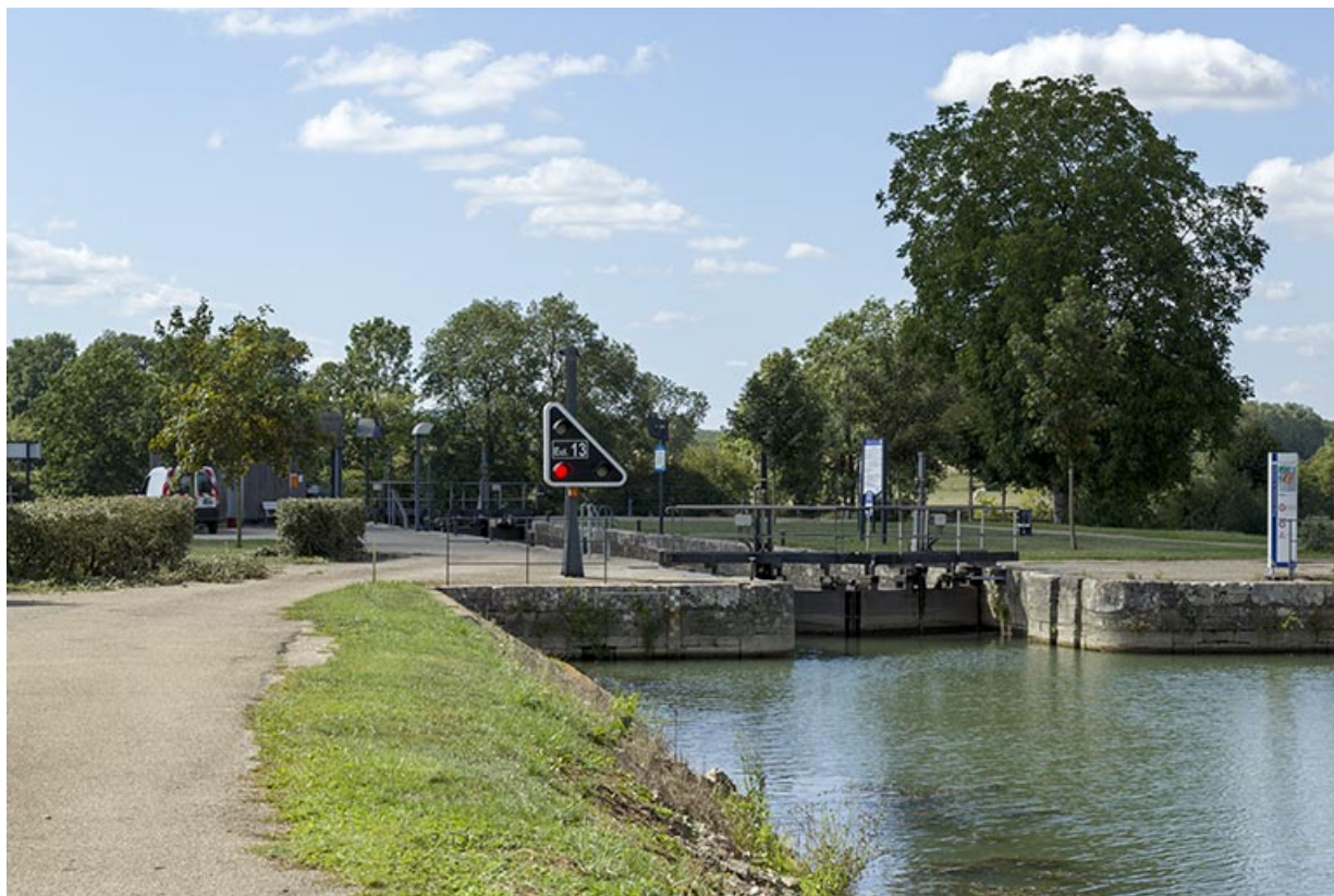
Entrée amont de l'écluse.
