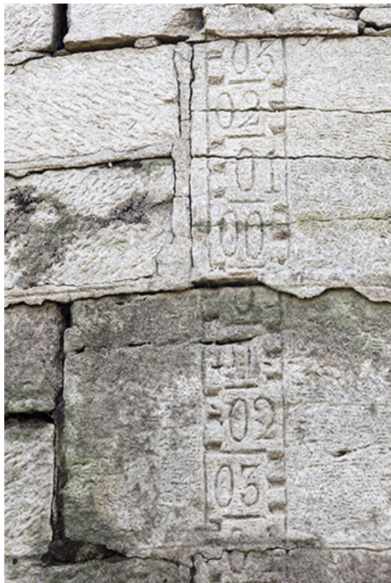
Ancienne échelle limnimétrique.
