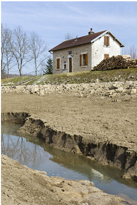
Le chenal de navigation mis hors d'eau.
