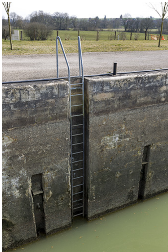
Bajoyer de l'écluse.
