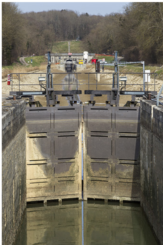
Le sas de l'écluse.
