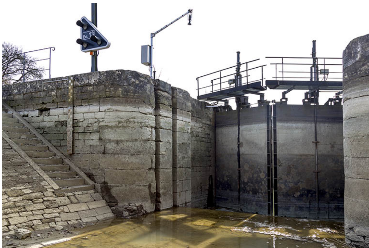
Vue sur la tête amont avec l'estacade de guidage et la porte munie de ses vantaux. 70, Savoyeux
