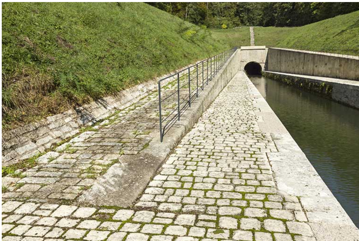
Pavage du chemin de halage.
