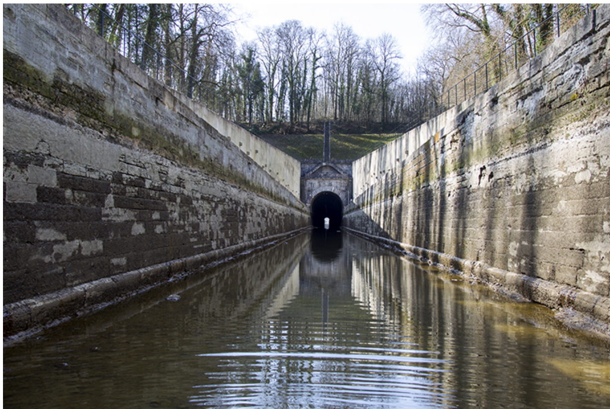
Le souterrain depuis la cuvette du canal. 70, Savoyeux
