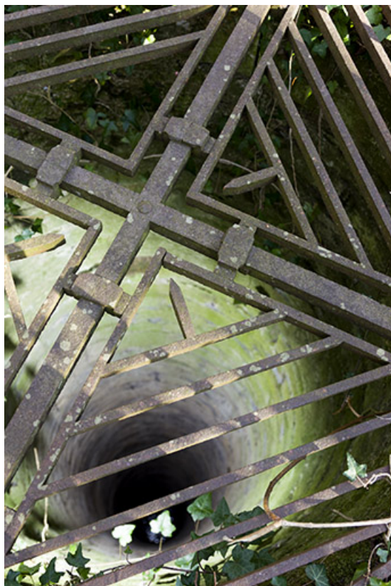
Vue du puits depuis l'orifice.
