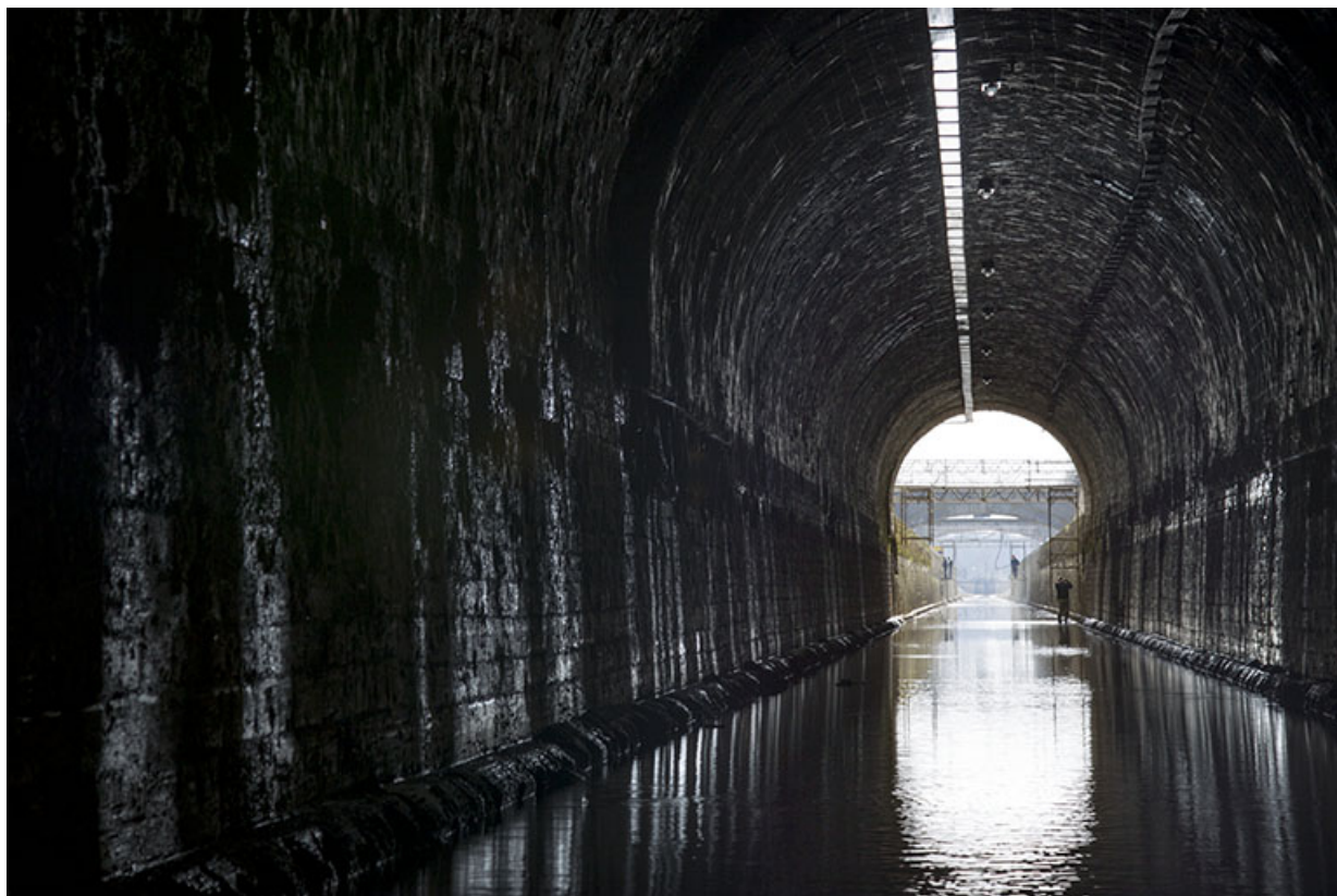
L'entrée aval. 70, Savoyeux
