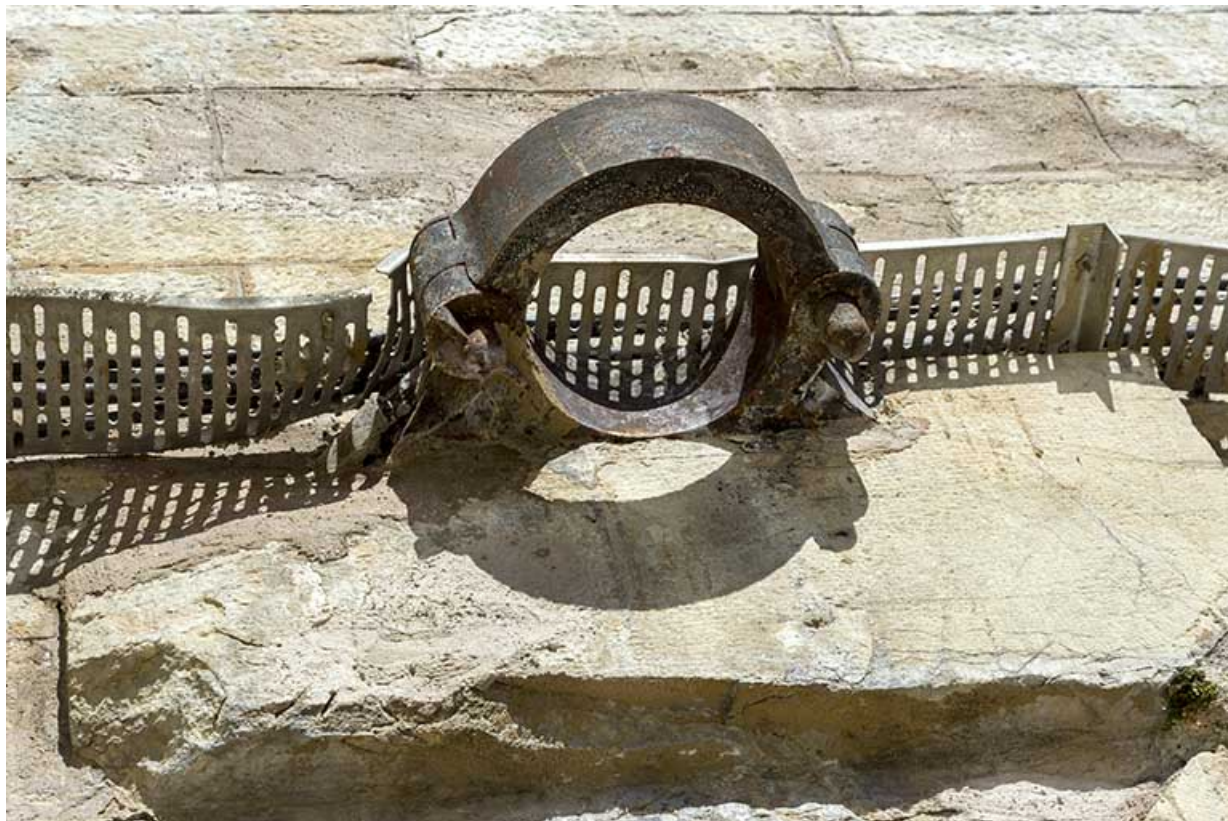
Gond d'une des anciennes portes du tunnel (entrée aval). 70, Savoyeux
