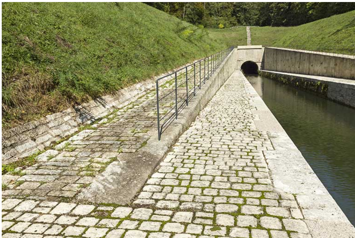
Pavage du chemin de halage.
