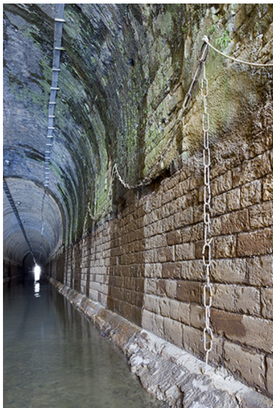
Mur latéral du tunnel maçonné.
