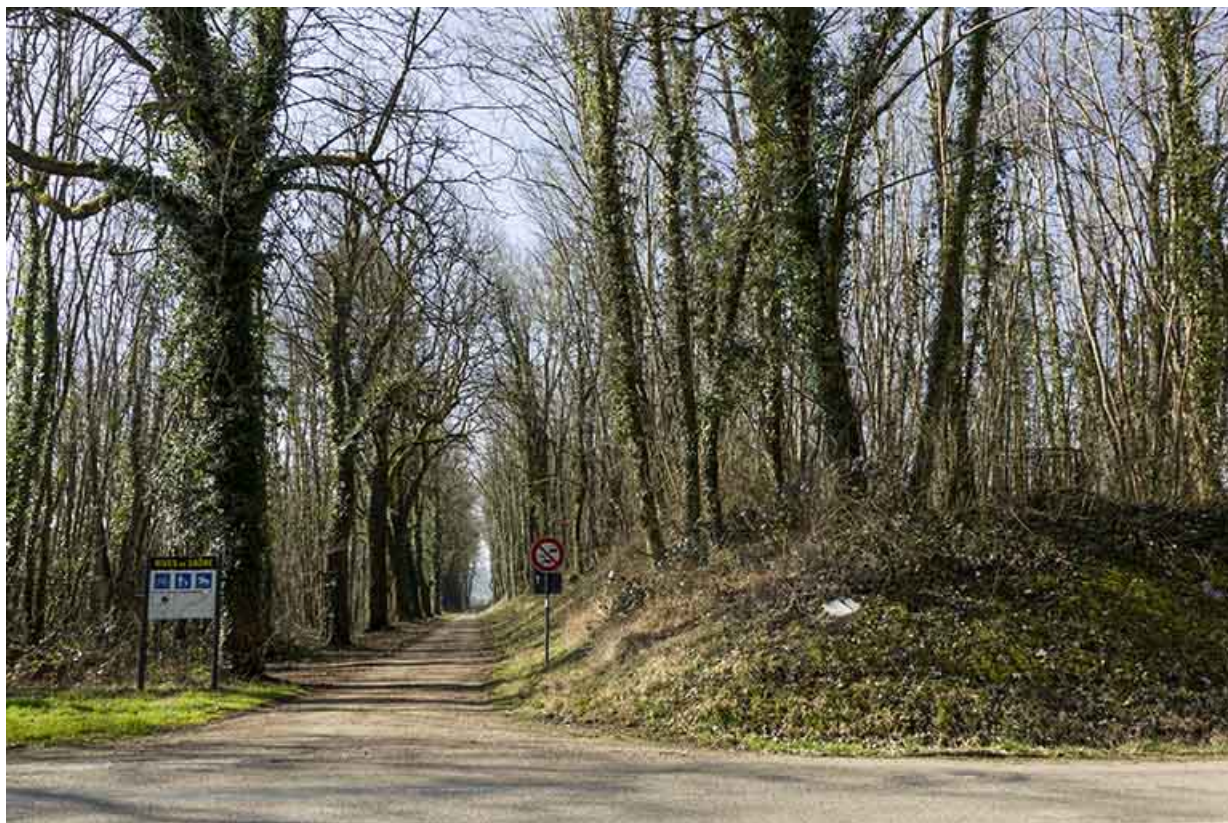
Remblai au dessus de l'ouvrage.
