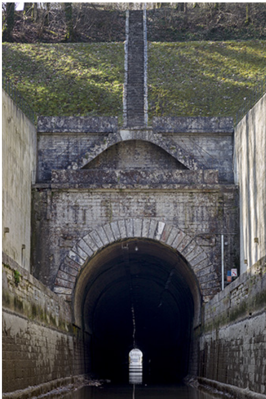
Entrée amont du souterrain.
