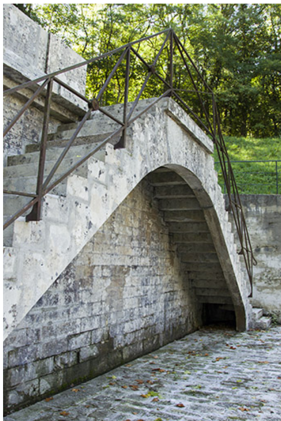
Escalier double, terrasse surplombant l'entrée du souterrain. 70, Savoyeux
