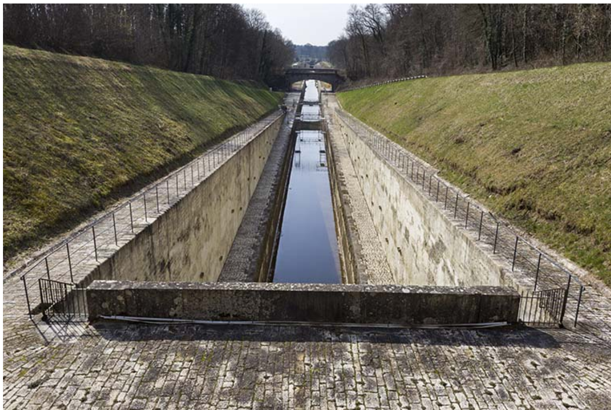
Vue depuis la terrasse surplombant l'entrée aval. 70, Savoyeux
