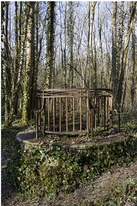
Puits d'aérage du tunnel.
