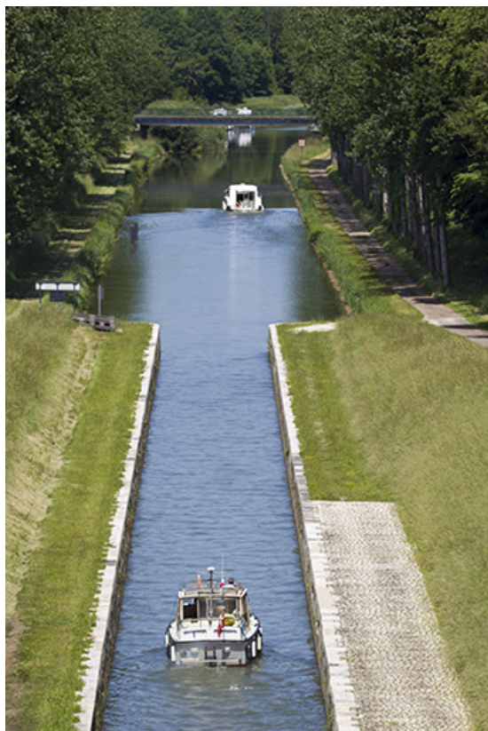
Vue amont du canal de navigation.
