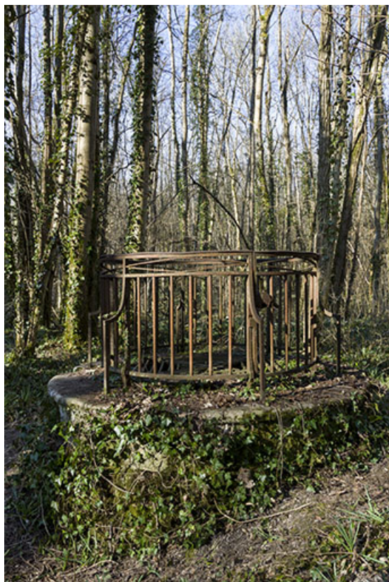
Puits d'aérage du tunnel.
