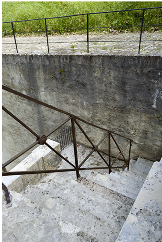
L'escalier et le garde-corps.
