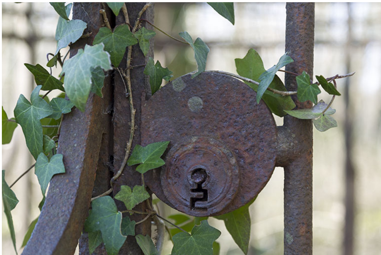
Serrure du garde-corps. 70, Savoyeux
