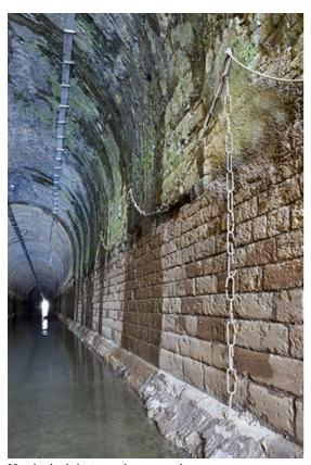
Mur latéral du tunnel maçonné.
