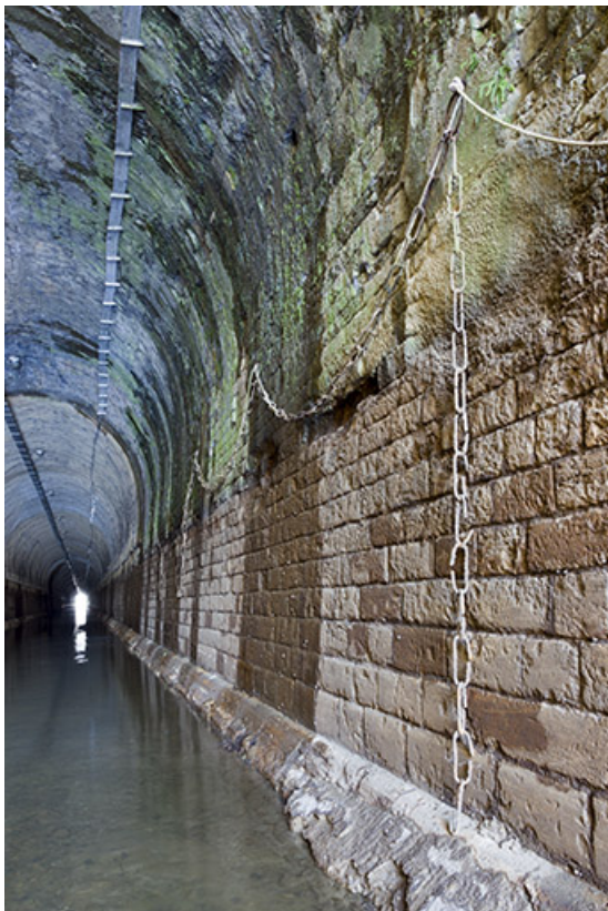
Mur latéral du tunnel maçonné.
