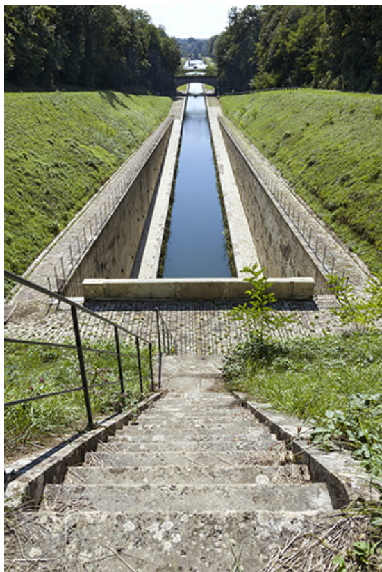
Le canal de navigation, partie aval.
