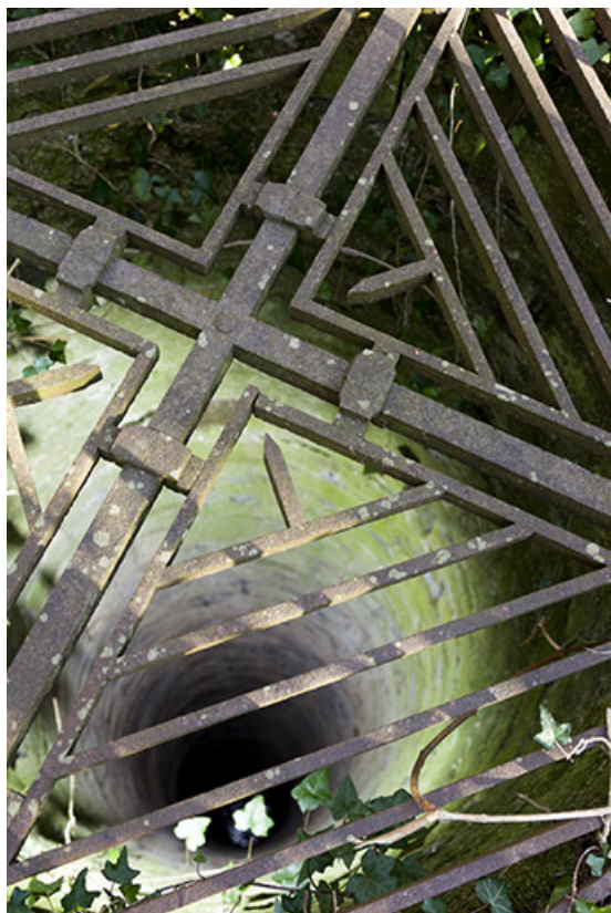
Vue du puits depuis l'orifice.
