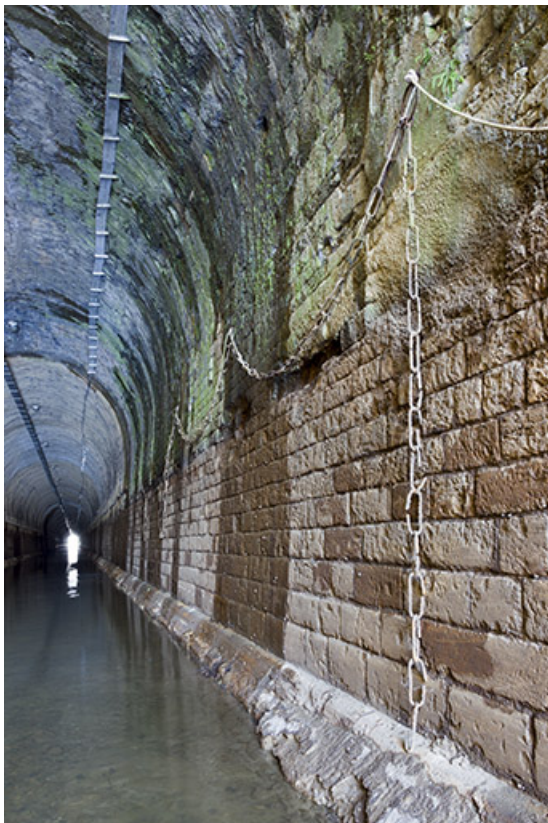
Mur latéral du tunnel maçonné.
