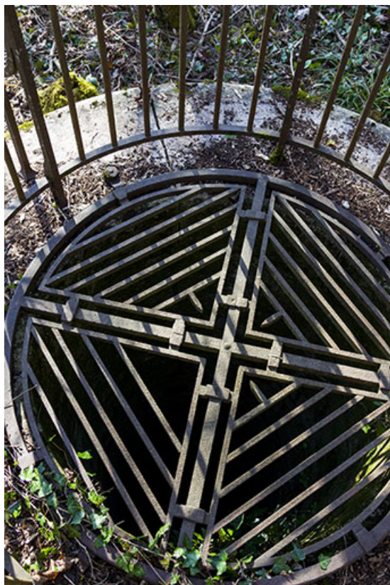
Grille de protection posée sur la margelle.
