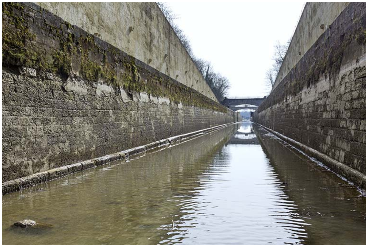
Le canal, vue prise depuis le radier.
