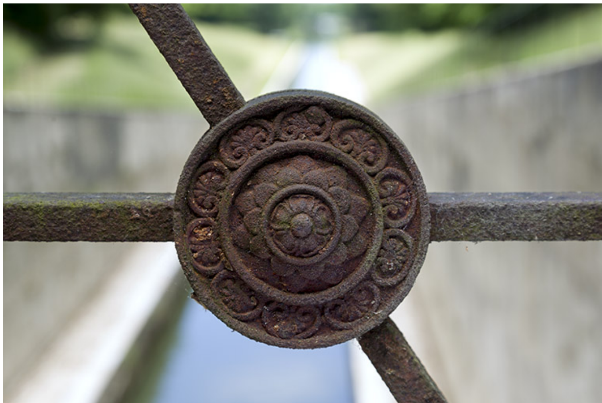
Détail, garde-corps de l'escalier.
