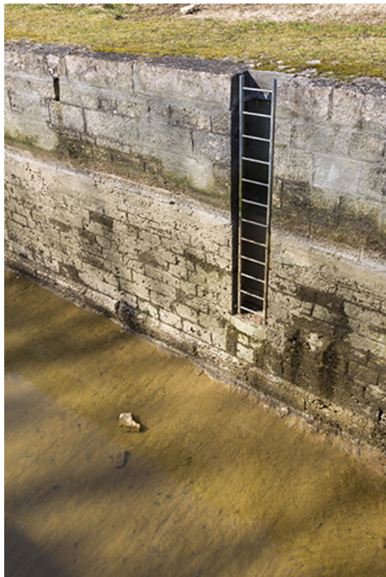
Mur latéral du canal.
