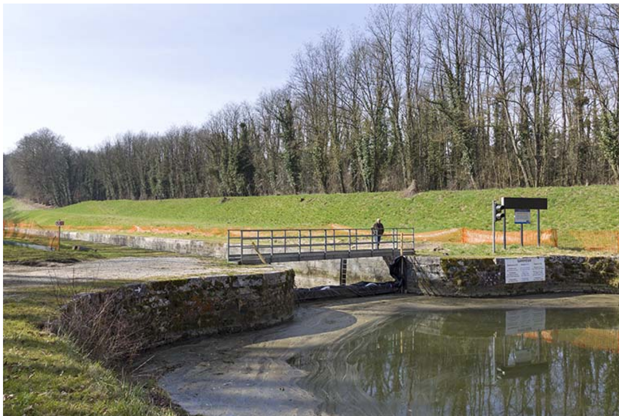
Entrée amont menant au tunnel.
