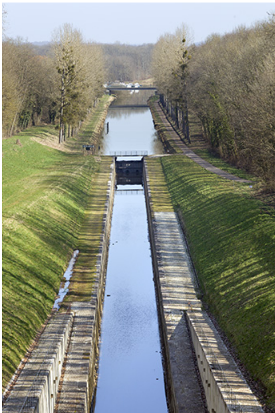
Vue vers l'amont depuis la terrasse surplombant l'entrée du tunnel. 70, Savoyeux
