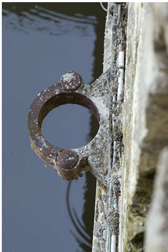
Gond d'une des anciennes portes du tunnel (entrée amont). 70, Savoyeux
