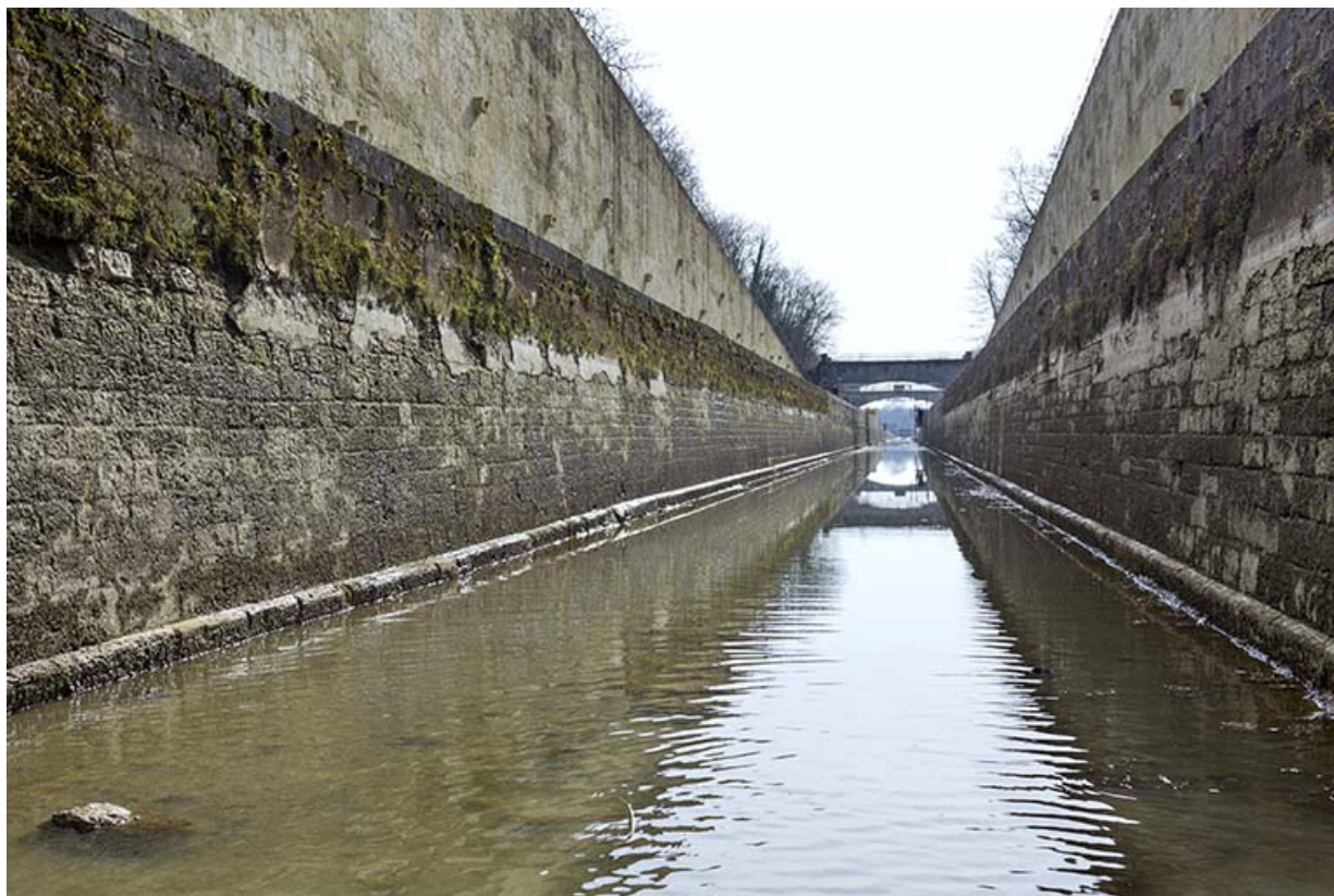
Le canal, vue prise depuis le radier.
