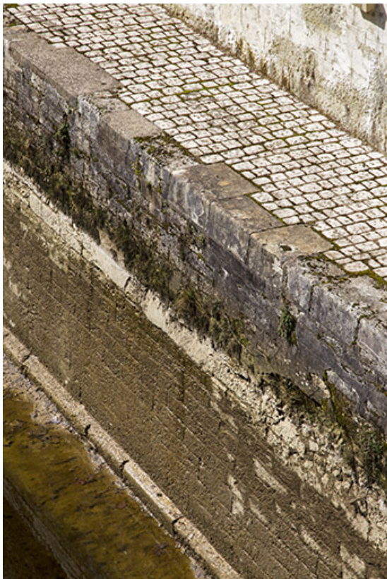
Banquette de halage, mur latéral canal et radier. 70, Savoyeux
