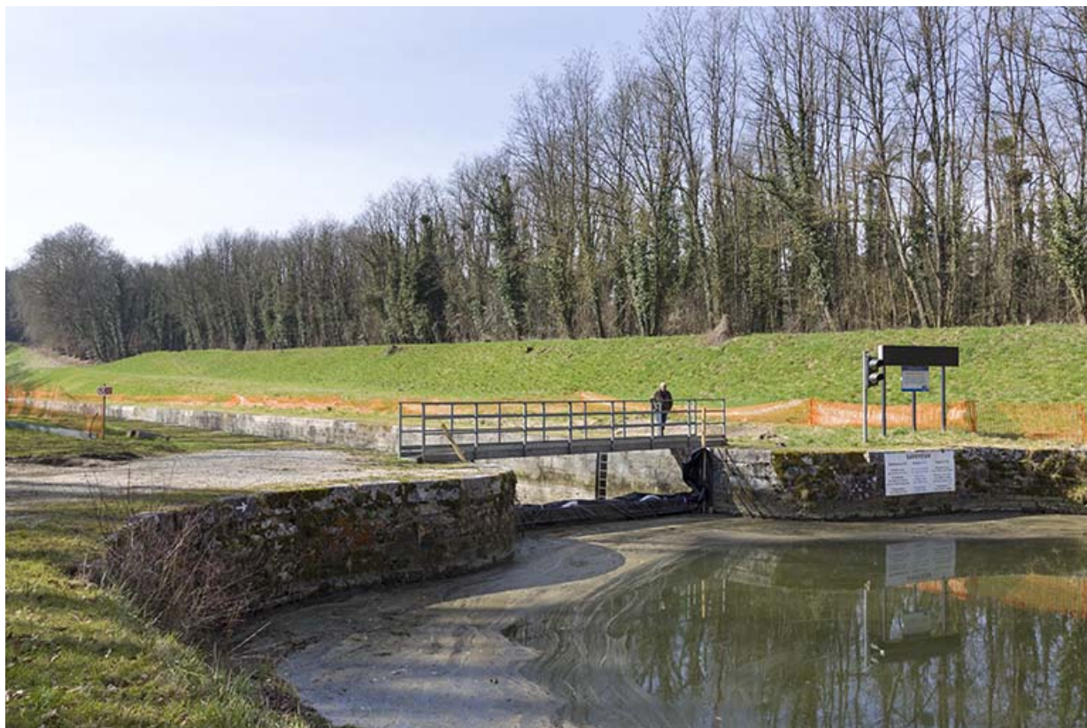
Entrée amont menant au tunnel.
