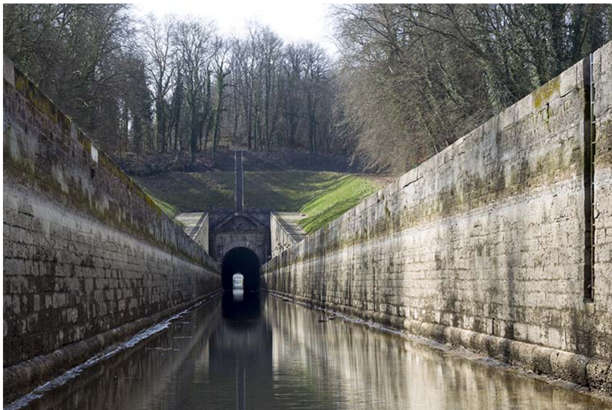
Vue d'ensemble : le canal de navigation, le souterrain et l'escalier surplombant la tête d'amont. 70, Savoyeux
