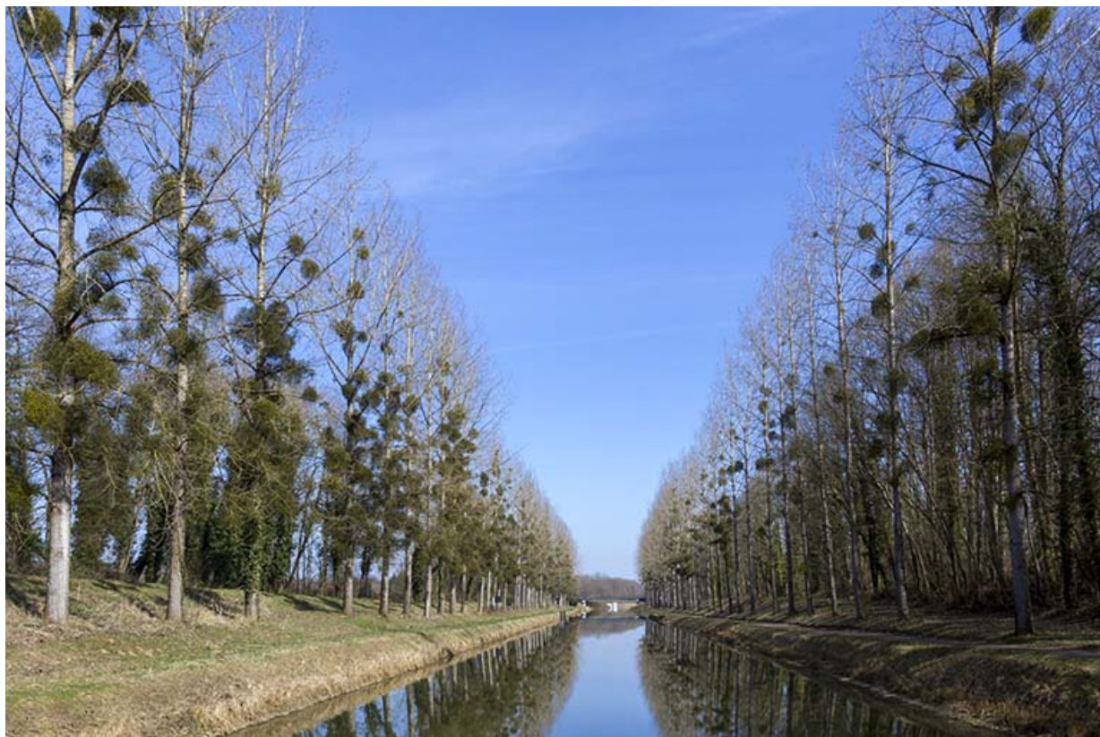
Vue vers l'amont depuis la porte de garde. 70, Savoyeux
