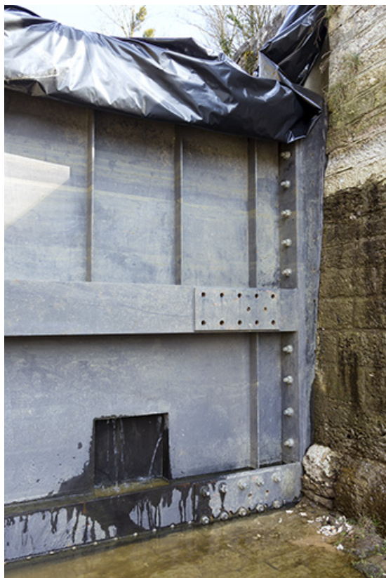
Détail du batardeau.
