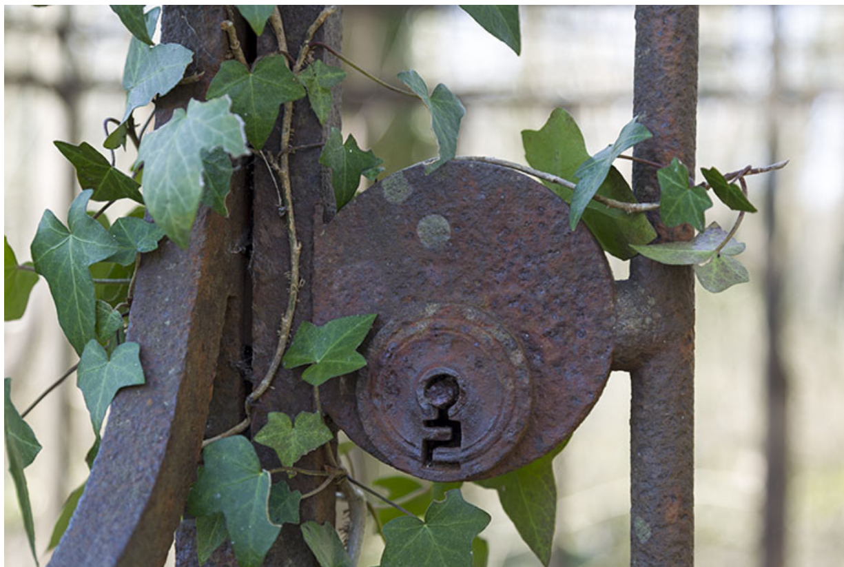
Serrure du garde-corps. 70, Savoyeux
