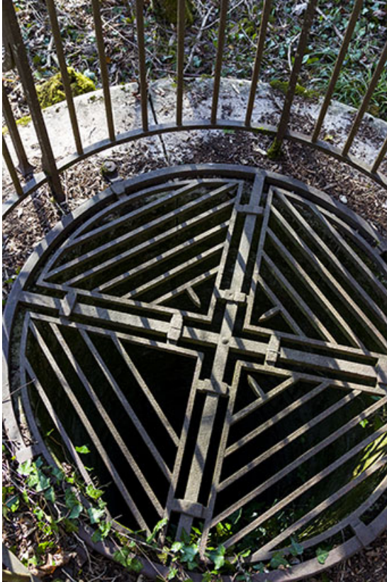
Grille de protection posée sur la margelle.
