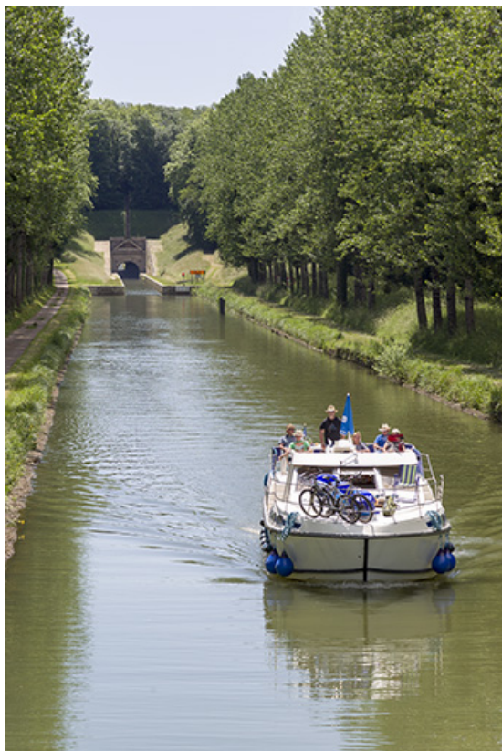
Bateau de plaisance et le tunnel en arrière-plan. 70, Savoyeux
