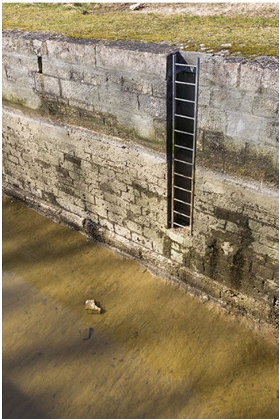
Mur latéral du canal.
