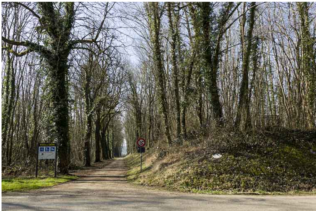
Remblai au dessus de l'ouvrage.
