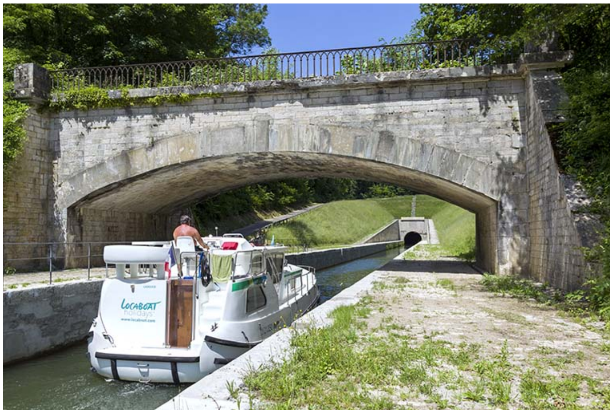
Pont ferrovier et vue de l'entrée aval du souterrain. 70, Savoyeux
