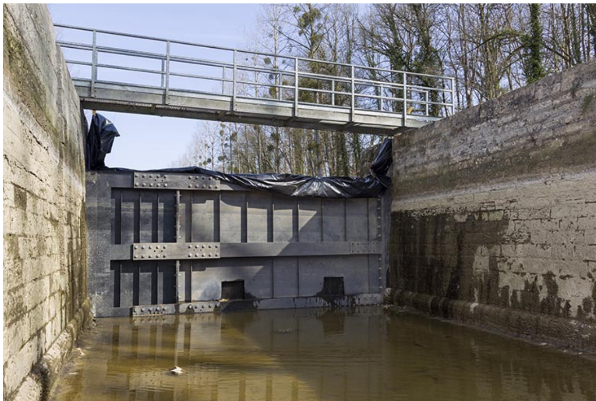
La porte de garde et le batardeau métallique. 70, Savoyeux
