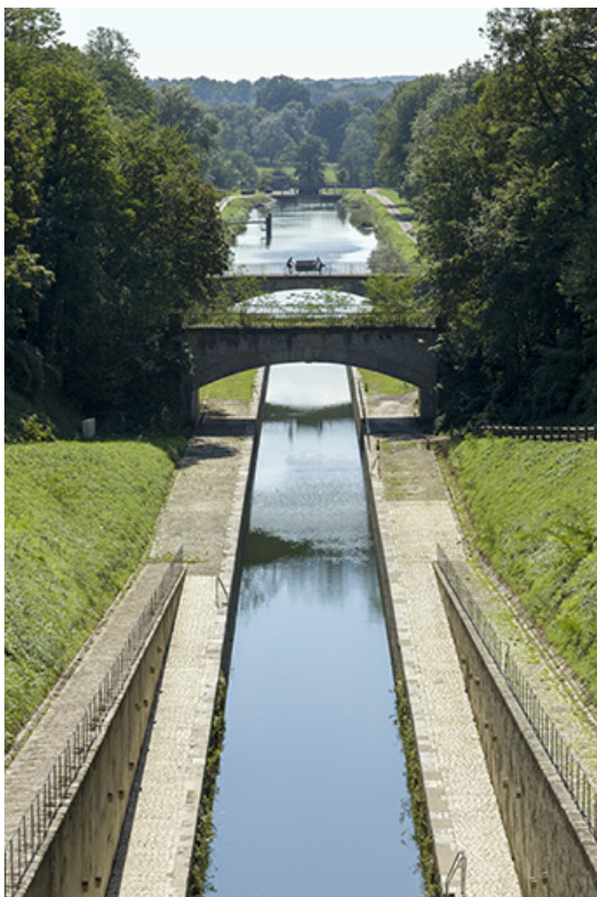
Vue aval, en direction de l'écluse.
