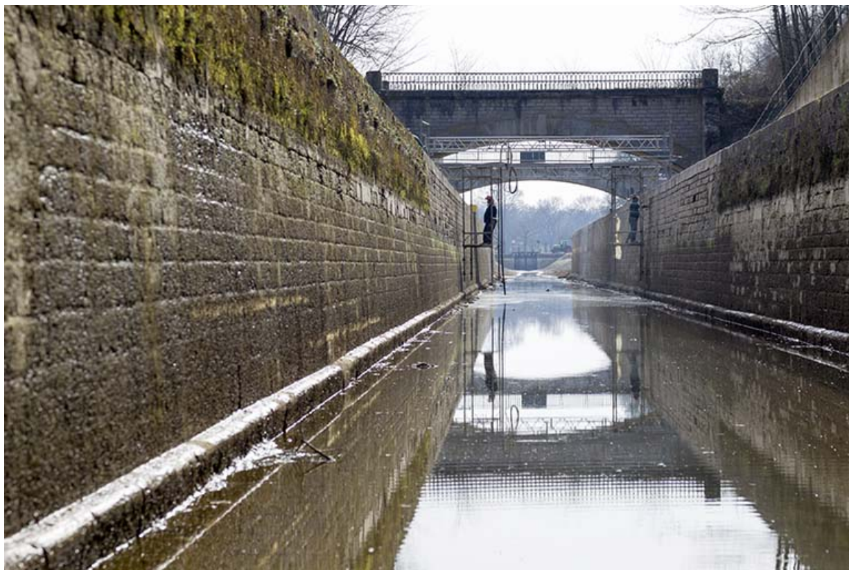
Travaux de restauration de maçonnerie en 2015.
