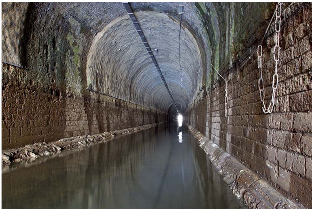
Intérieur du tunnel, vue générale.
