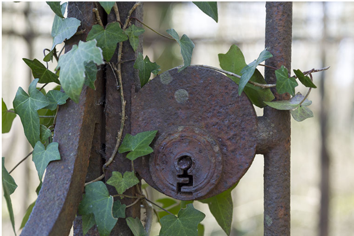
Serrure du garde-corps. 70, Savoyeux
