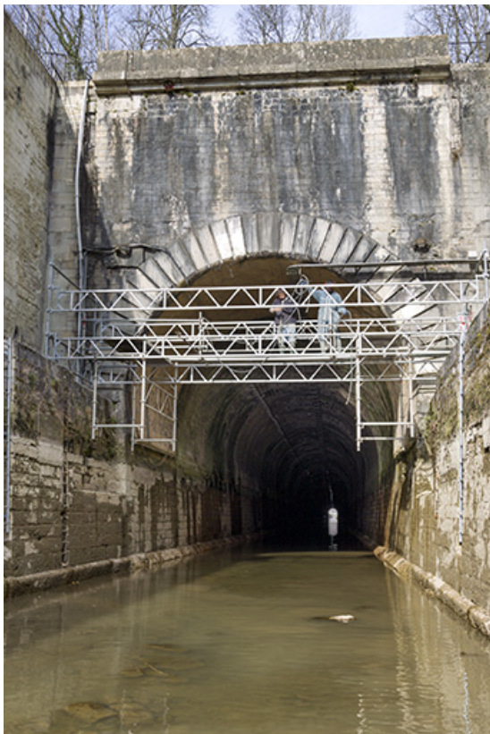
Entrée aval (restauration de la maçonnerie 2015). 70, Savoyeux
