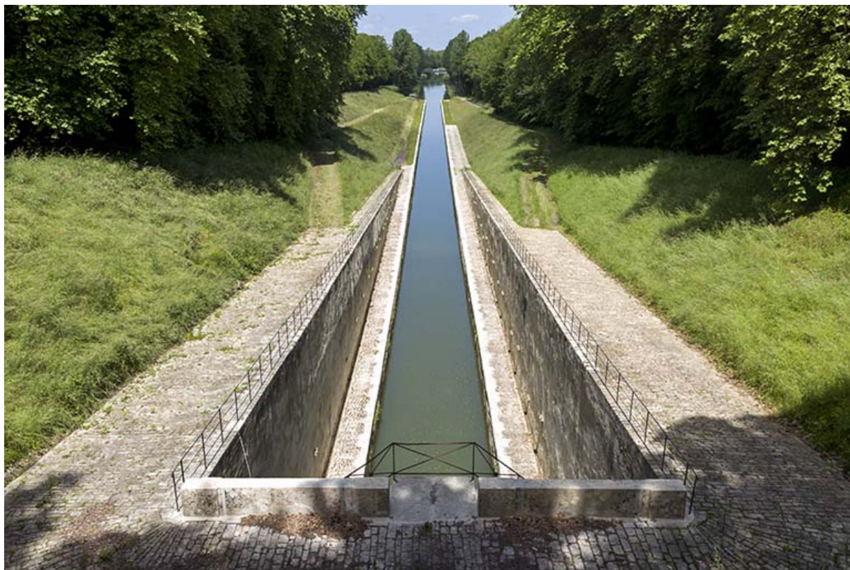
Le canal de navigation, vue amont.
