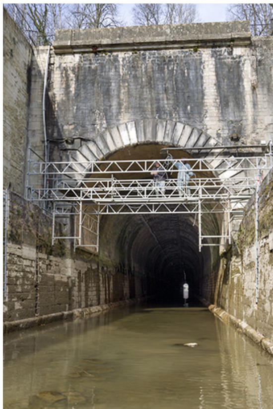
Entrée aval (restauration de la maçonnerie 2015). 70, Savoyeux
