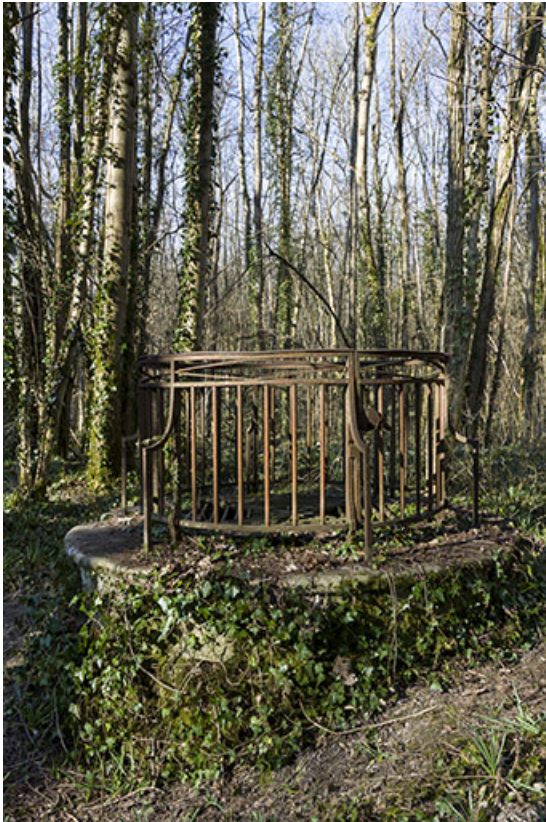
Puits d'aérage du tunnel.
