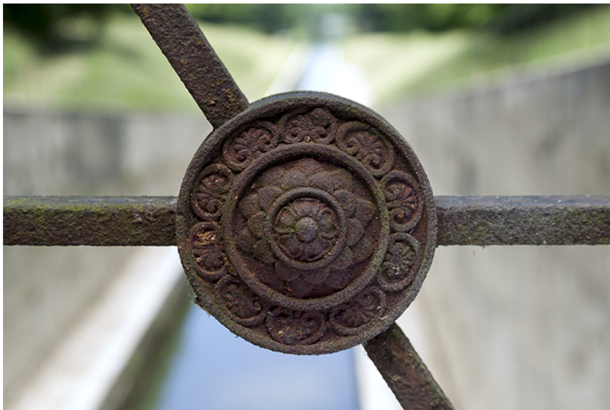
Détail, garde-corps de l'escalier. 70, Savoyeux
