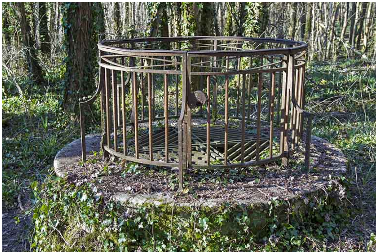
Le puits avec son mur, sa margelle et son garde-corps.
