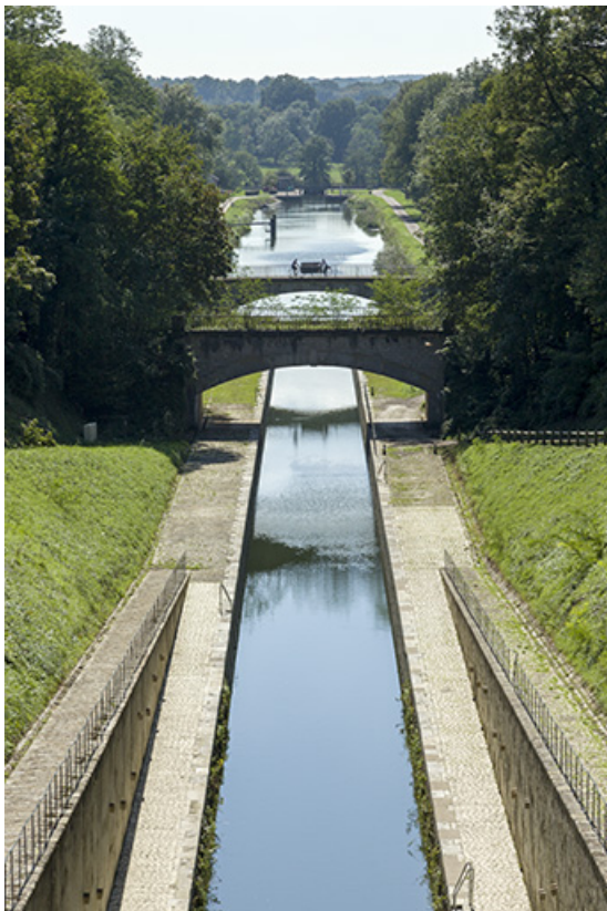
Vue aval, en direction de l'écluse.
