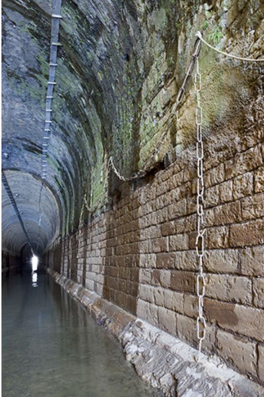
Mur latéral du tunnel maçonné.
