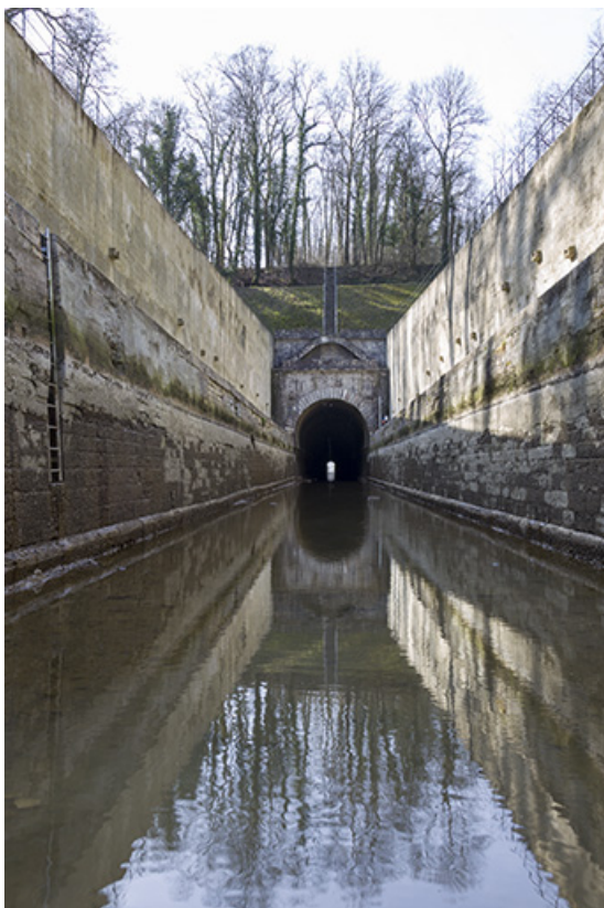
Le souterrain depuis la cuvette du canal.
