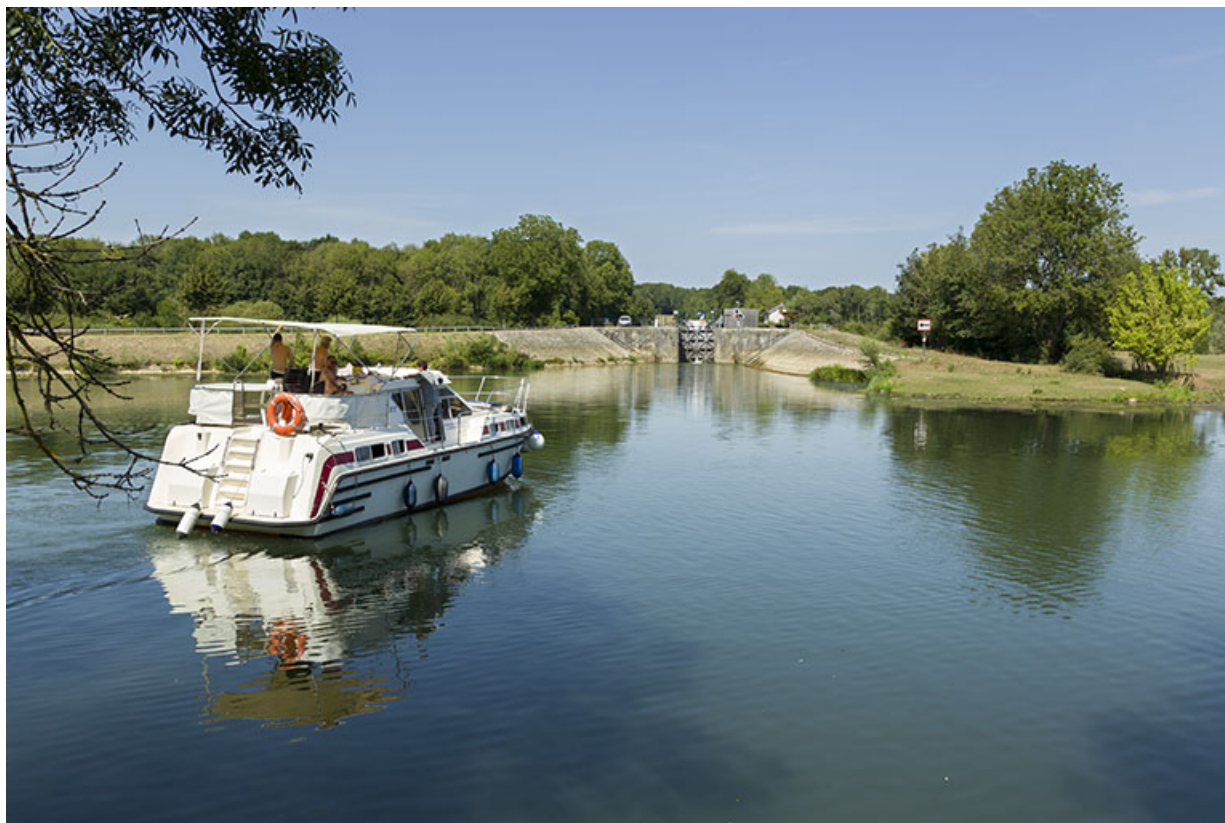
Entrée aval du bief de Savoyeux.
