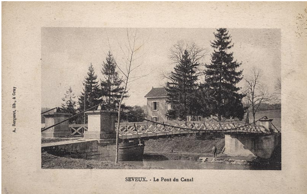
Seveux - Le Pont du Canal, carte postale (et la maison de l'éclusier en arrière-plan).
