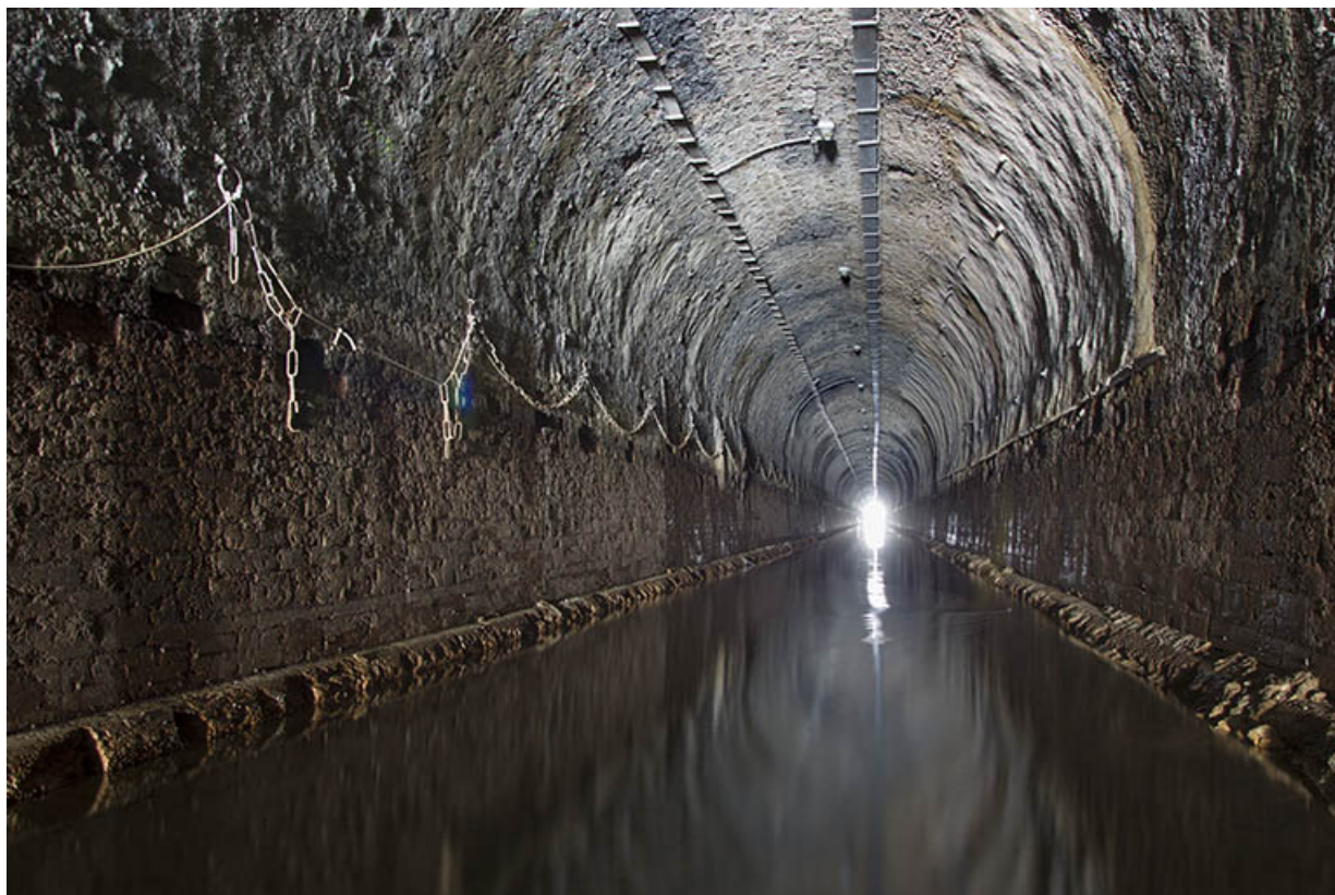
Intérieur du tunnel, vue générale.
