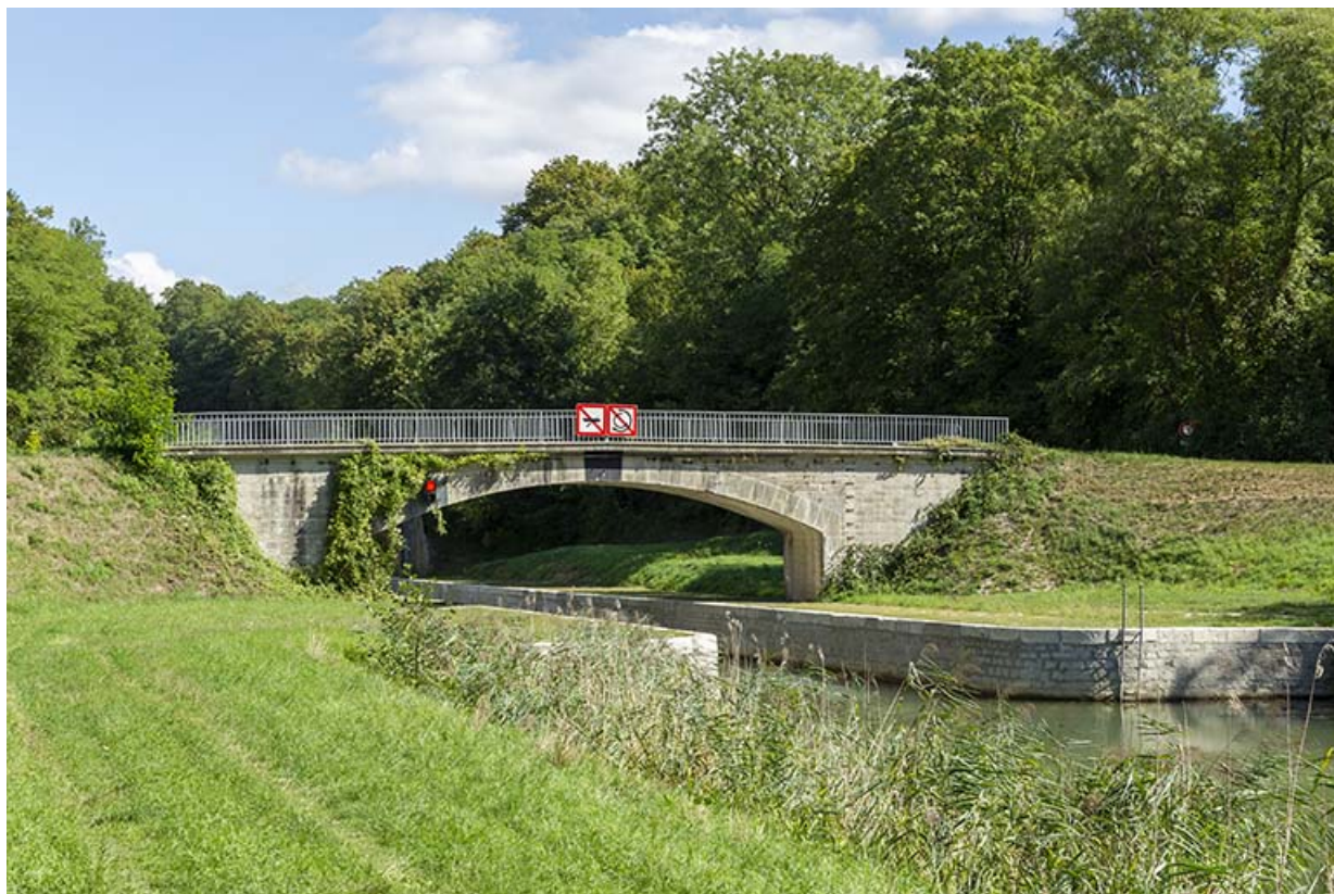
Pont routier en aval du tunnel.
