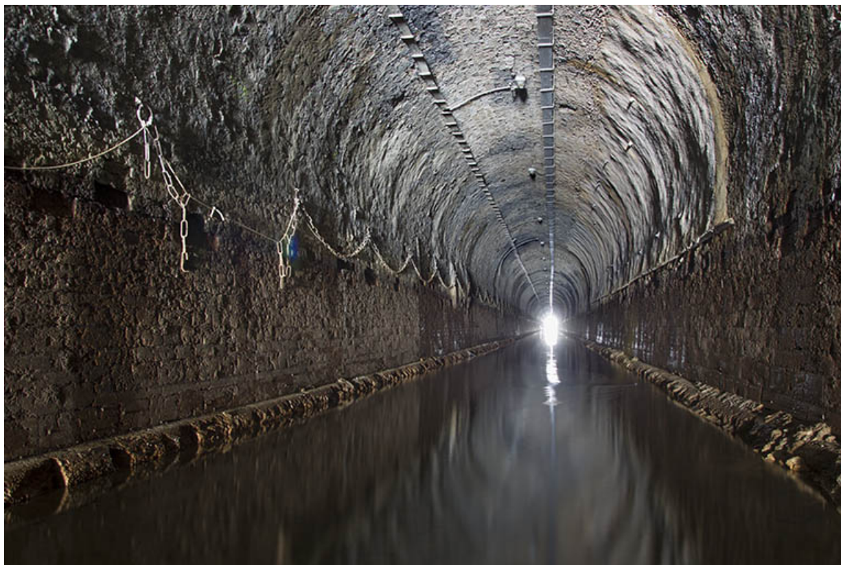
Intérieur du tunnel, vue générale.
