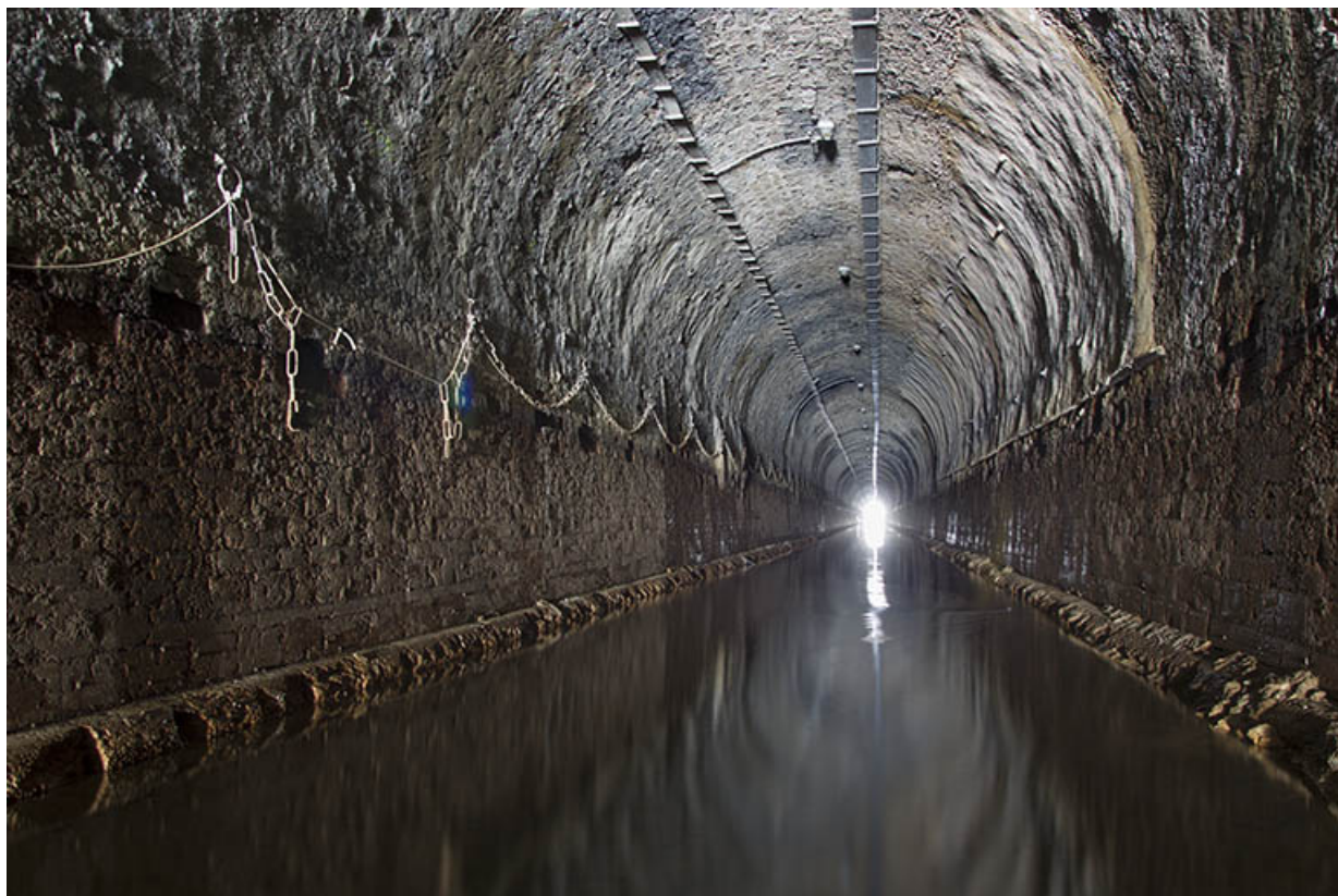
Intérieur du tunnel, vue générale.
