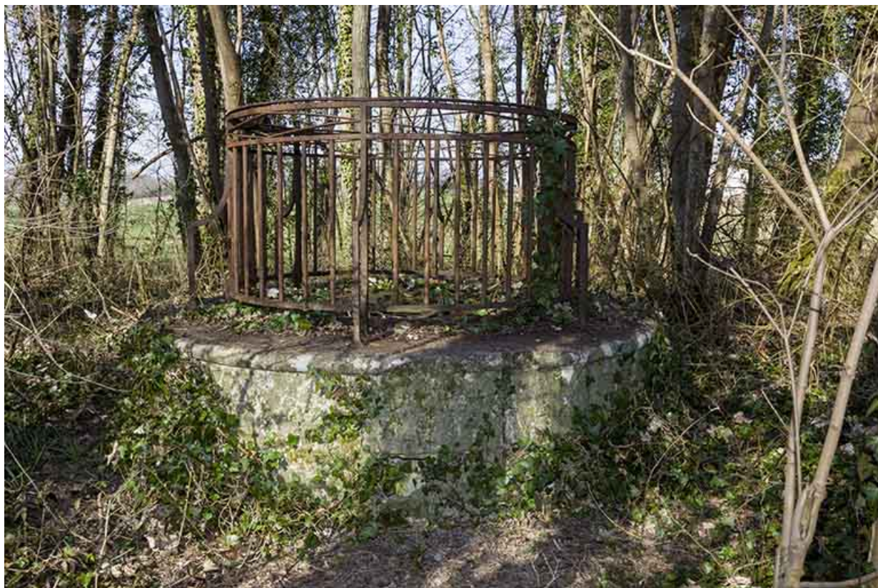
Puits d'aérage du tunnel.
