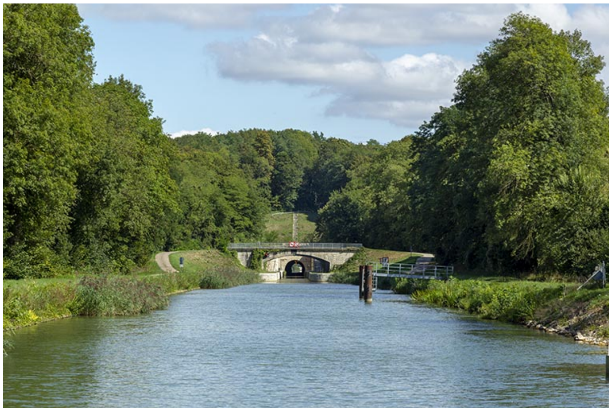
Vue depuis l'aval du canal de navigation et du tunnel en arrière-plan. 70, Savoyeux
