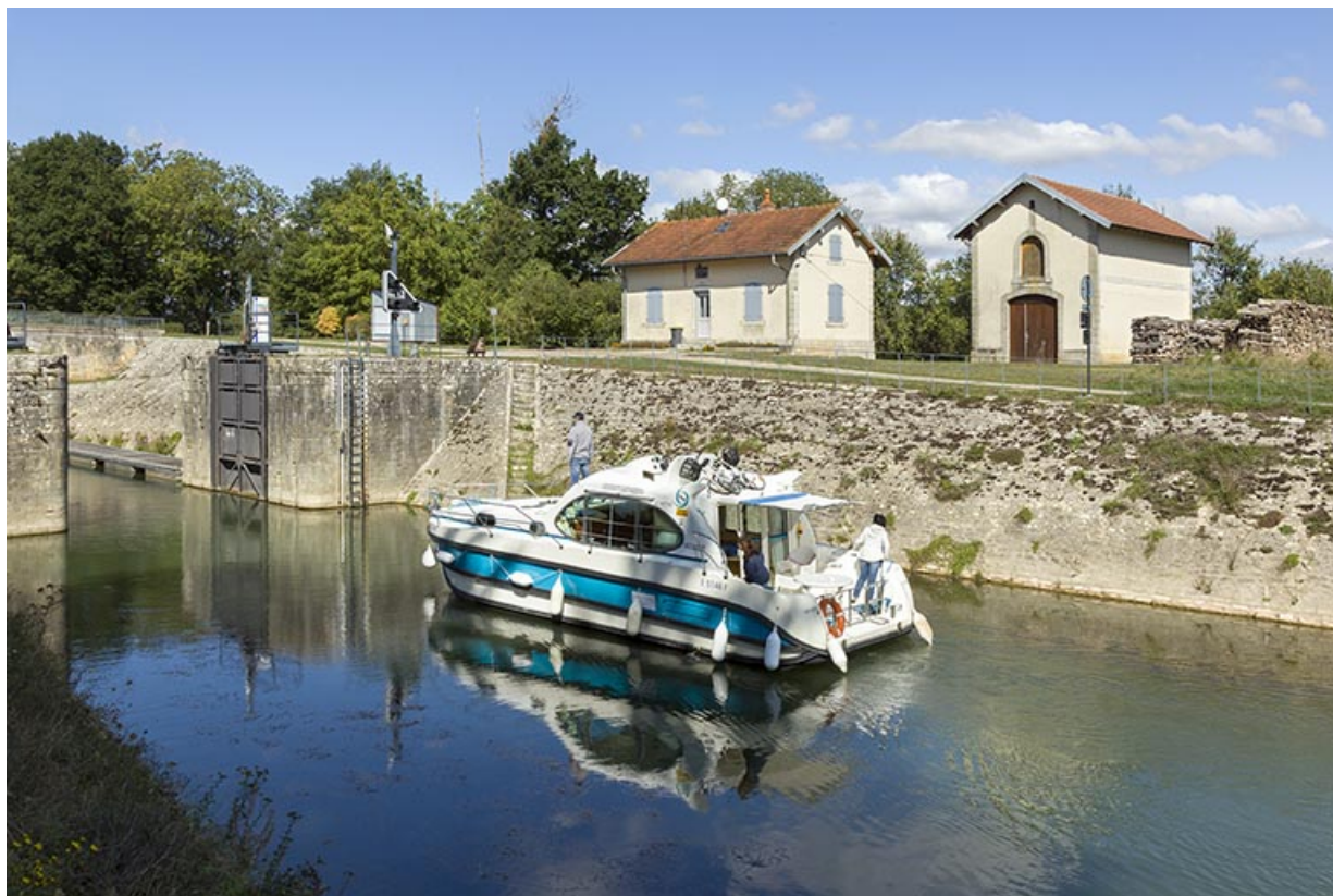
Ecluse de Ferrières-lès-Ray.
