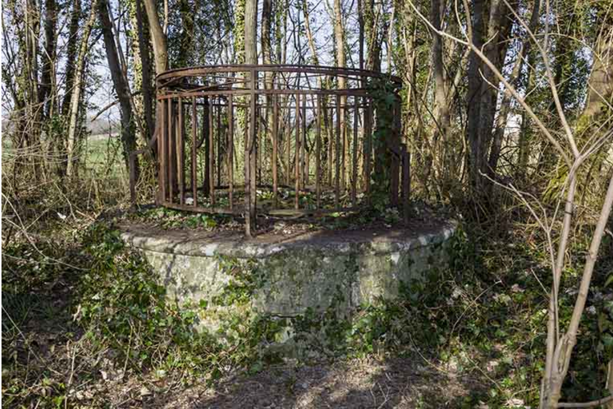
Puits d'aérage du tunnel.
