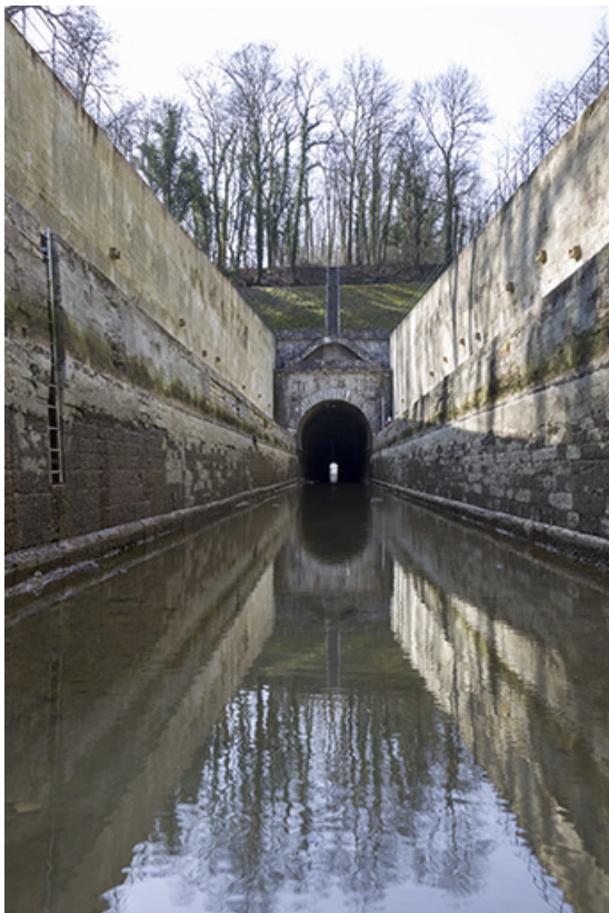
Le souterrain depuis la cuvette du canal.
