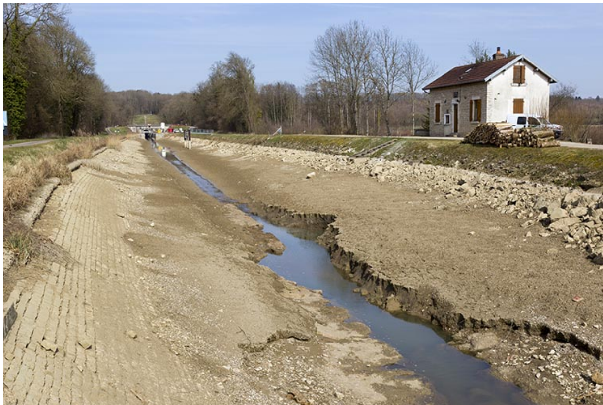
Travaux de curage du canal en 2015, partie aval de la dérivation de Savoyeux. 70, Savoyeux
