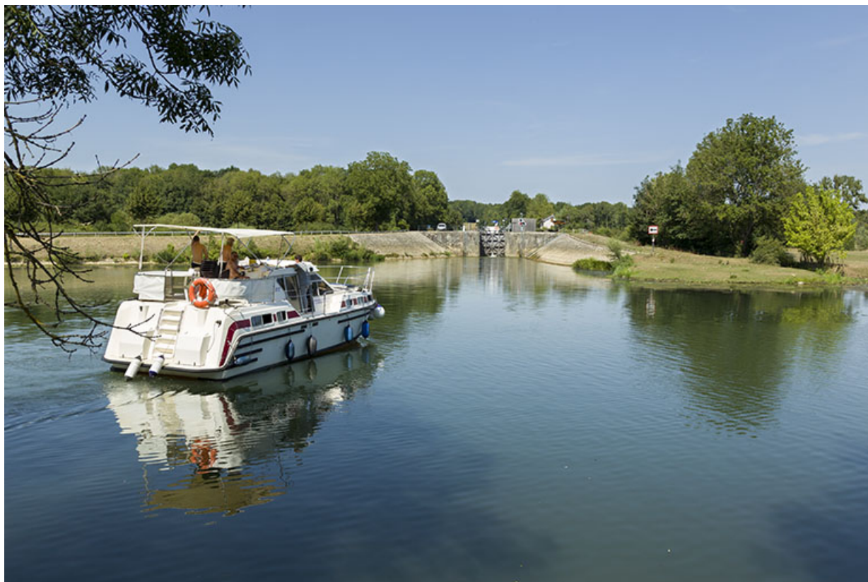
Entrée aval du bief de Savoyeux.
