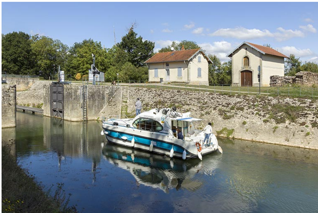
Ecluse de Ferrières-lès-Ray.
