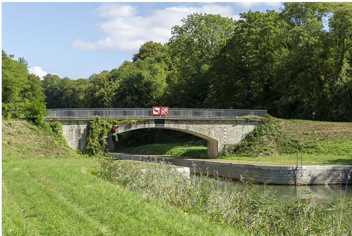
Pont routier en aval du tunnel.
