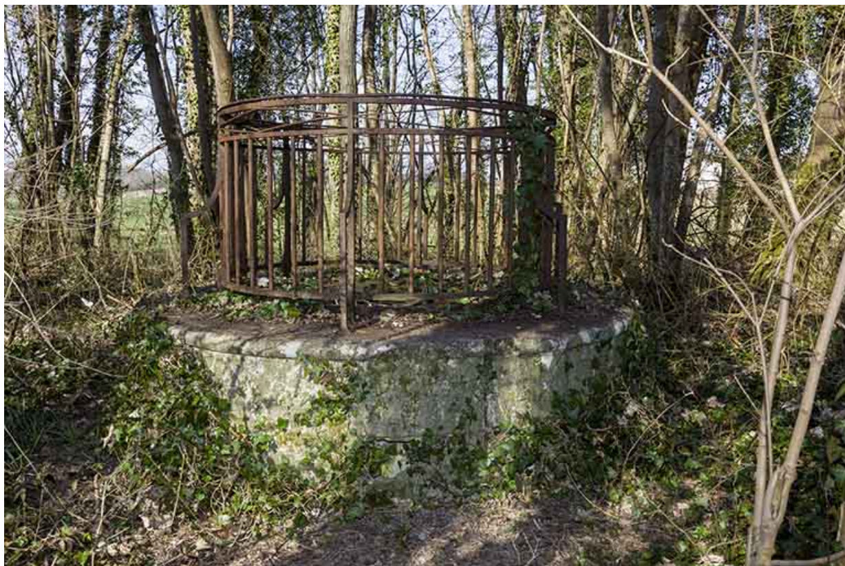
Puits d'aérage du tunnel.
