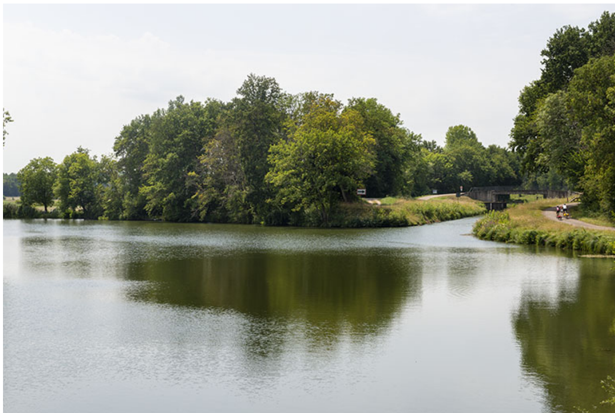
Entrée de la dérivation en direction du tunnel de Savoyeux et la porte de garde de Seveux. 70, Savoyeux
