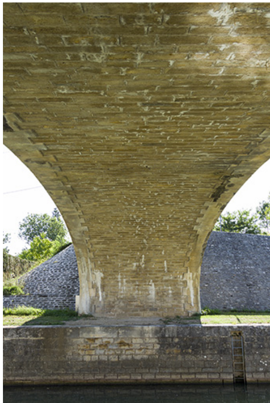
La voûte du pont.
