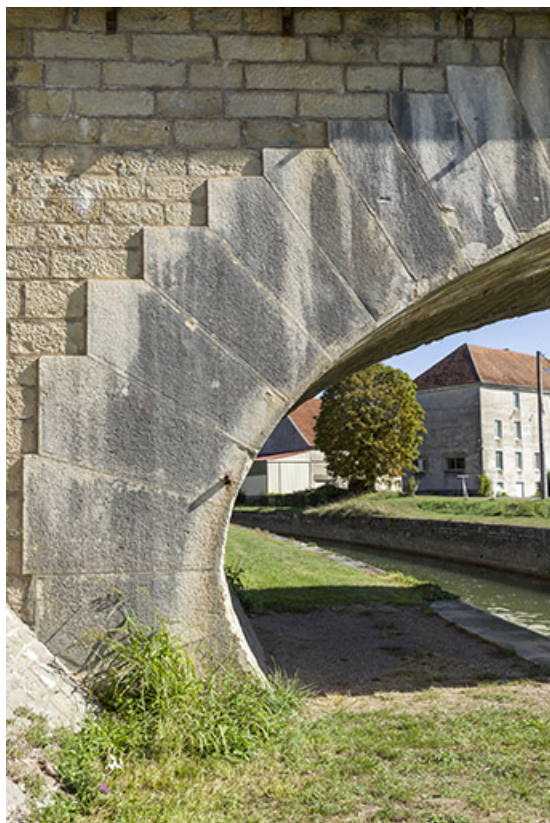
Détail sur la maçonnerie.
