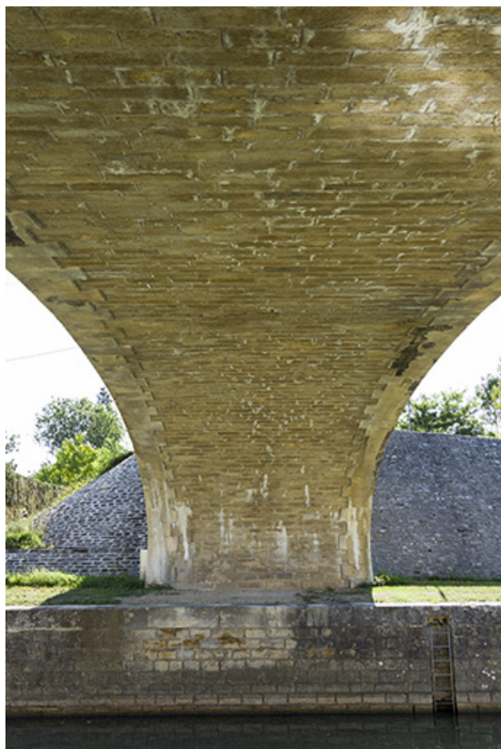
La voûte du pont.
