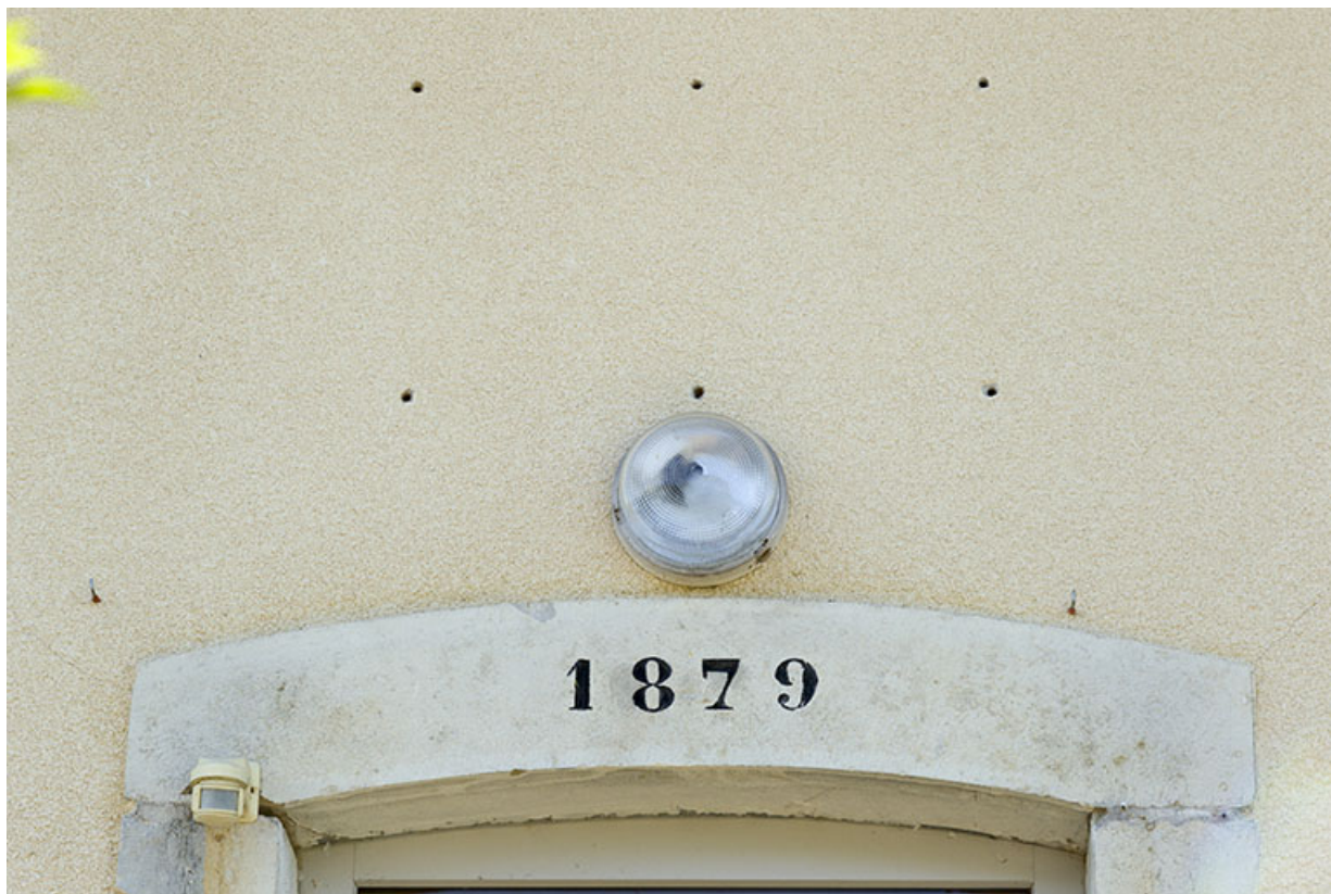
Date portée sur le linteau de la porte de la maison. 70, Vanne
