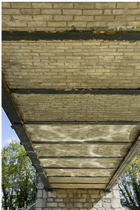
La voûte du pont.
