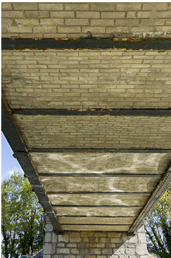
La voûte du pont.
