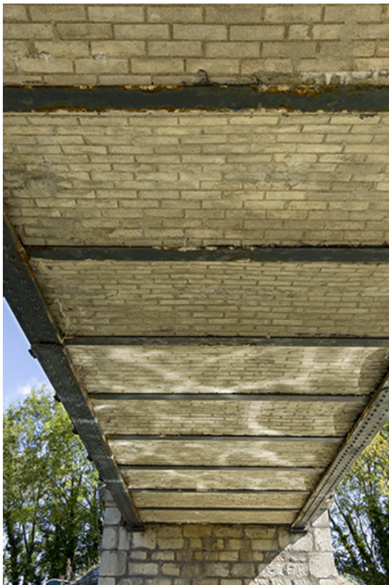
La voûte du pont.
