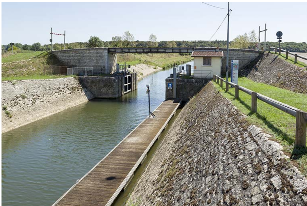
Le sas de l'écluse.
