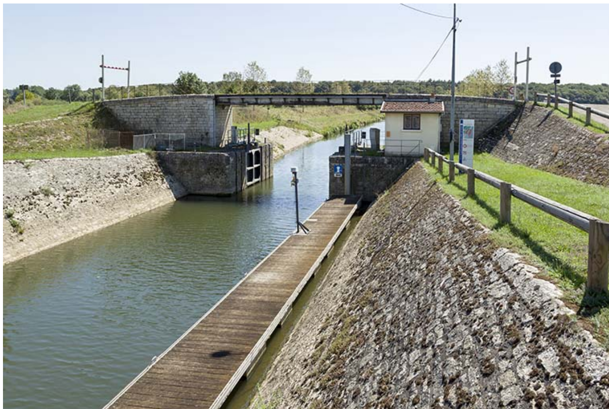
Le sas de l'écluse.
