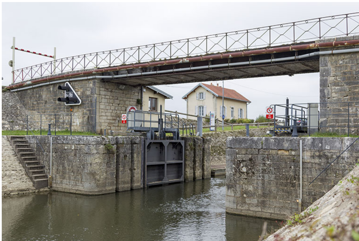
Vue amont. 70, Fédry
