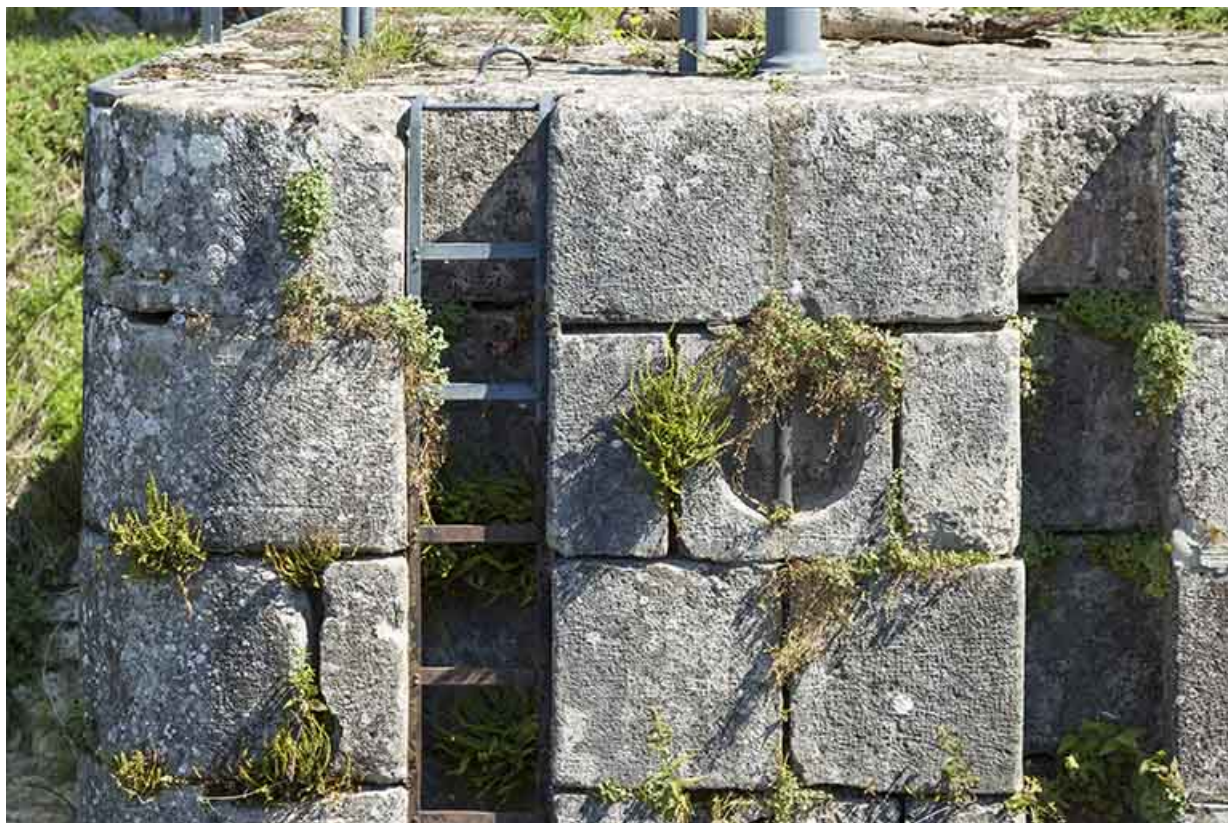
Rainure à batardeau (portière).
