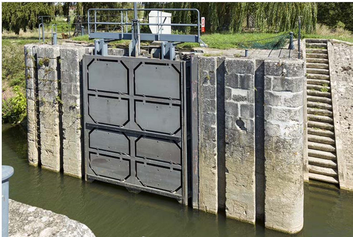
Vue d'un vantaill.
