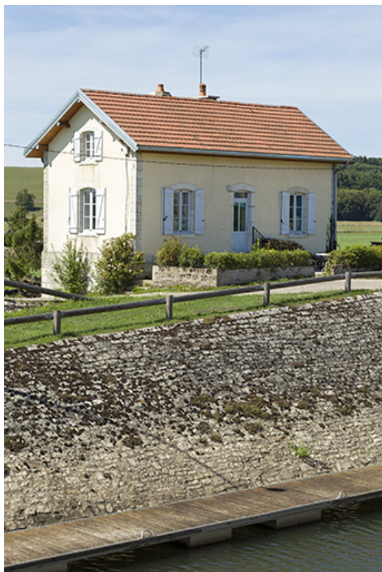
La maison de l'éclusier.
