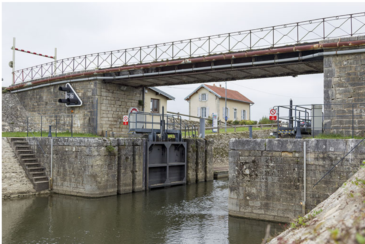
Vue amont. 70, Fédry
