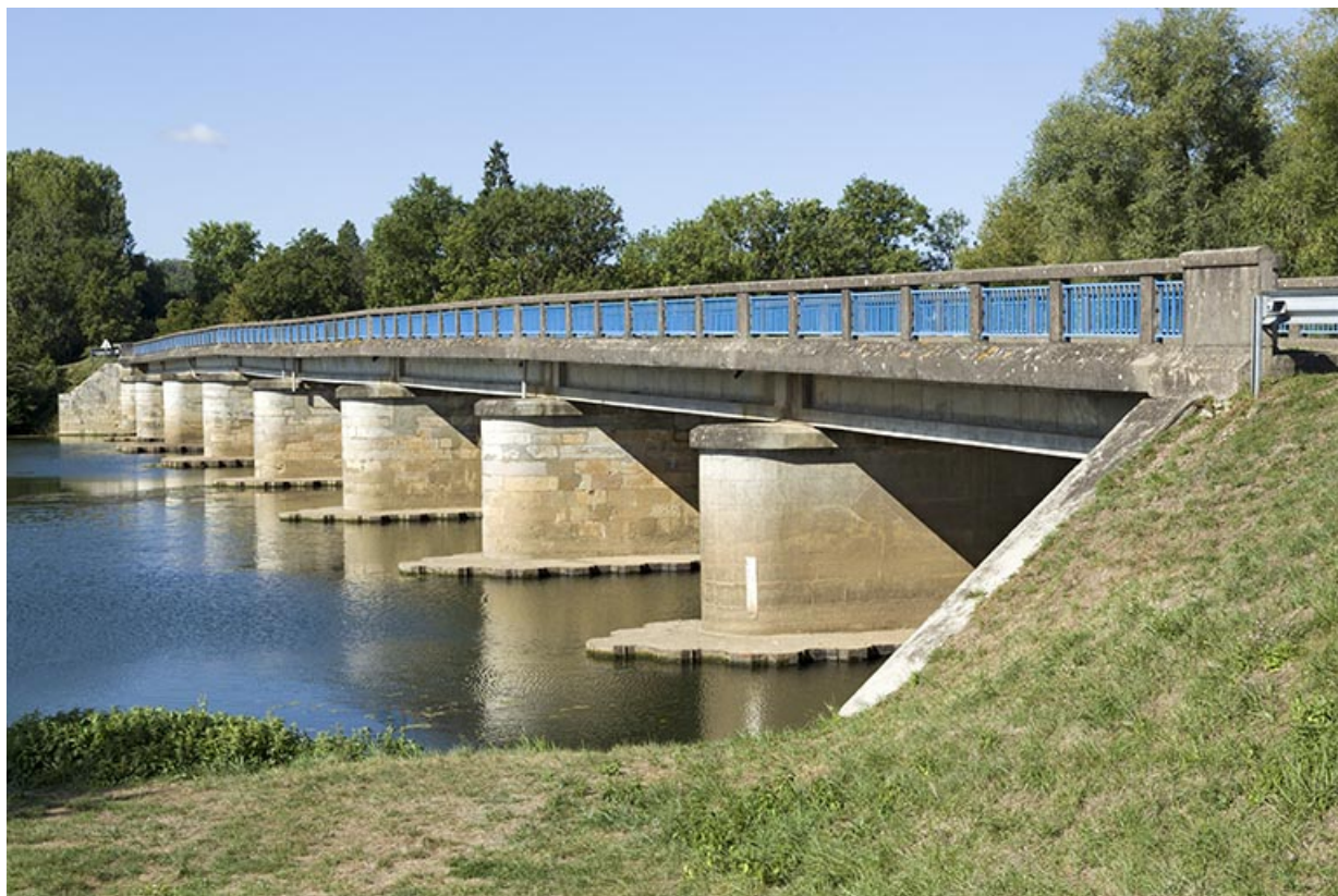
Le pont enjambant la Saône permettant de rejoindre le bourg de Soing. 70, Soing-Cubry-Charentenay
