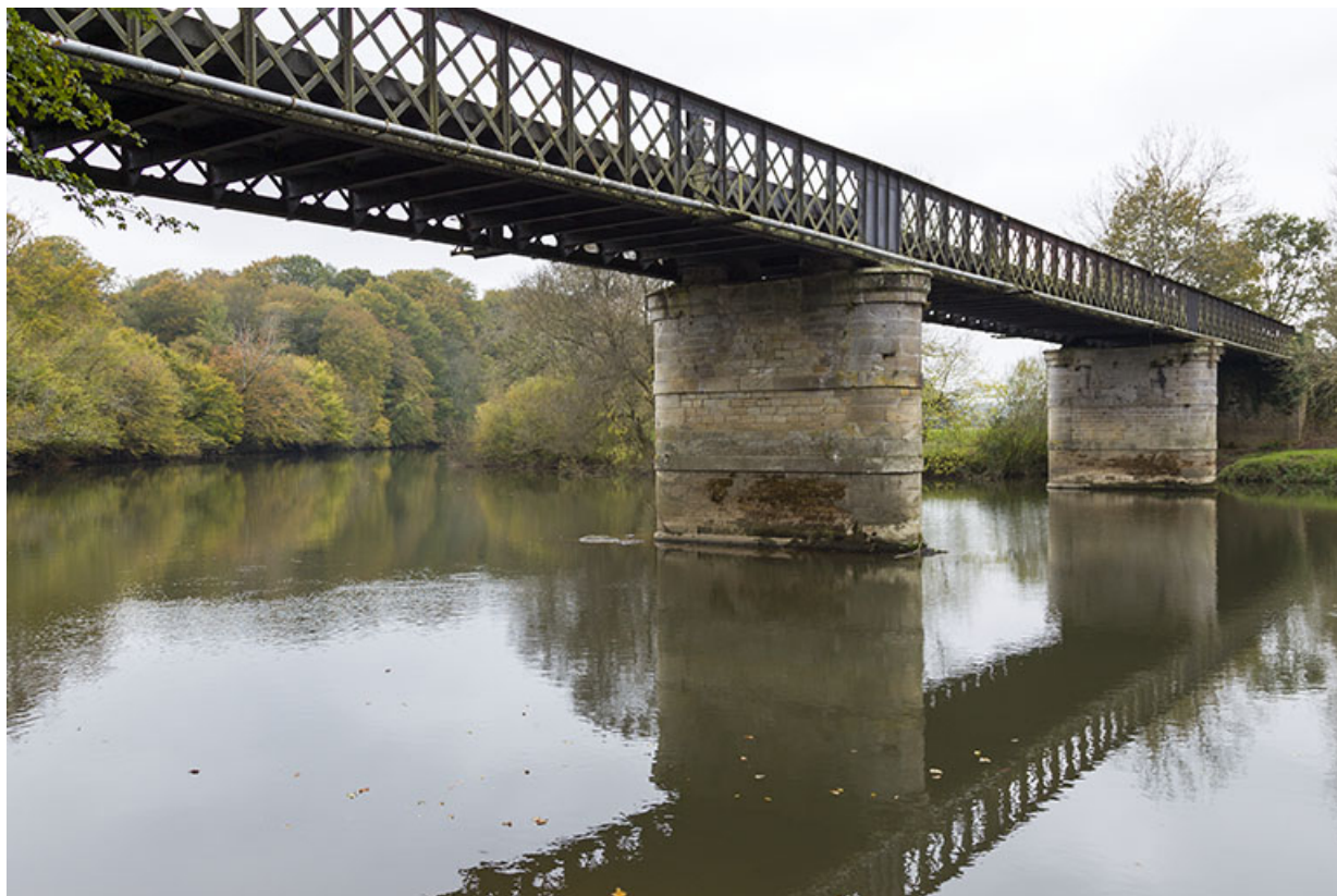
Détail du tablier métallique et des piles maçonnées.
