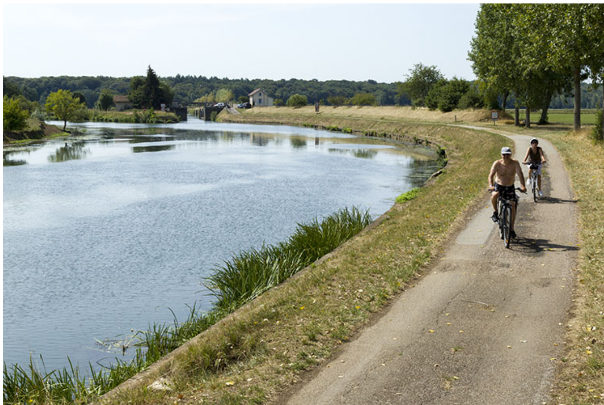
Cyclistes empruntant la véloroute aménagée sur l'ancien chemin de halage. 70, Soing-Cubry-Charentenay
