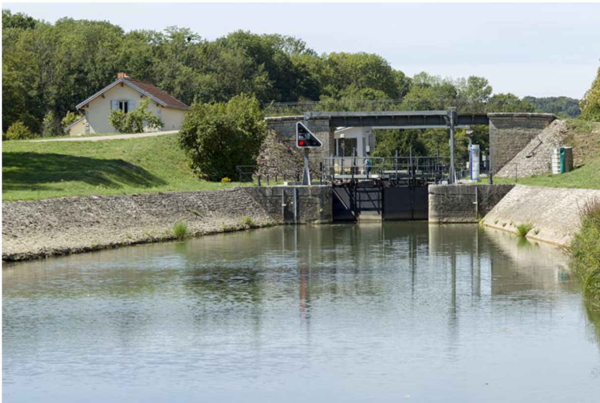
Entrée amont de l'écluse à sas.
