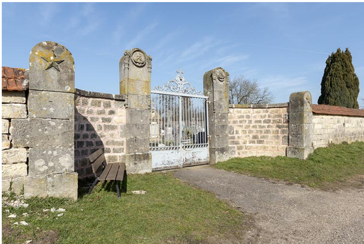
Mur d'enceinte et porte flamande du cimetière.
