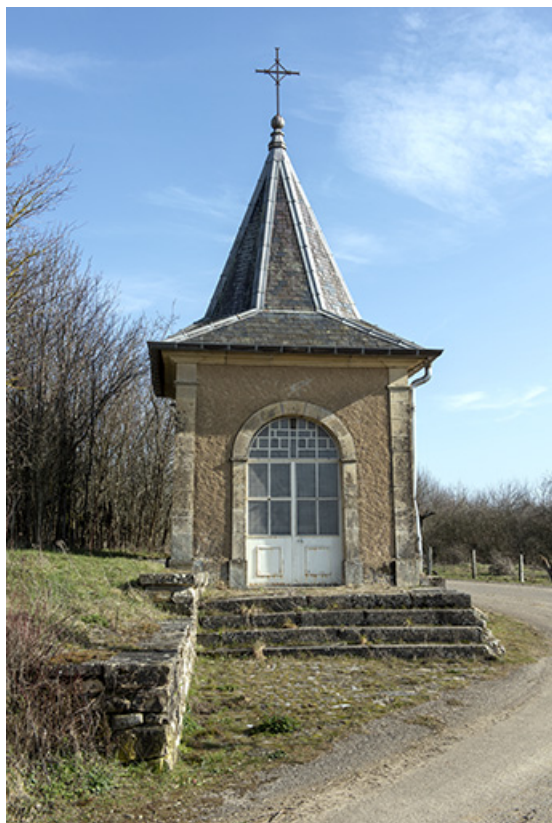
Façade antérieure ouest.
