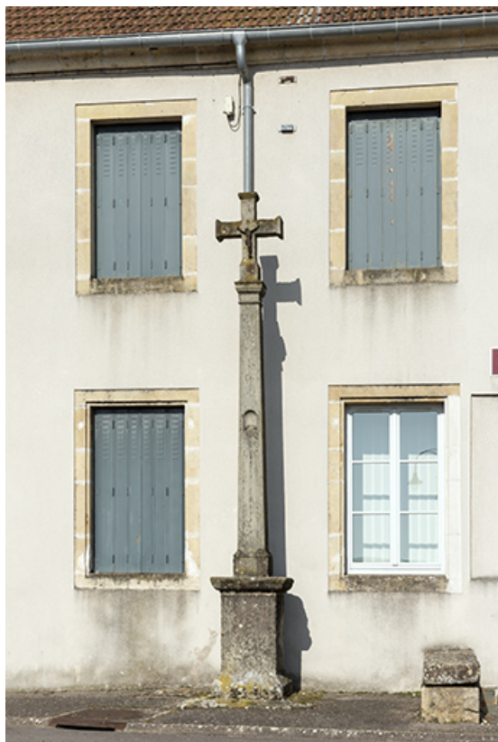
Croix réinstallée devant la mairie.
