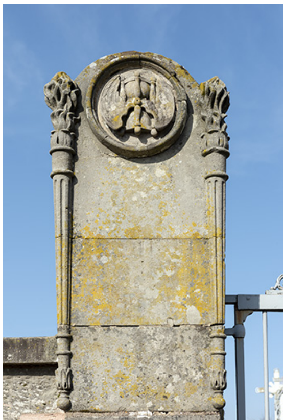
Vue rapprochée du pilier gauche sculpté de la porte flamande. 70, Cendrecourt
