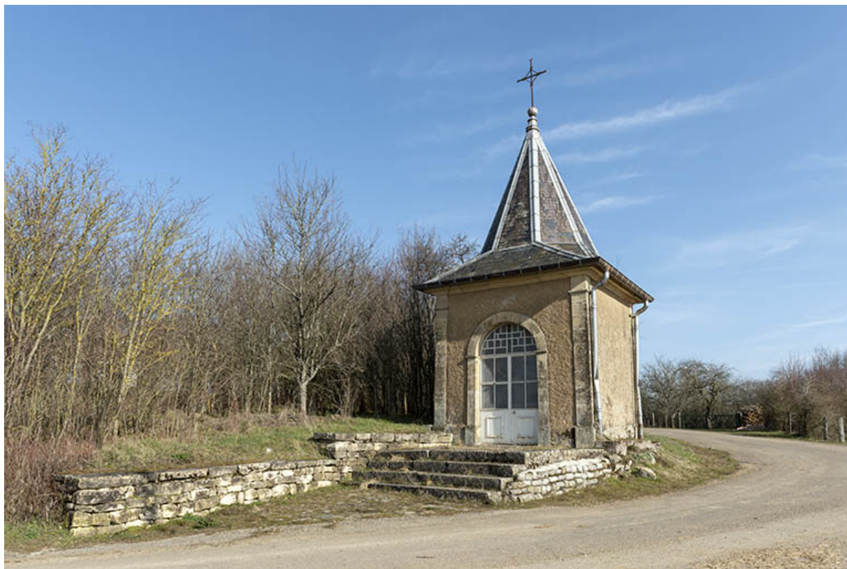
Vue de trois quart depuis l'ouest.
