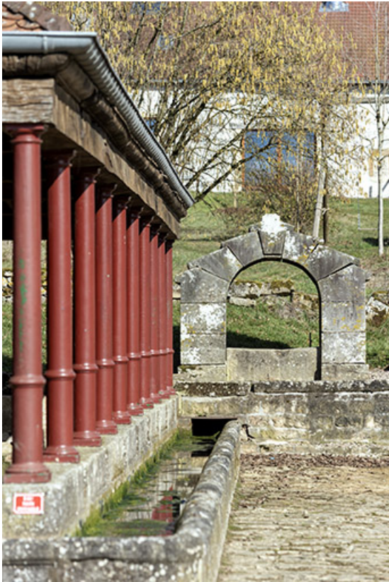
Vue de la colonnade du lavoir à l'entrée sud-est du village, depuis le sud. 70, Cendrecourt
