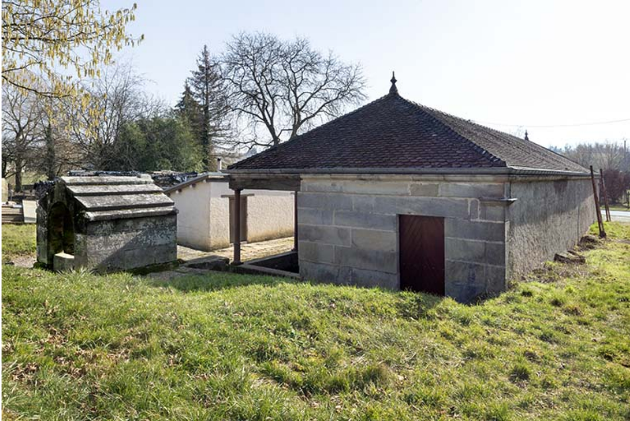
Vue de trois-quart nord-ouest du lavoir à l'entrée sud-est du village. 70, Cendrecourt
