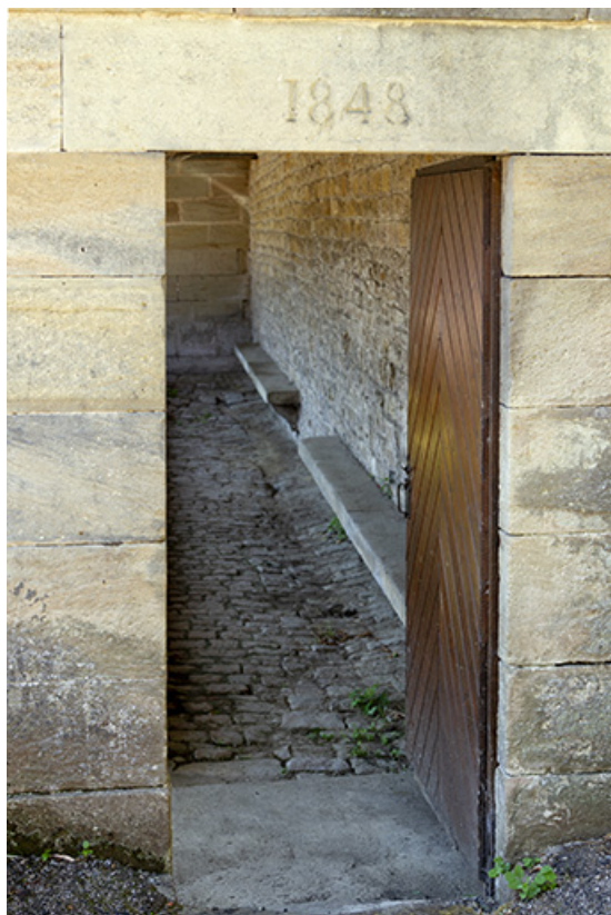
Porte et date portée au linteau du lavoir à l'entrée sud-ouest du village. 70, Cendrecourt
