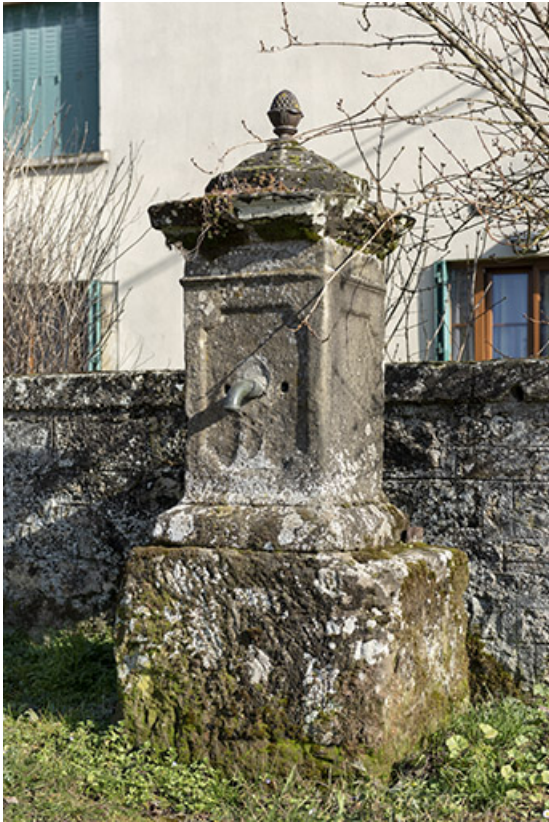
Fontaine à l'angle de la rue de Magny et du chemin de la Chapelle. 70, Cendrecourt
