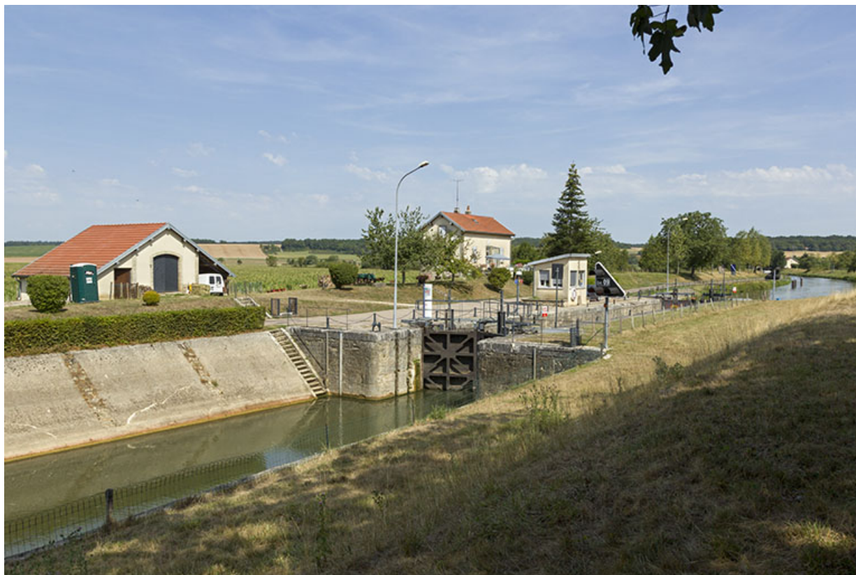
Vue générale du site d'écluse.
