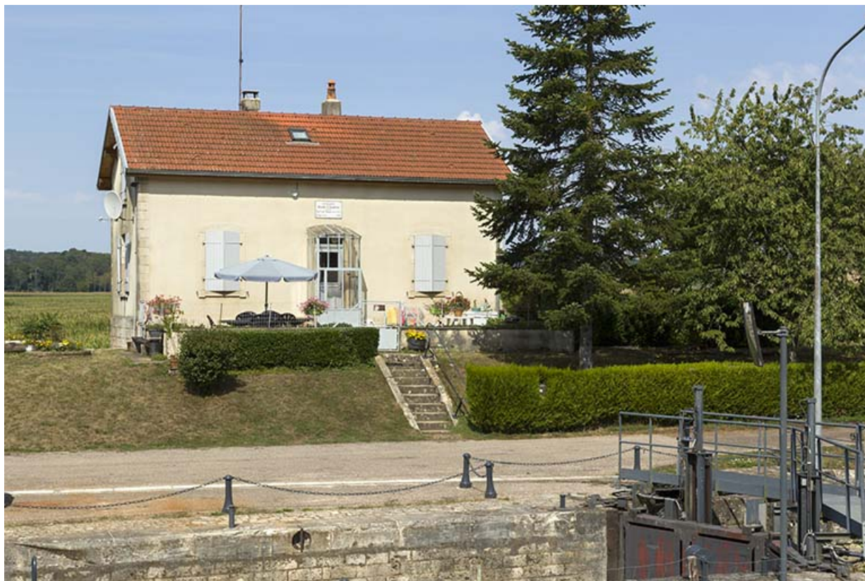
La maison d'éclusier. 70, Rupt-sur-Saône
