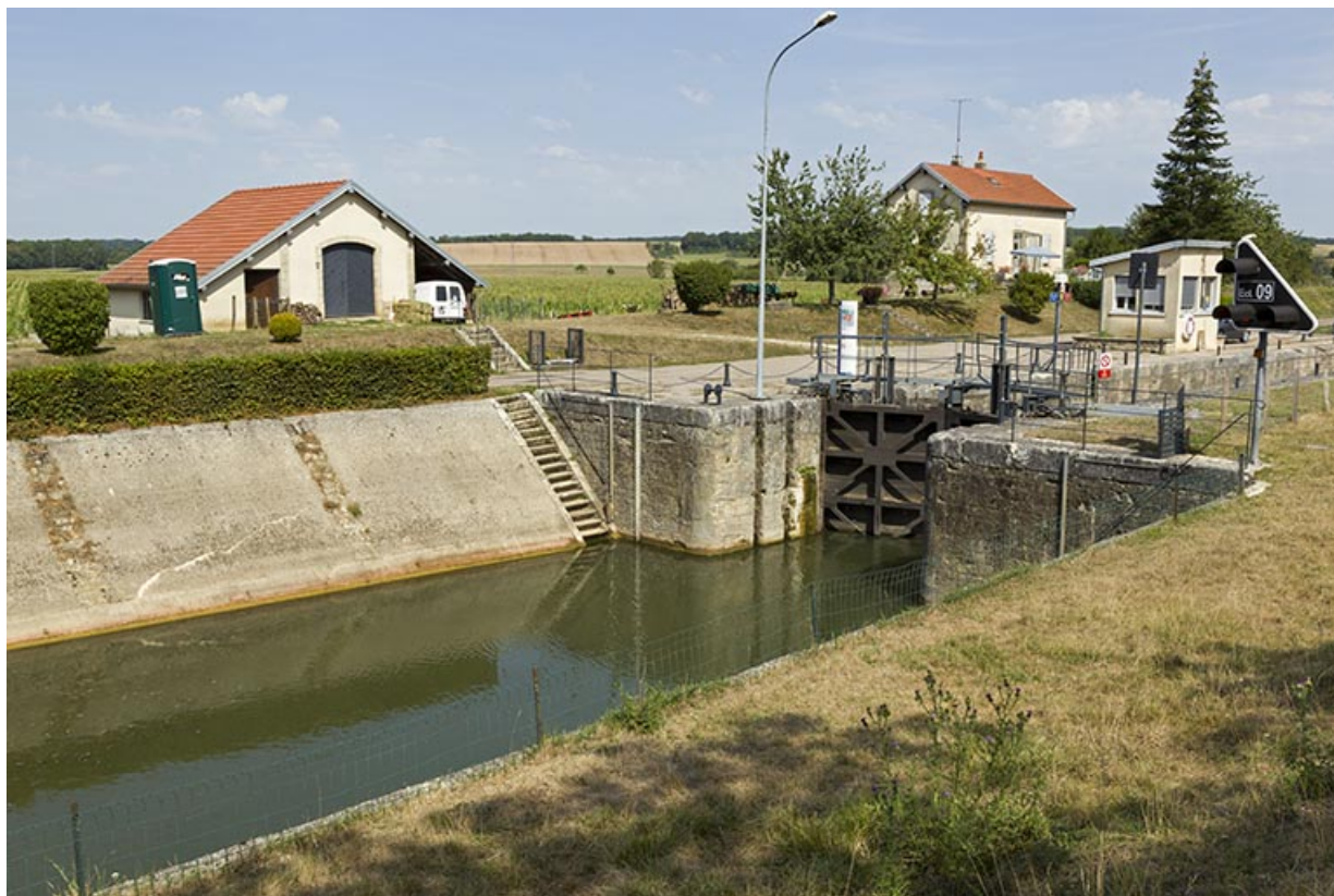
Entrée de l'écluse à sas. 70, Rupt-sur-Saône
