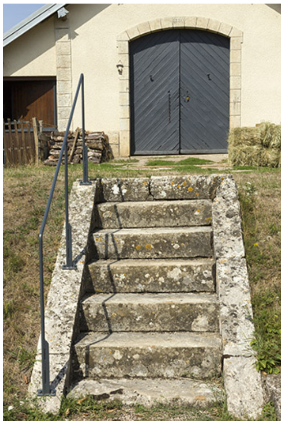
Volée de marches pour accéder au magasin. 70, Rupt-sur-Saône
