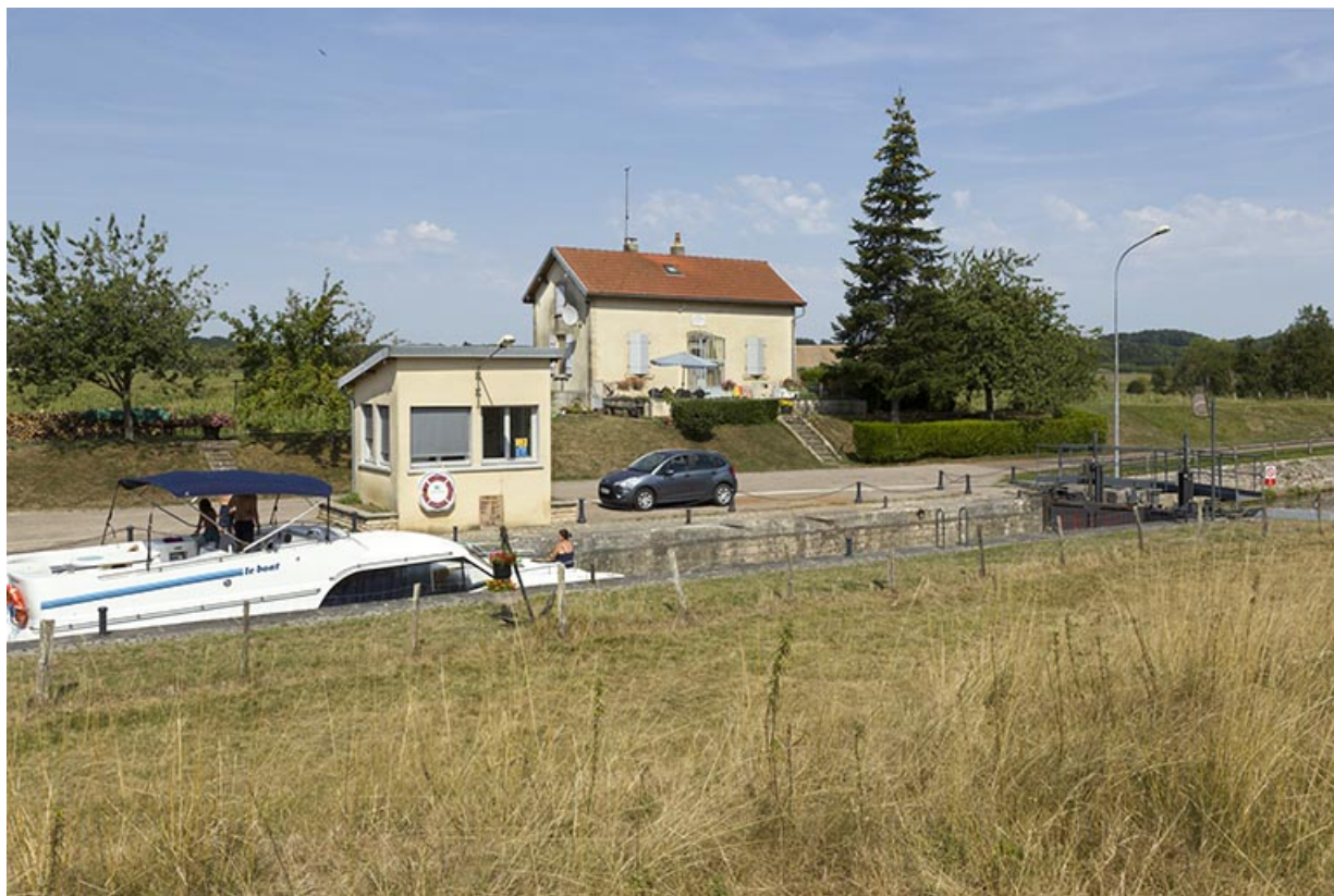
Bateau en train de franchir l'écluse.
