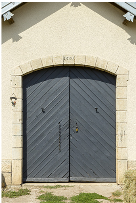
Porte d'entrée du magasin avec sa date de construction. 70, Rupt-sur-Saône
