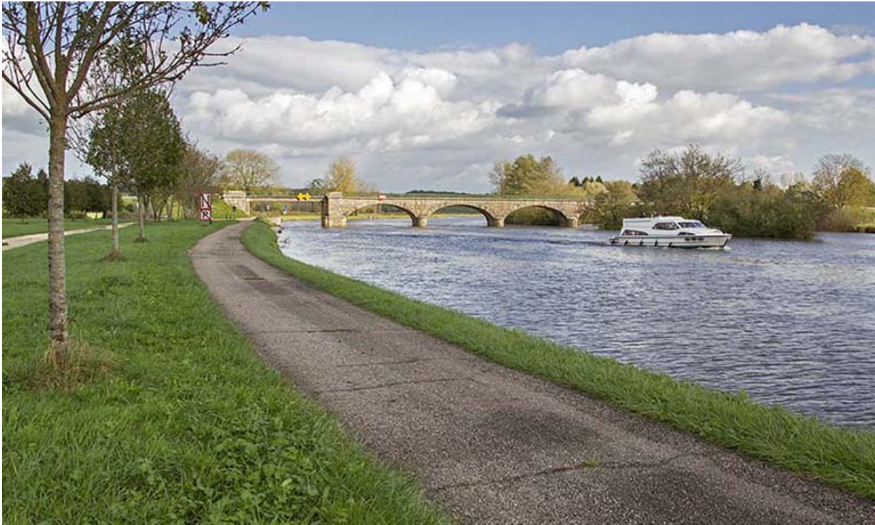
Vue depuis l'aval.
