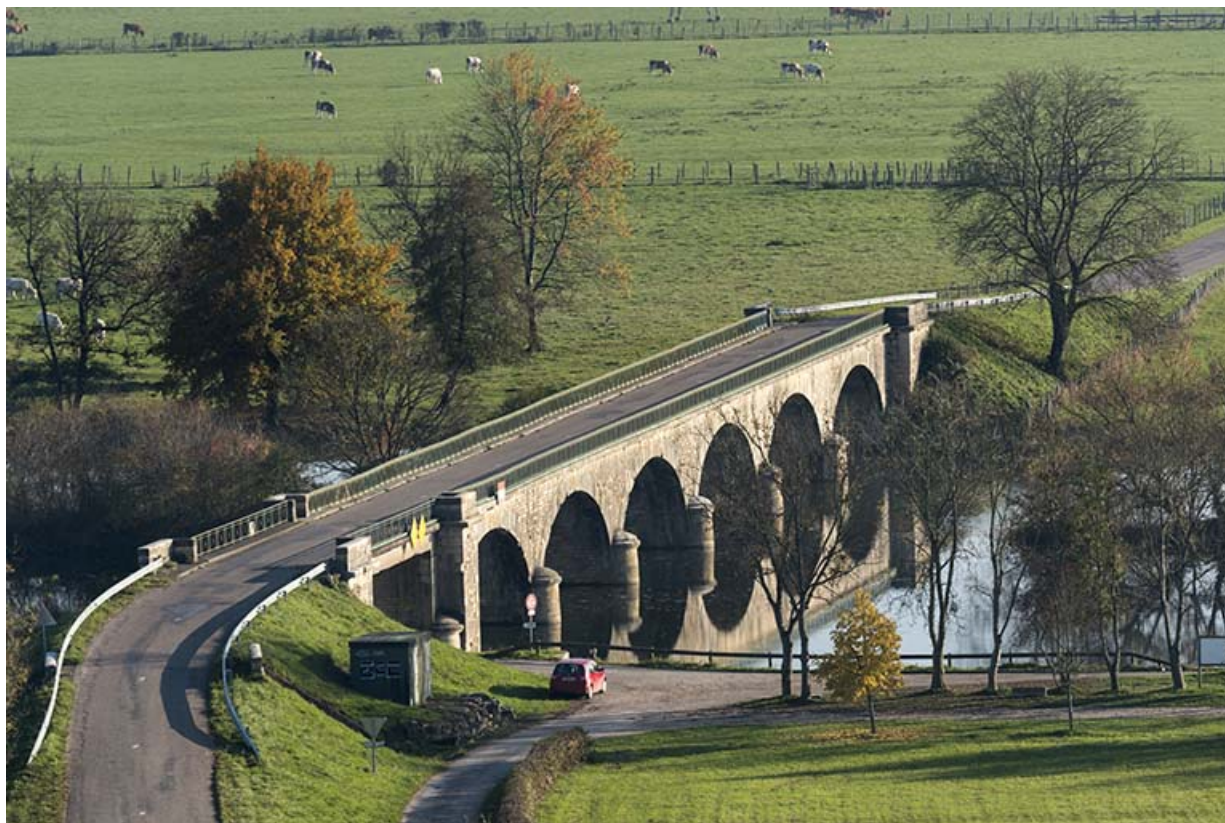
Vue générale du pont depuis le château de Rupt-sur-Saône. 70, Chantes
