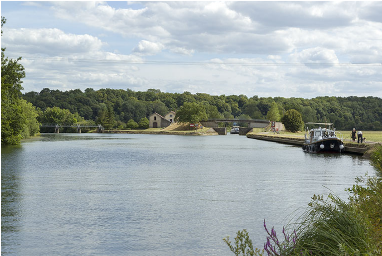
La Saône avec le barrage mobile et la porte de garde. 70, Chantes
