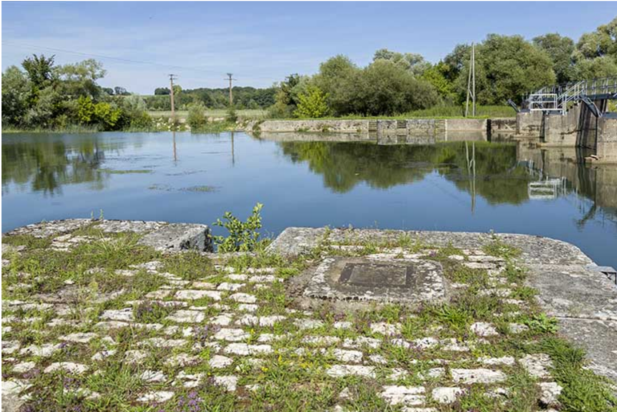
Emplacement de l'ancien barrage à aiguilles. 70, Chantes
