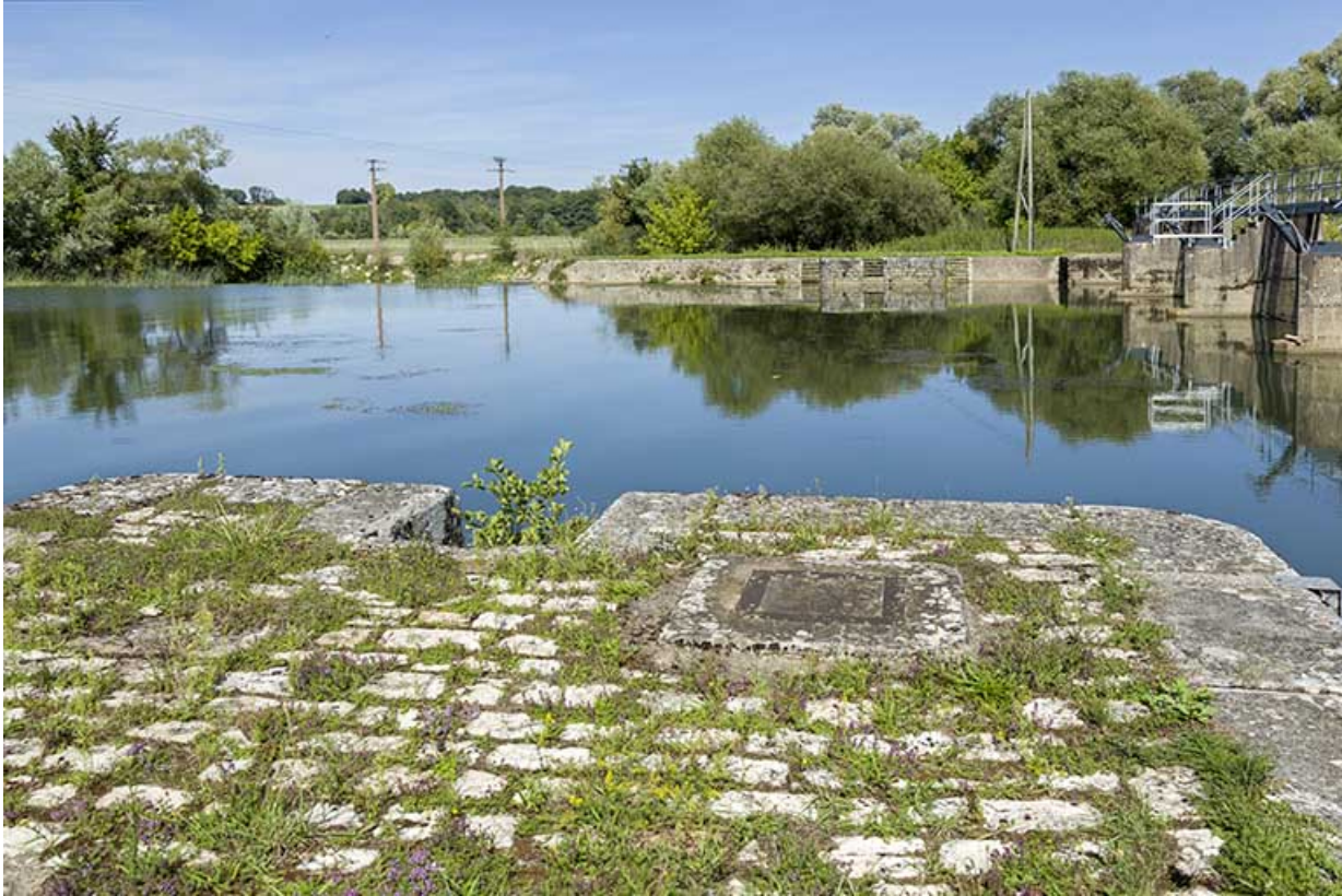
Emplacement de l'ancien barrage à aiguilles. 70, Chantes
