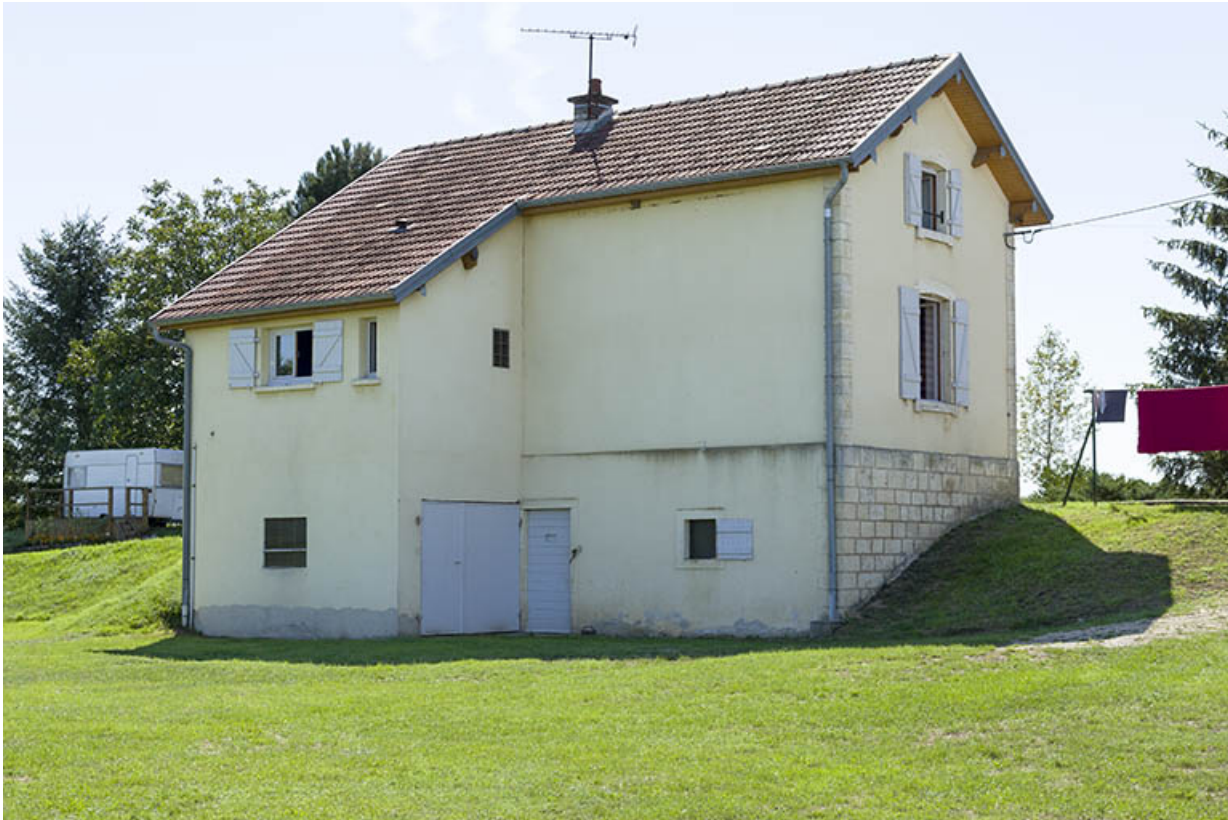
Façade postérieure de la maison.
