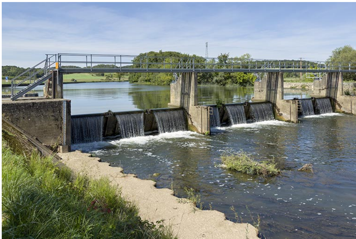
Le barrage à clapets.
