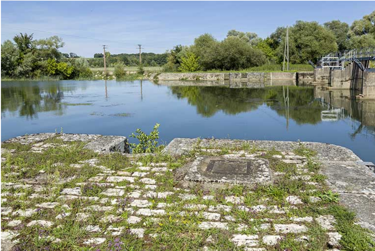
Emplacement de l'ancien barrage à aiguilles. 70, Chantes
