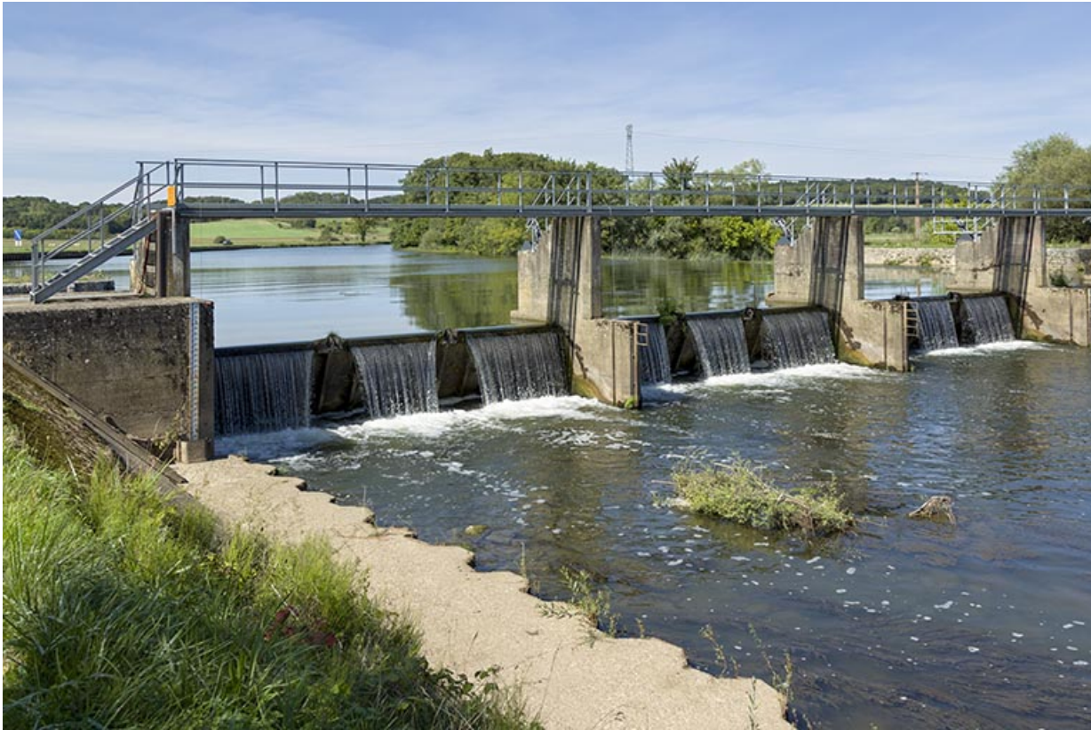
Le barrage à clapets.
