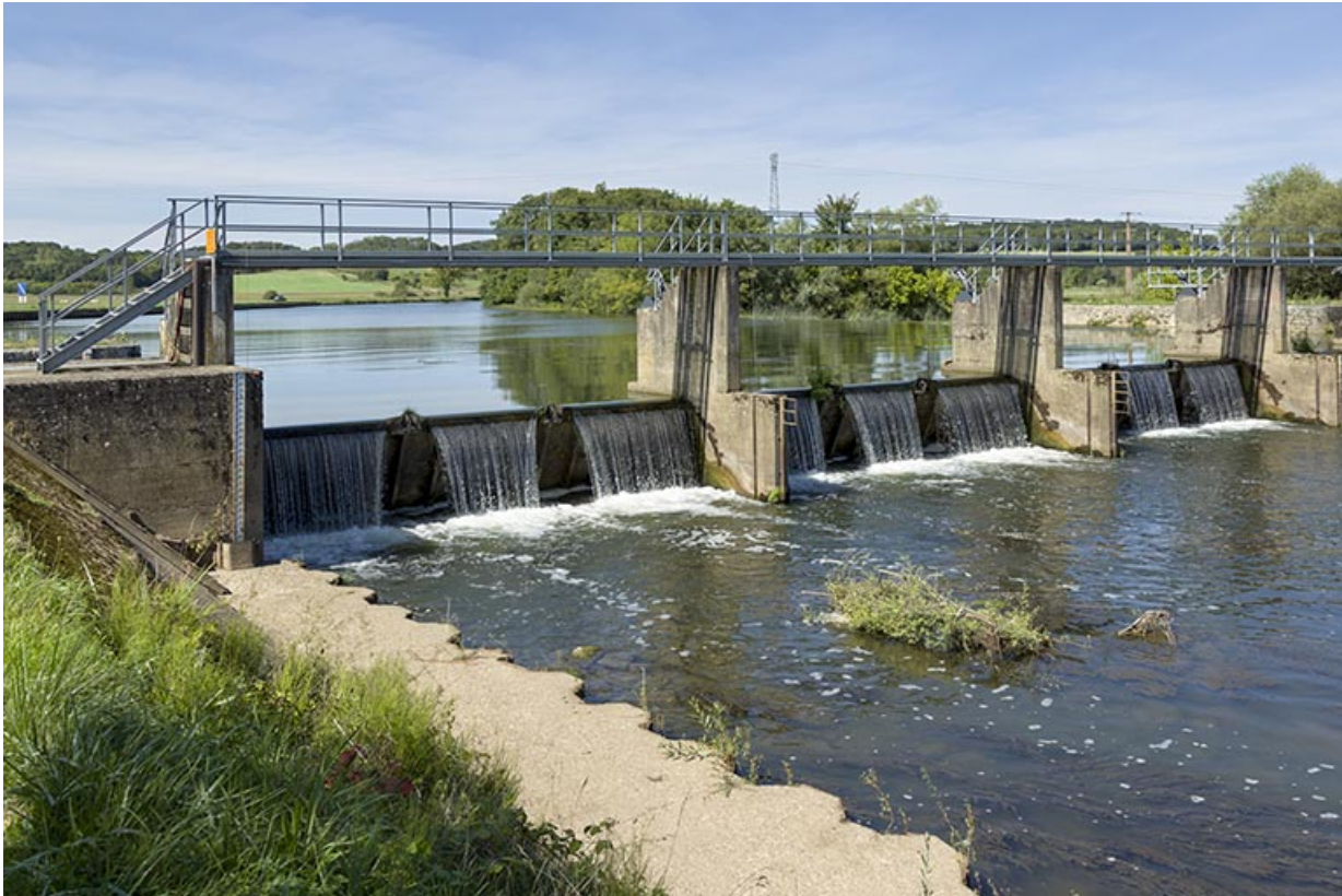
Le barrage à clapets. 70, Chantes
