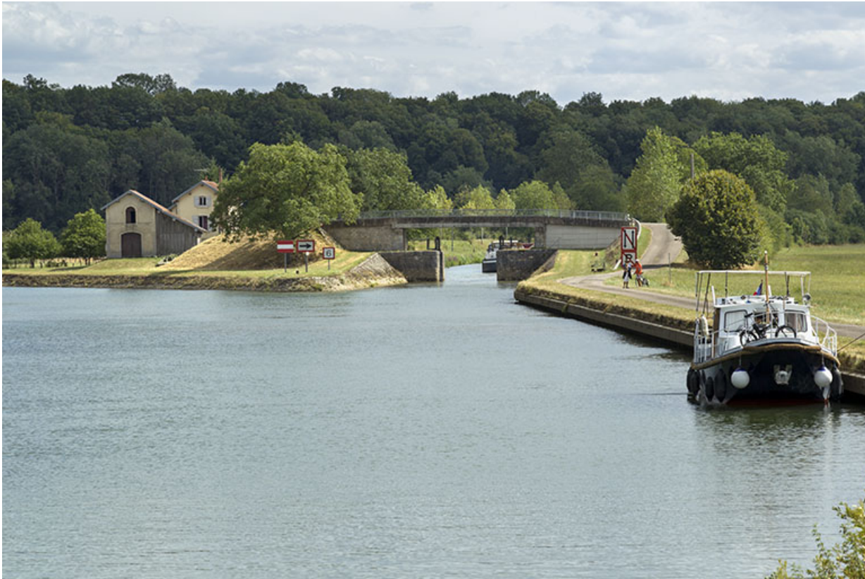
La porte de garde en amont de la dérivation. 70, Chantes
