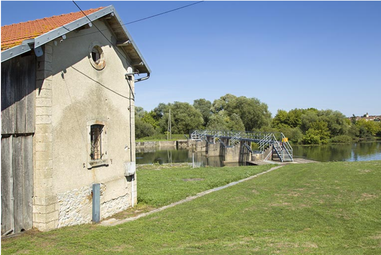
Mur pignon du magasin et le barrage mobile. 70, Chantes
