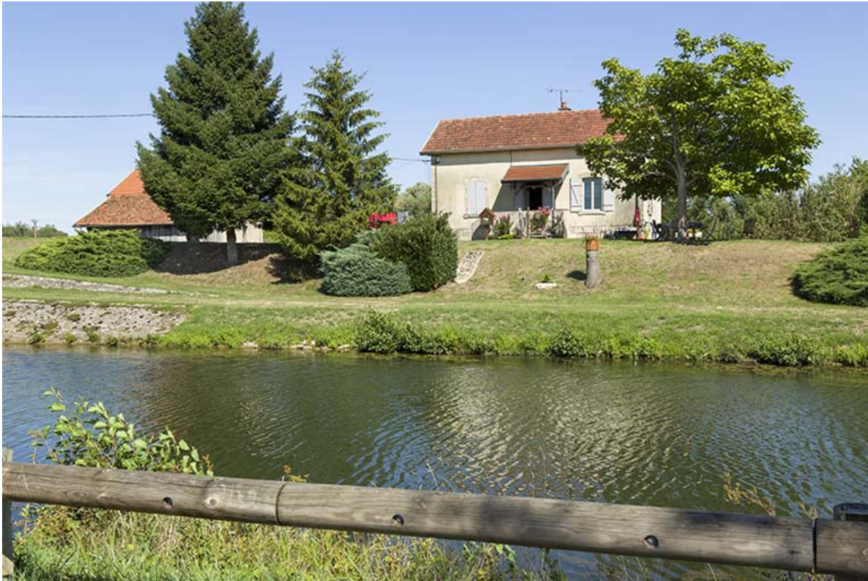
Maison du barragiste.
