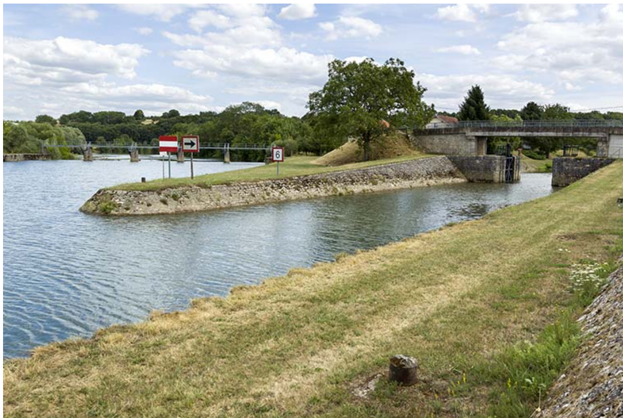
Vue générale de la porte de garde et du barrage mobile du bief de Chantes. 70, Chantes
