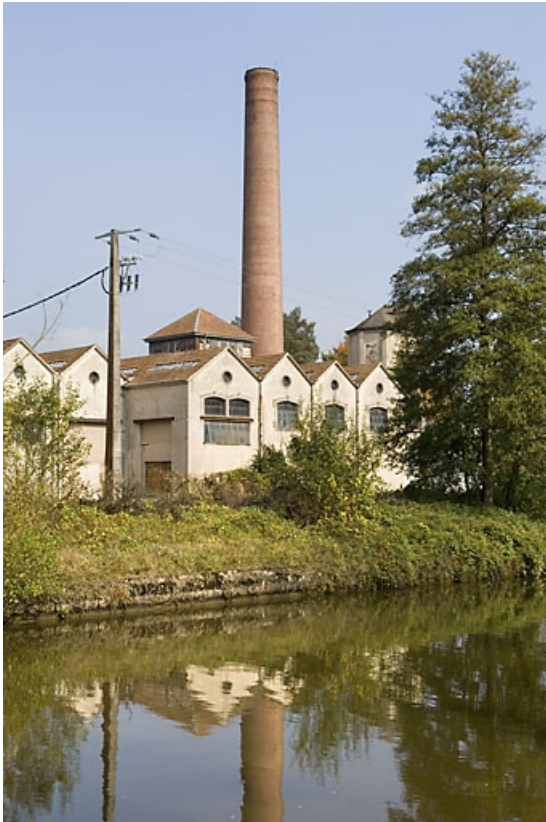
L'usine et le canal.
