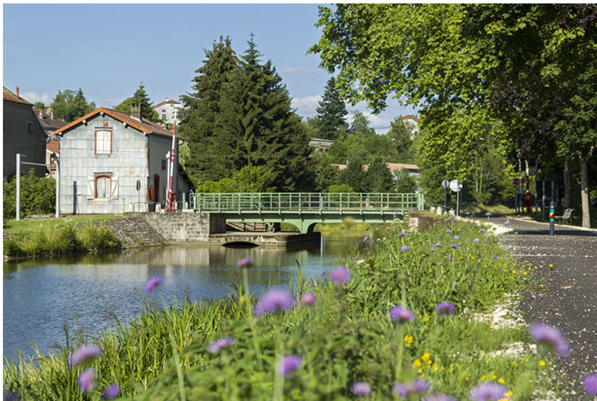
Le pont tournant depuis l'aval.
