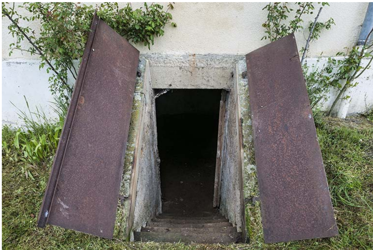
Porte d'accès à la cave, maison du barragiste.
