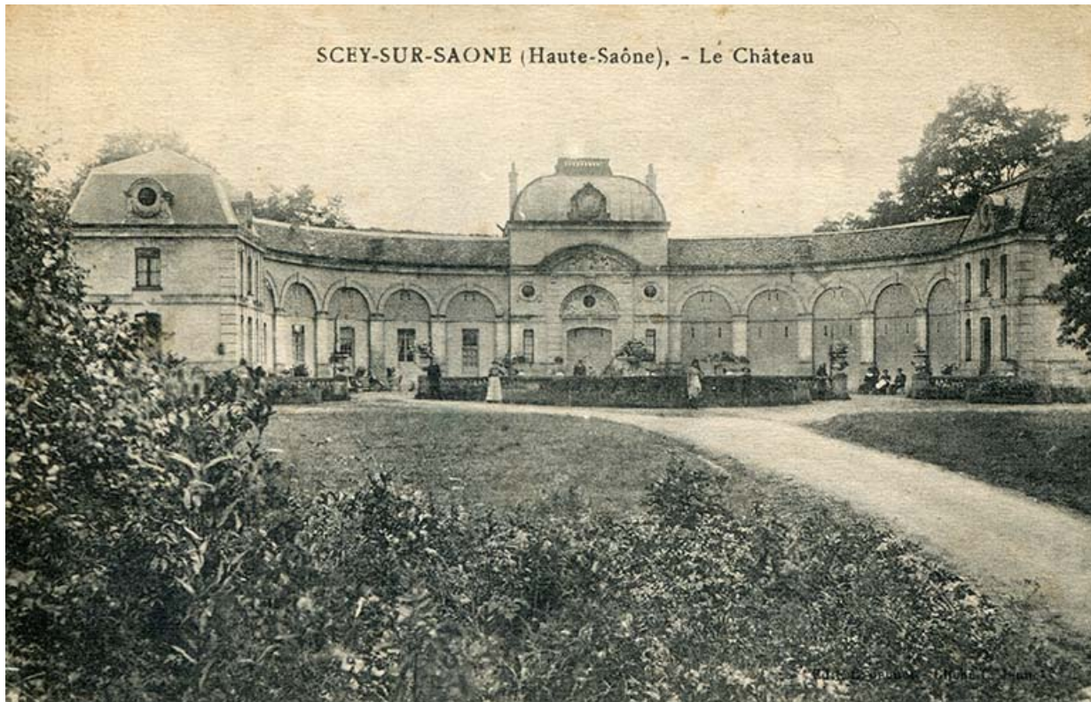
Façade orientale de l'écurie, vue ancienne, après l'obturation des arcades.
