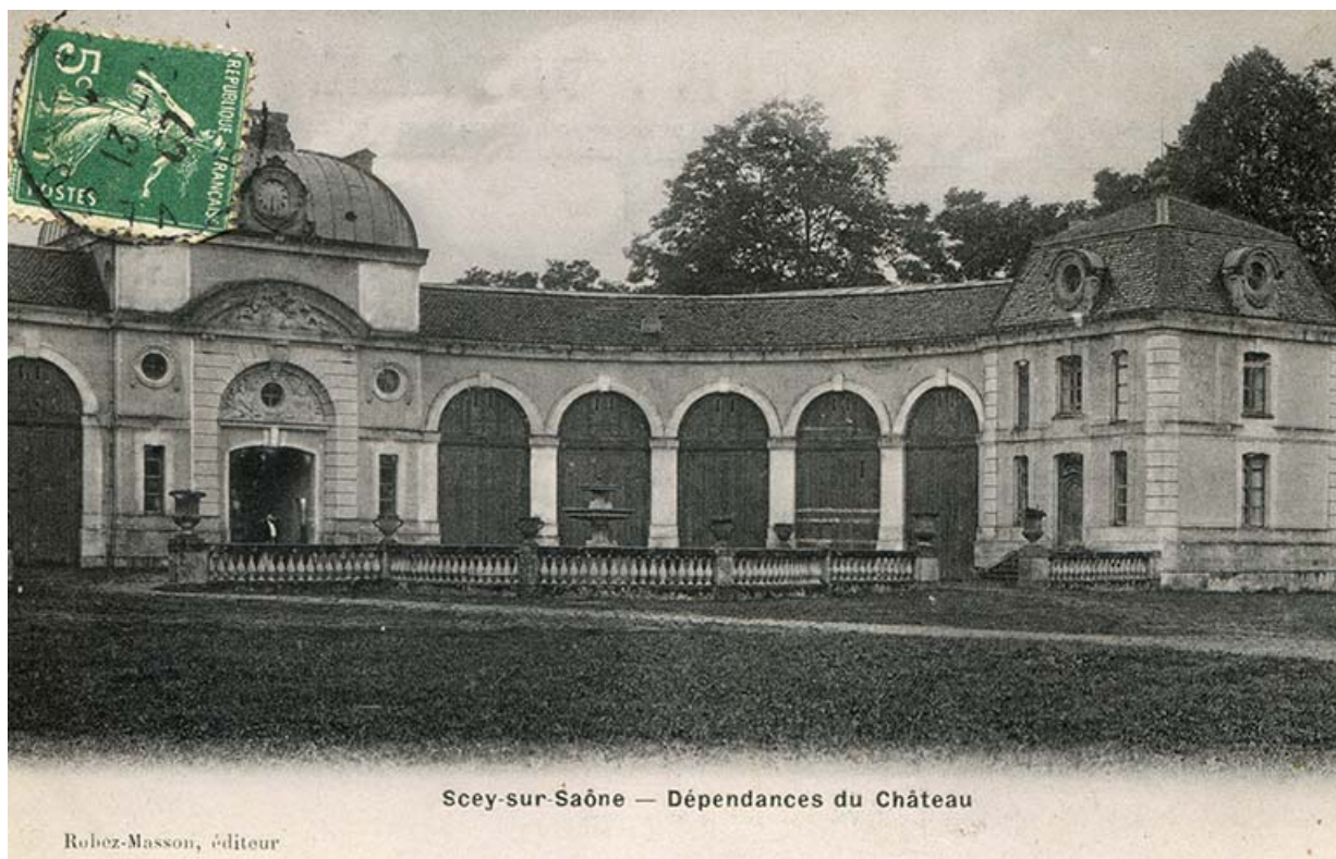
Façade orientale de l'écurie, vue ancienne, avant l'obturation des arcades.
