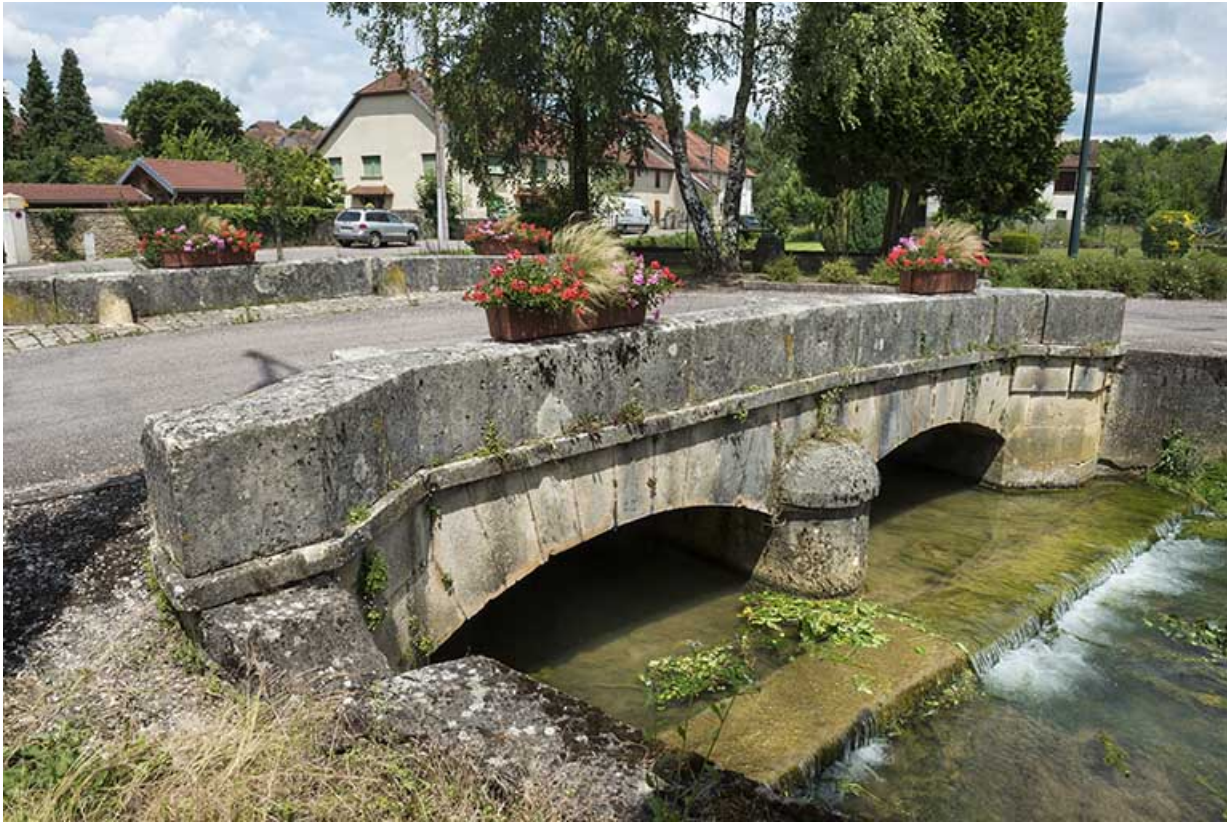
Face sud, vue depuis l'ouest.
