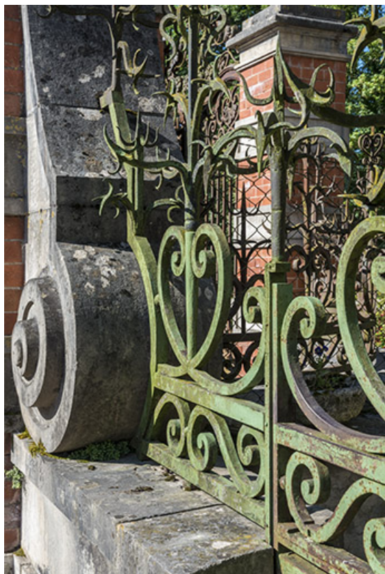
Clôture (grille) sur la rue Armand Paulmard.
