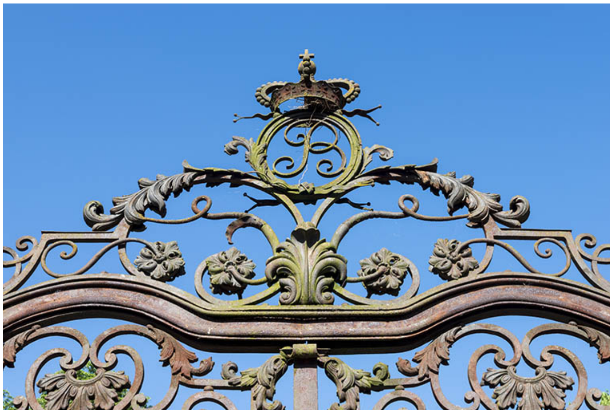
Clôture (grille) sur la rue Armand Paulmard.
