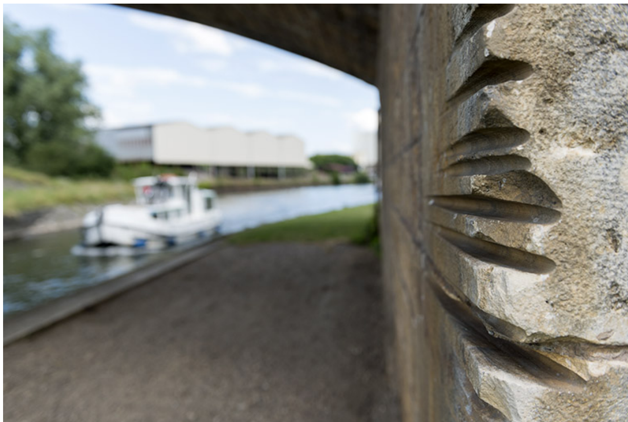
Pile du pont avec l'ancien chemin de halage et un bateau de plaisance remontant la dérivation. 70, Scey-sur-Saône-et-Saint-Albin
