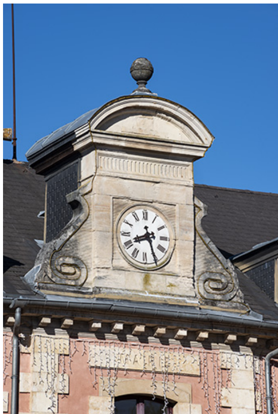
Façade nord-est, édicule en amortissement avec cadran d'horloge.
