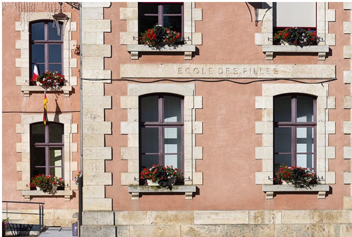
Extrémité de l'aile nord-ouest (ancienne école des filles), détail.
