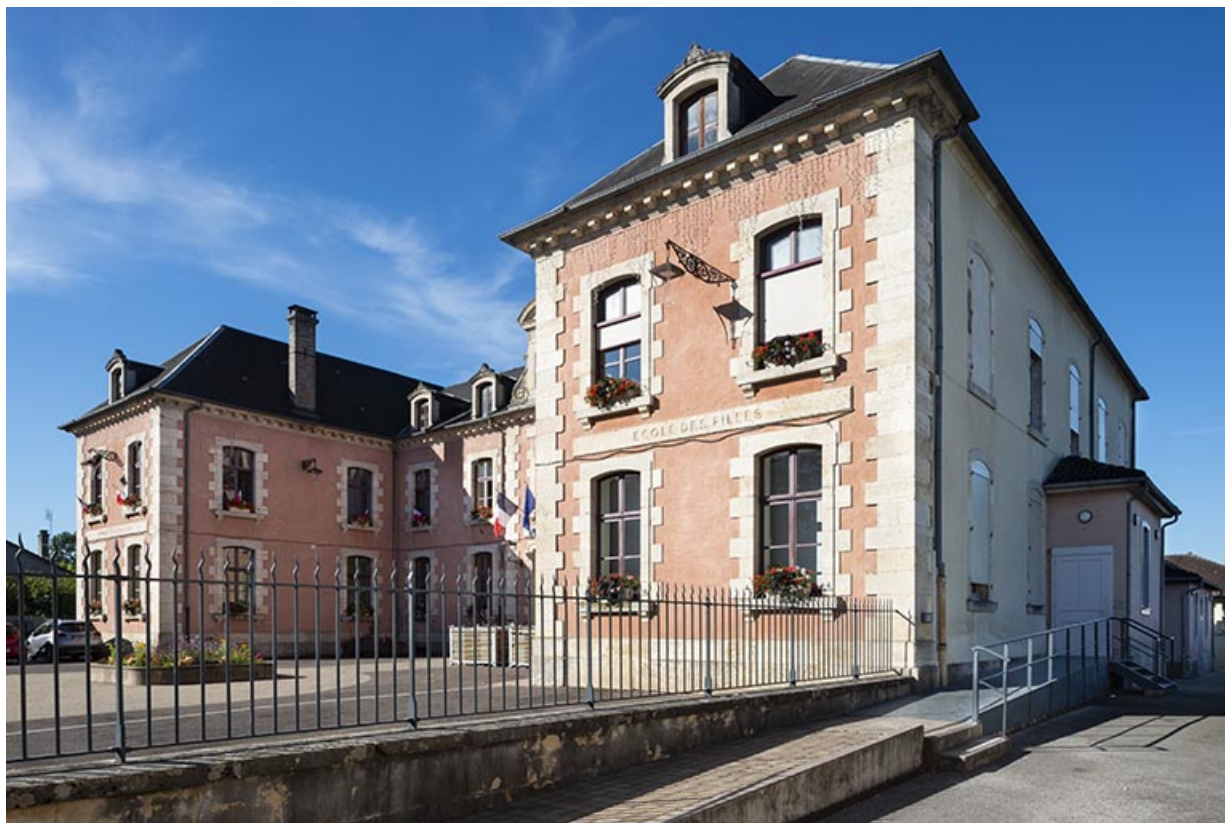
Façade nord-est, vue d'ensemble de trois-quarts gauche.
