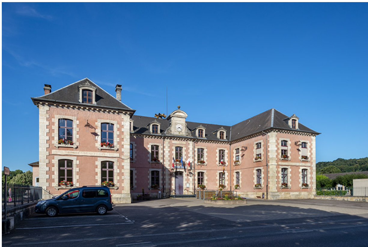
Façade nord-est, vue d'ensemble de trois-quarts droit.
