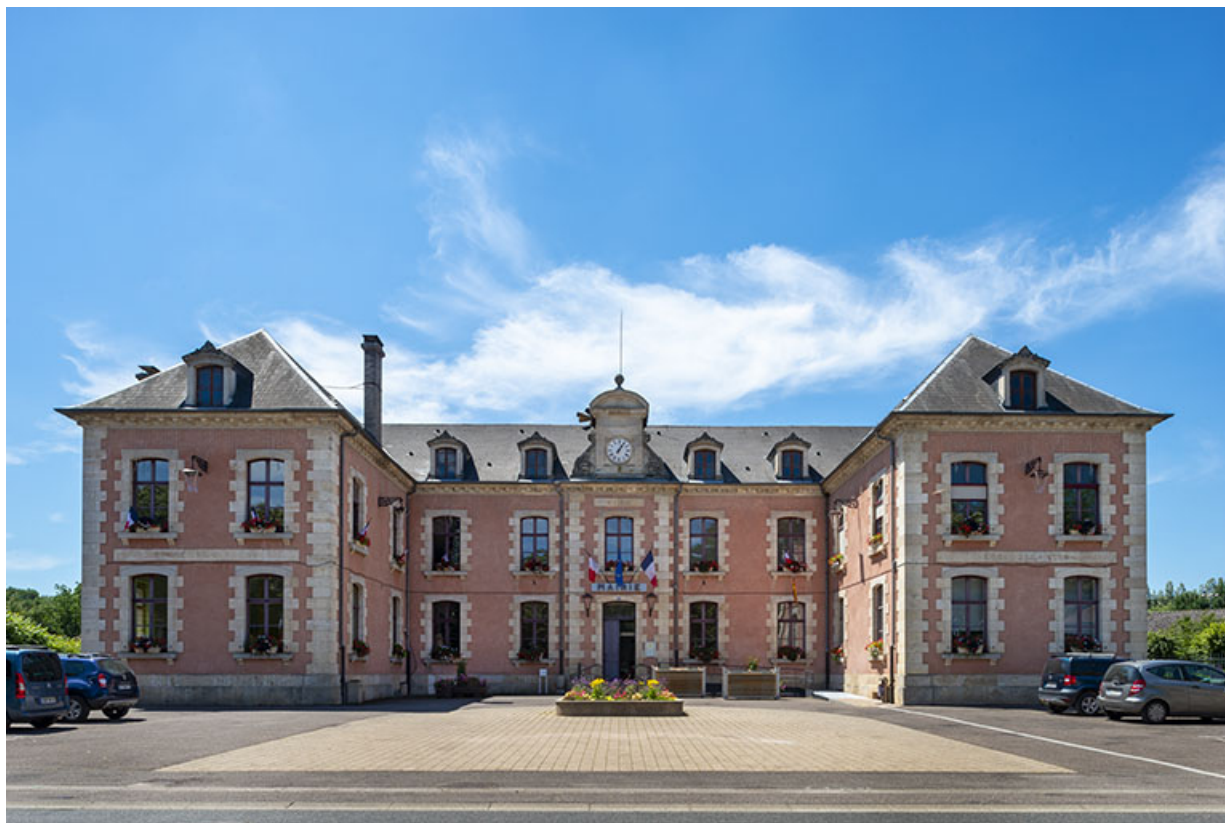
Façade nord-est, vue d'ensemble de face.
