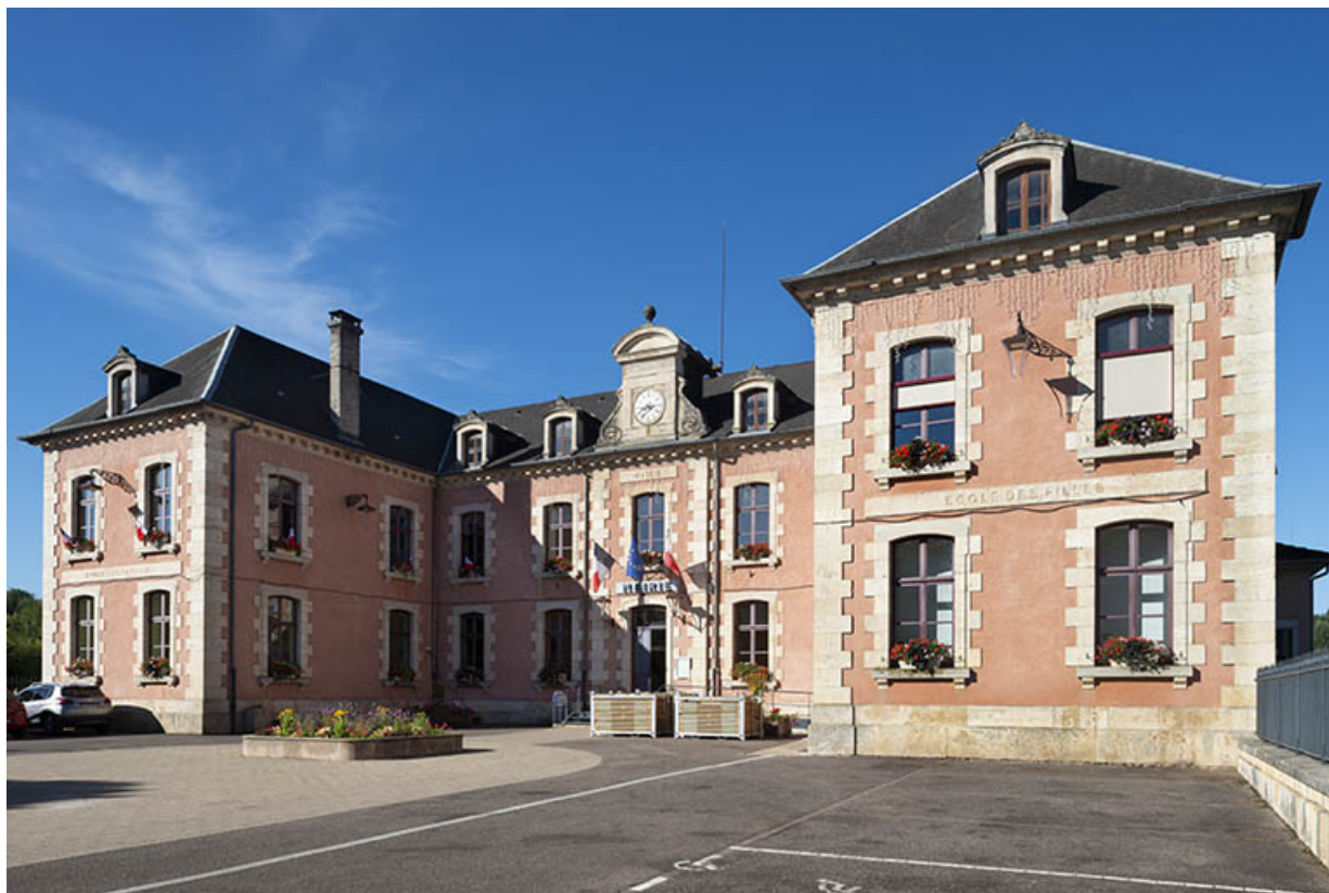
Façade nord-est, vue d'ensemble de trois-quarts gauche.
