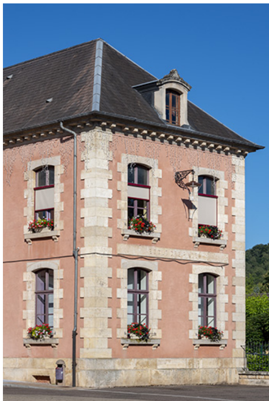
Extrémité de l'aile nord-ouest (ancienne école des filles). 70, Scey-sur-Saône-et-Saint-Albin, 24 avenue des Pâtis
