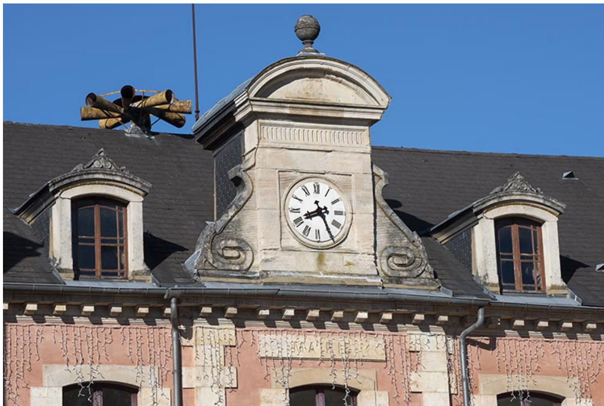
Édicule en amortissement, lucarne, horloge et générateur d'ondes mécaniques.
