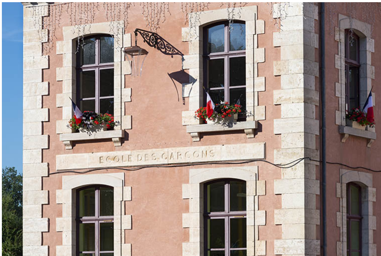
Extrémité de l'aile nord-ouest (ancienne école des garçons), détail. 70, Scey-sur-Saône-et-Saint-Albin, 24 avenue des Pâtis
