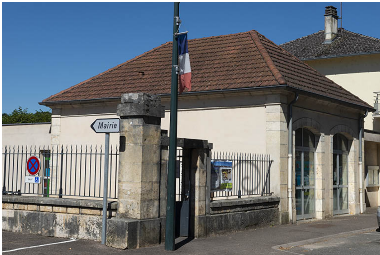
Remise de pompes à incendie, sur l'avenue des Pâtis.
