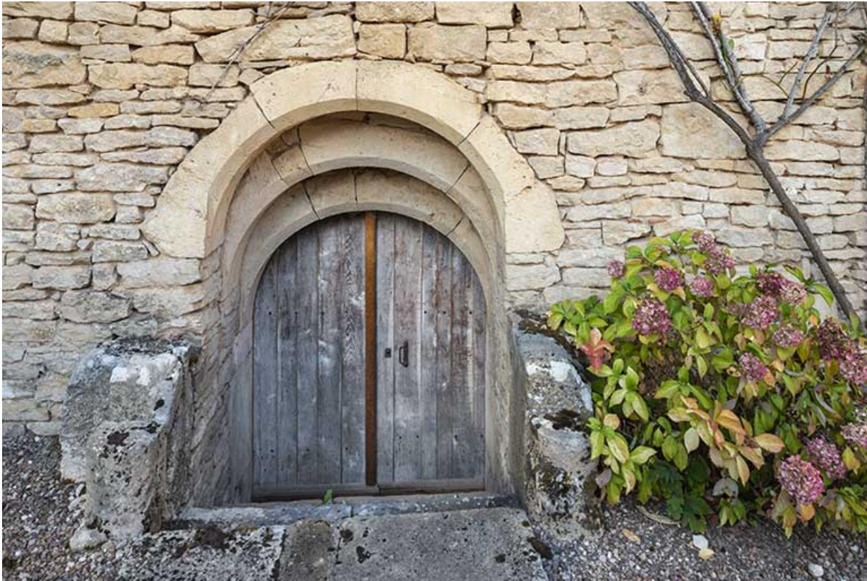
Porte de cave de l'aile ouest donnant sur la cour.
