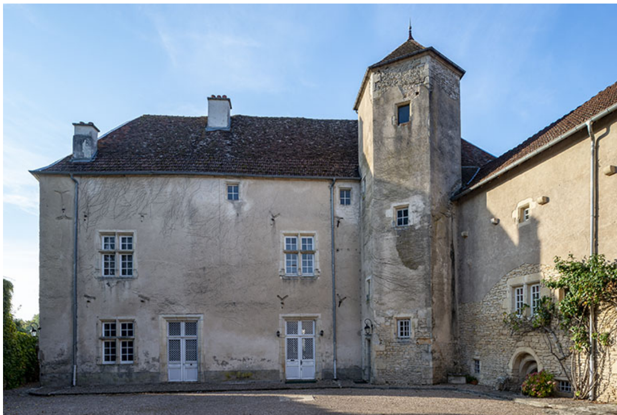
Façade nord du corps principal et cour, vue depuis le nord.
