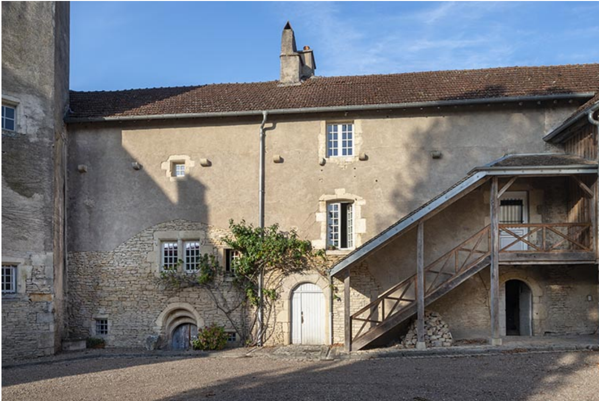
Façade est de l'aile latérale ouest, vue depuis l'est. 70, Scey-sur-Saône-et-Saint-Albin, 8-10 rue de l' Enfer
