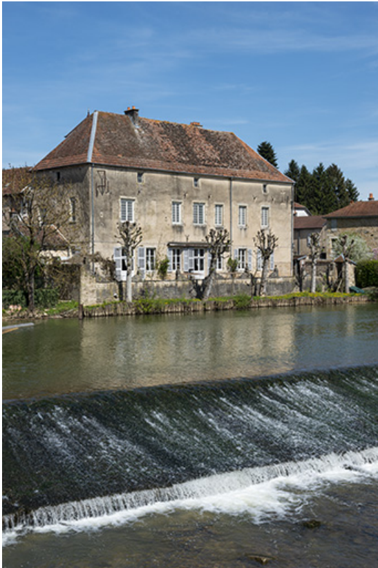
Vue d'ensemble depuis le pont sur la Saône.
