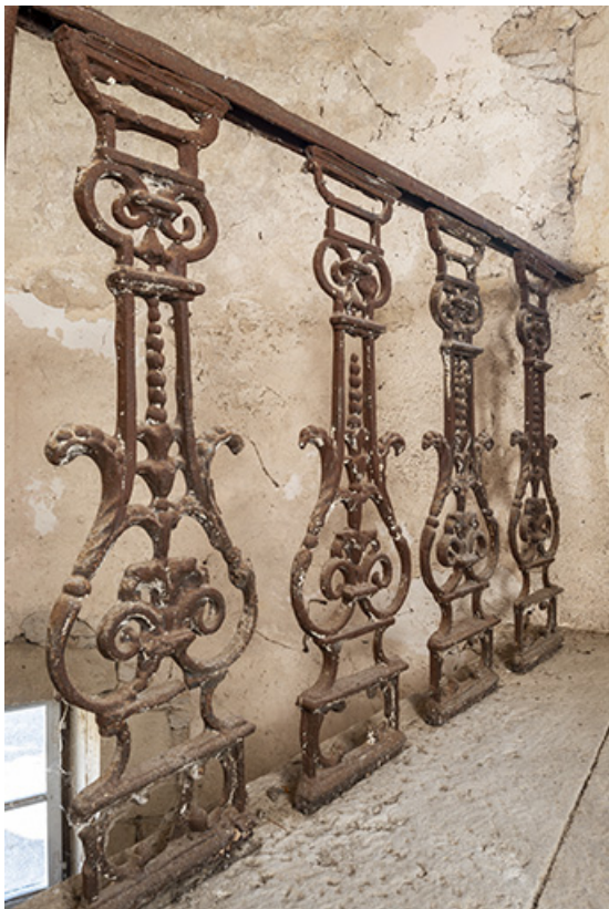
Garde-corps à motif de balustres en ferronnerie.
