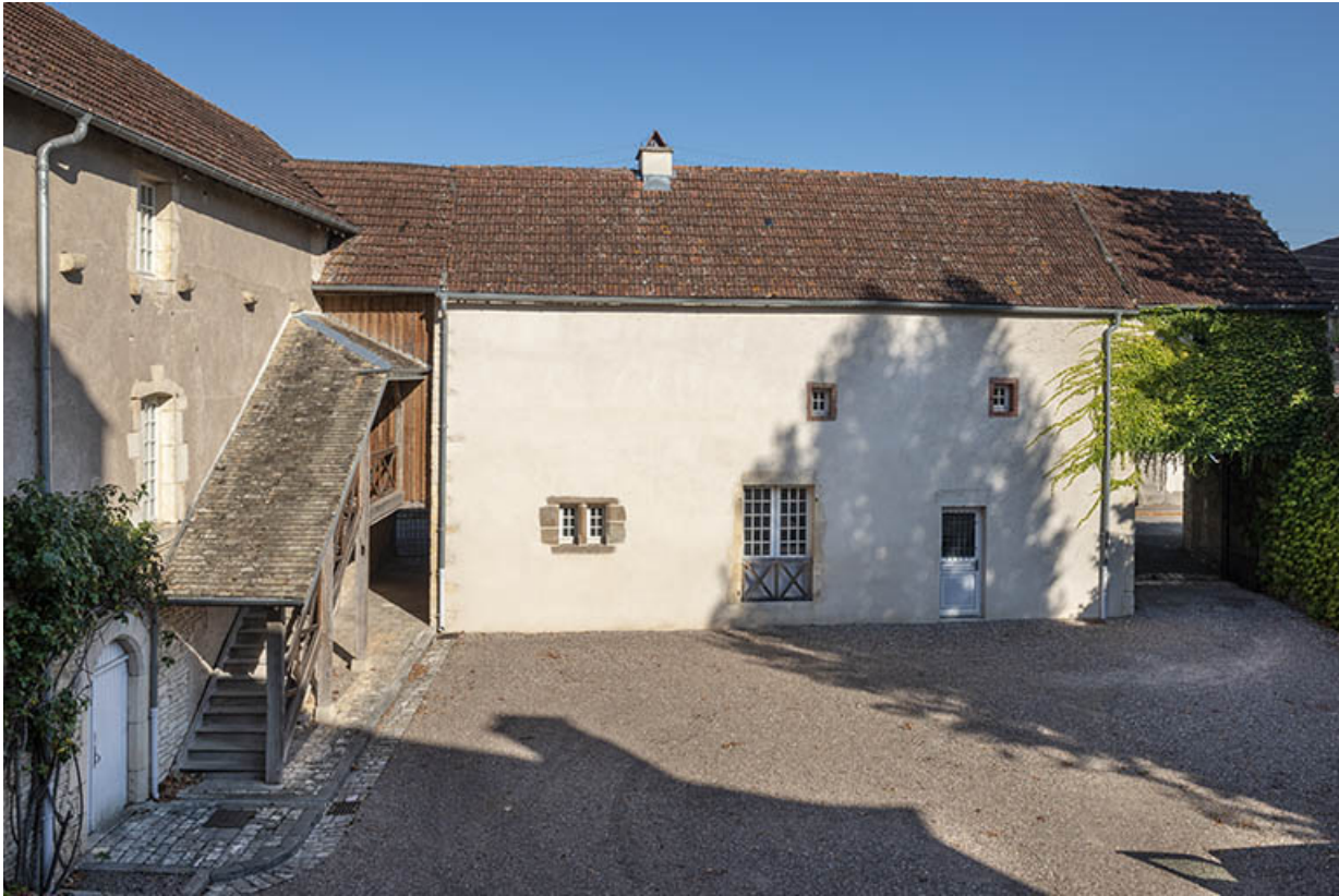
Façade sud de l'aile nord et cour, vue depuis le sud.
