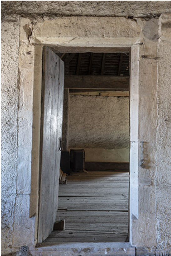
Comble du corps principal, porte séparant les deux parties constitutives (vue vers l'est). 70, Scey-sur-Saône-et-Saint-Albin, 8-10 rue de l' Enfer
