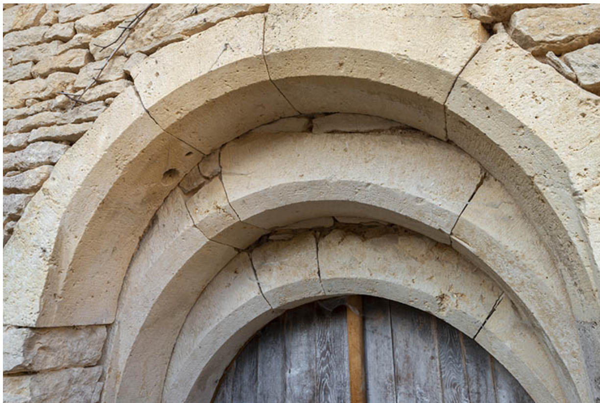
Porte de cave de l'aile ouest, détail de la voussure. 70, Scey-sur-Saône-et-Saint-Albin, 8-10 rue de l' Enfer
