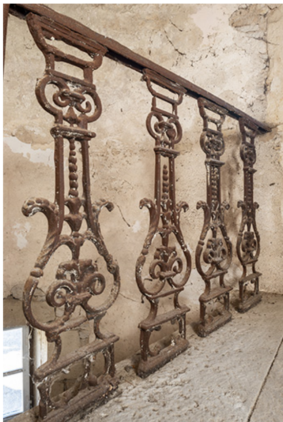
Garde-corps à motif de balustres en ferronnerie.
