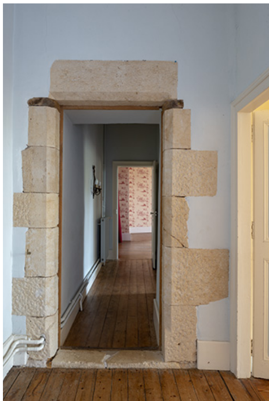
Premier étage du corps principal, porte séparant les deux parties constitutives (vue vers l'est). 70, Scey-sur-Saône-et-Saint-Albin, 8-10 rue de l' Enfer
