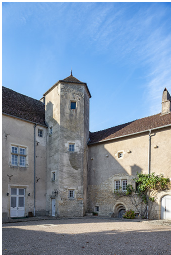
Tour d'escalier et cour, vue depuis le nord-est.
