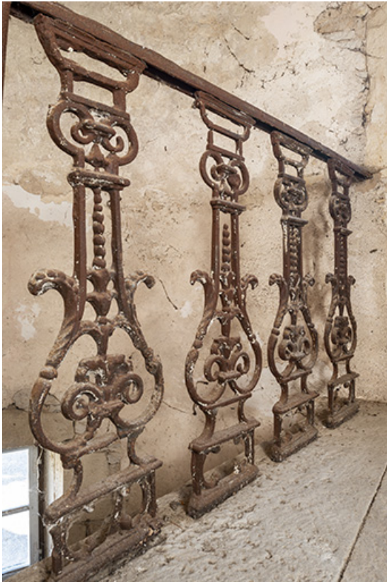
Garde-corps à motif de balustres en ferronnerie.
