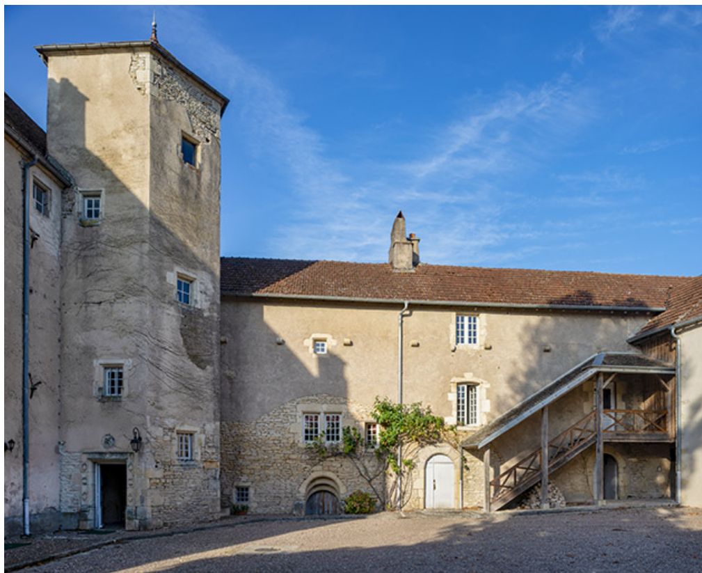
Façade est de l'aile latérale ouest, vue depuis l'est. 70, Scey-sur-Saône-et-Saint-Albin, 8-10 rue de l'Enfer
