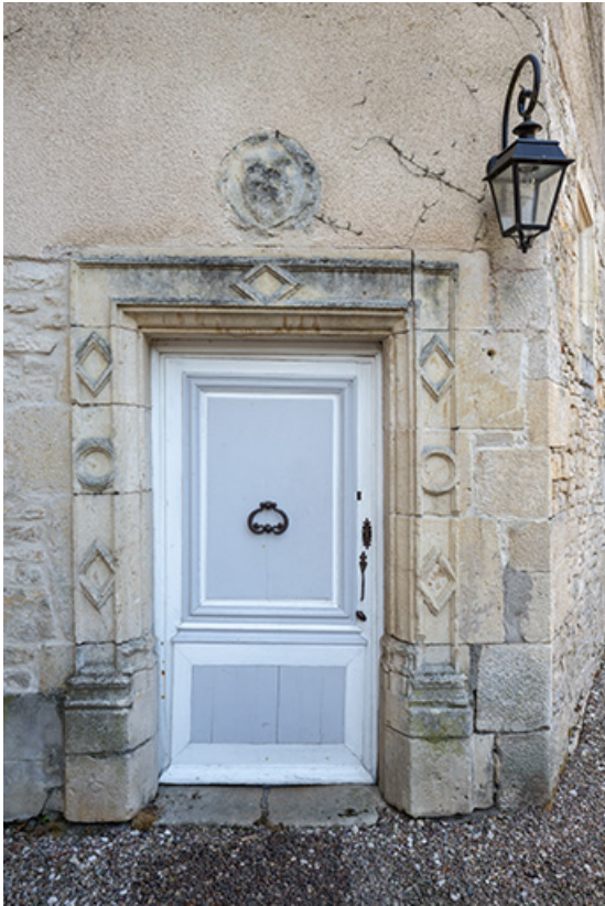
Encadrement de la porte de la tour d'escalier (porte fermée).
