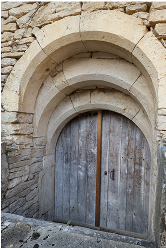
Porte de cave de l'aile ouest donnant sur la cour. 70, Scey-sur-Saône-et-Saint-Albin, 8-10 rue de l' Enfer
