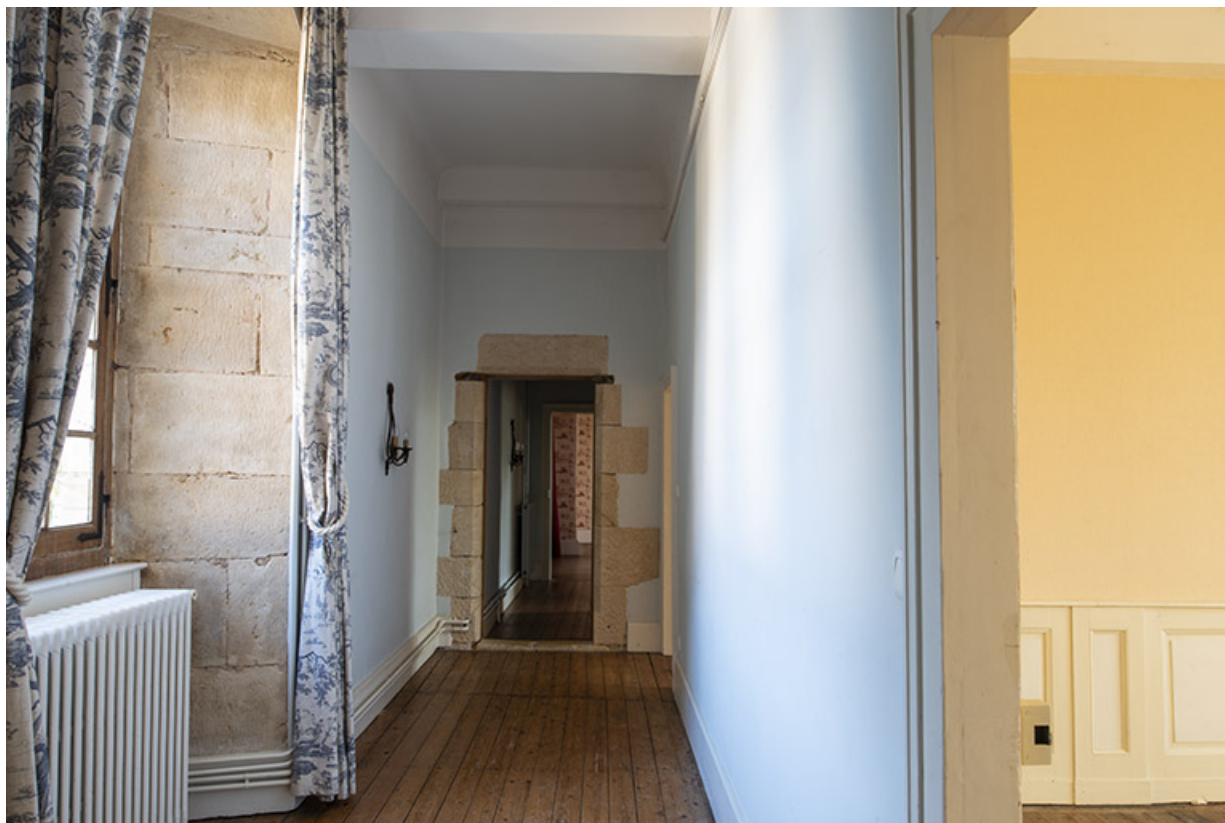
Premier étage du corps principal, couloir de distribution, vue vers est.
