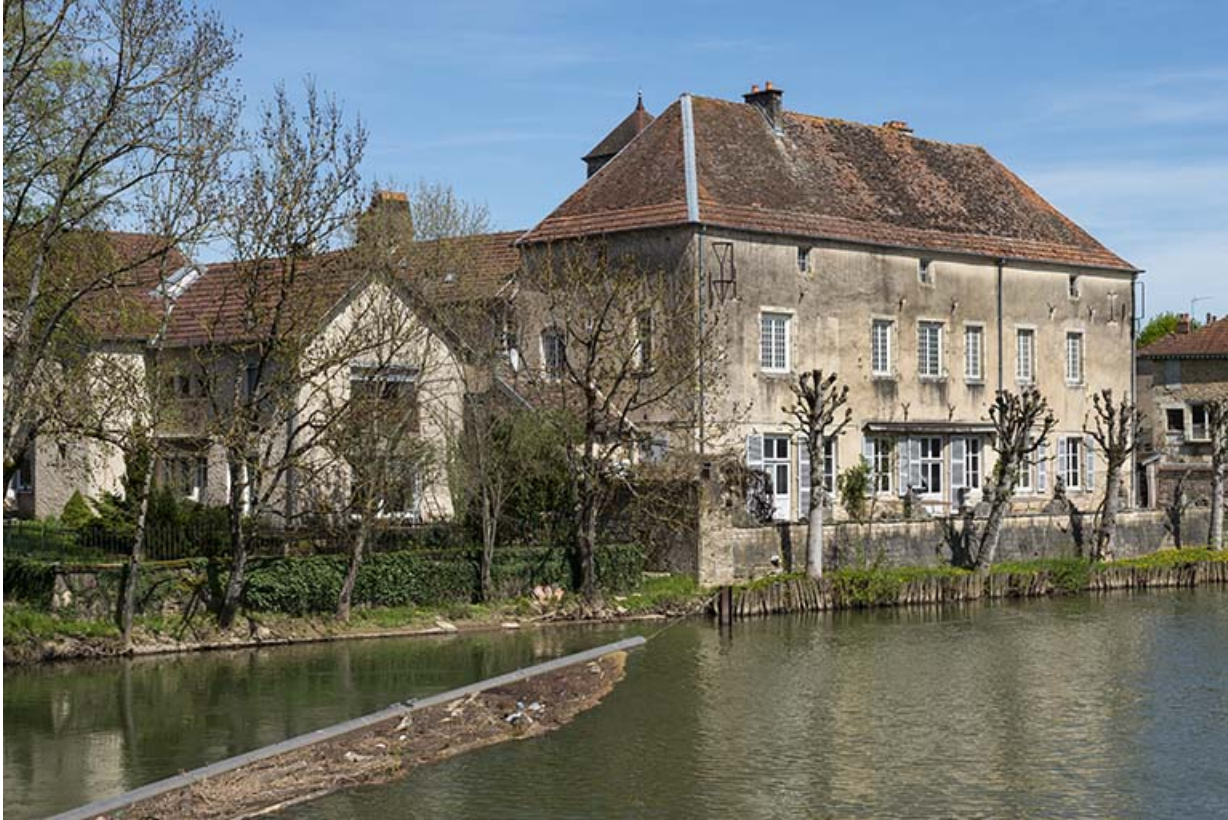
Façade sud du corps principal et terrasse donnant sur la Saône.
