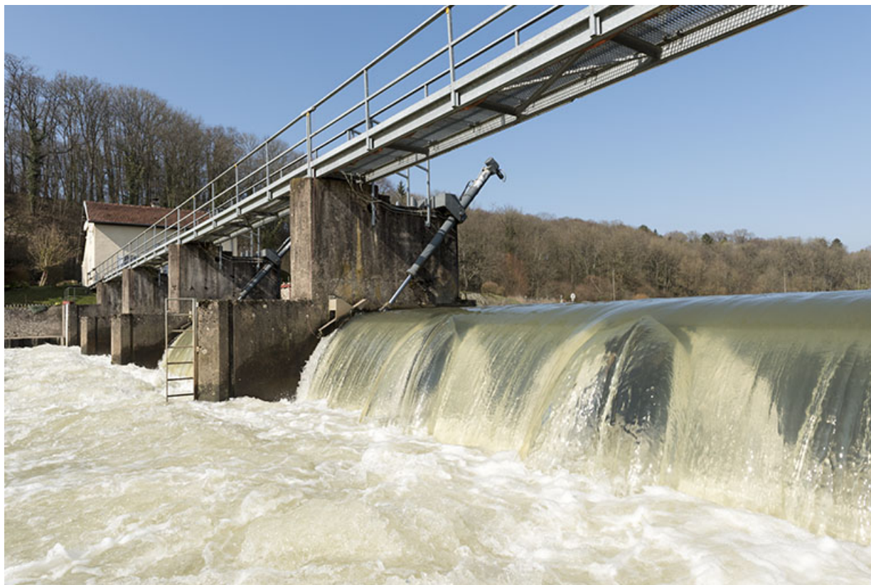
La passerelle du barrage. 70, Ormoy
