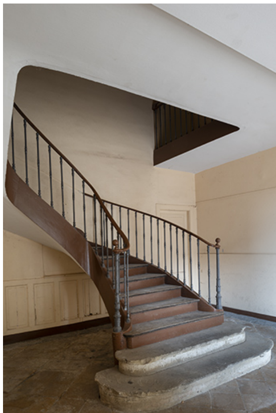
Escalier du corps central, vue de trois-quarts droit.
