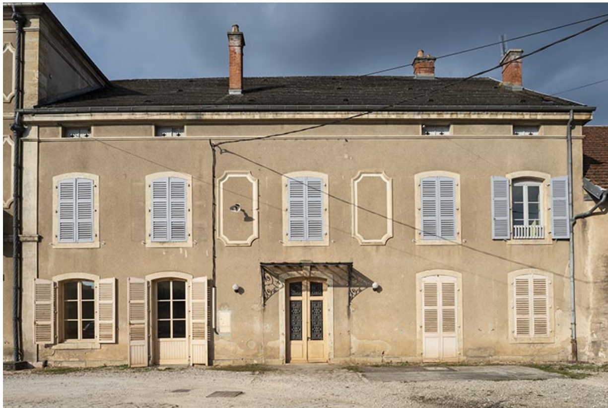
Corps de bâtiment central, façade sur la cour, vue de face.
