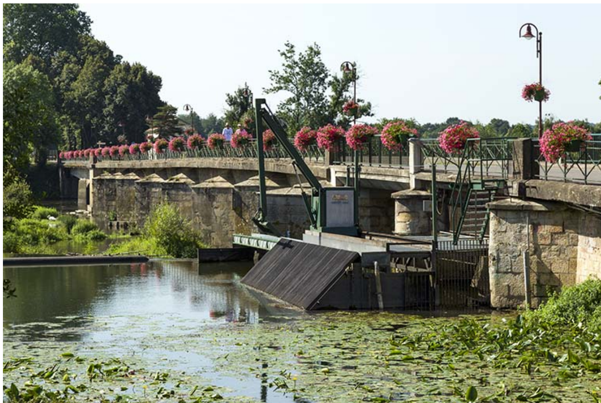
Le pont et la "portière" qui alimentait l'ancienne forge.
