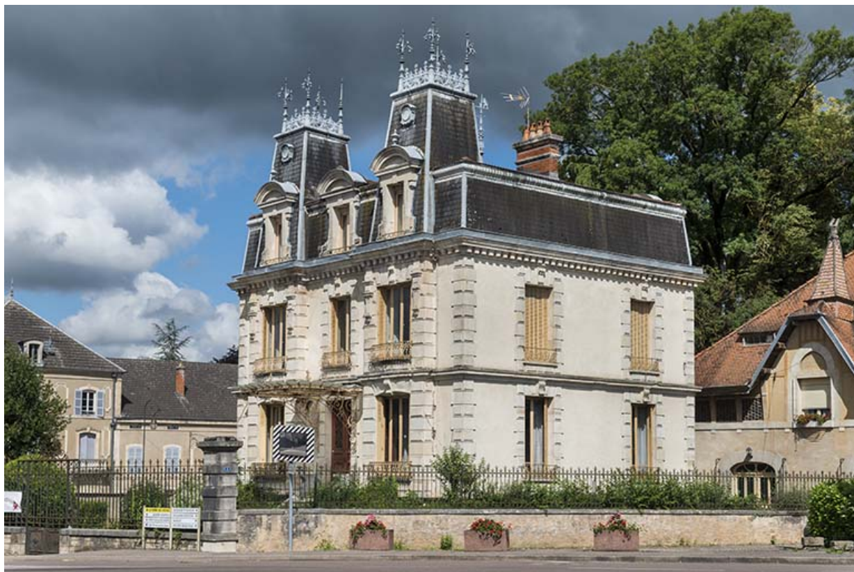
Vue d'ensemble de la maison, depuis l'est.
