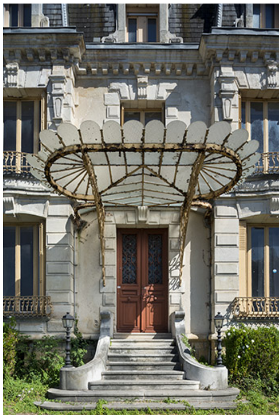
Porte d'entrée principale surmontée d'une marquise, vue de face.
