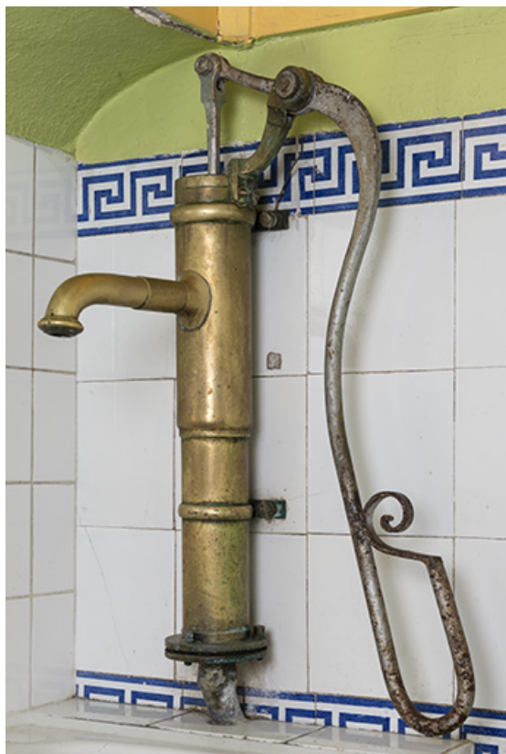
Rez-de-chaussée, cuisine, pompe à main.
