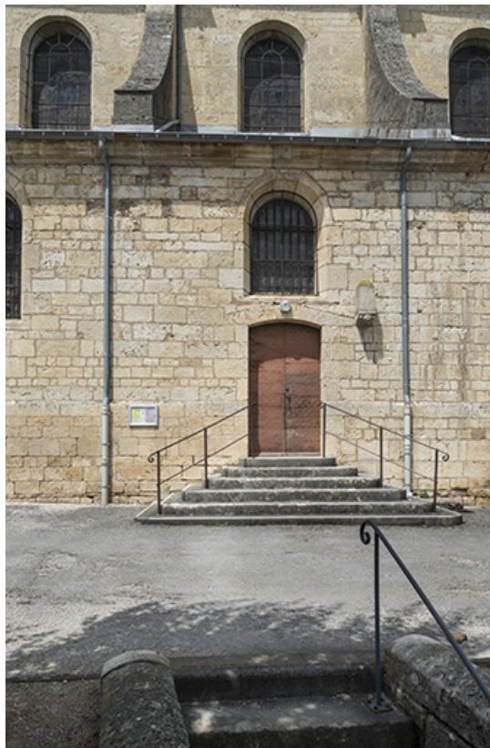
Flanc sud, porte de la chapelle des fonts.
