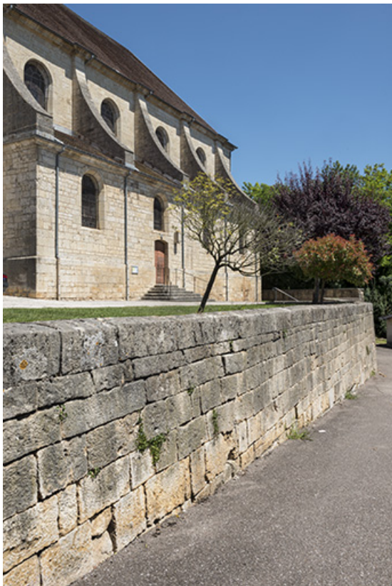
Flanc sud, mur de l'ancien cimetière.
