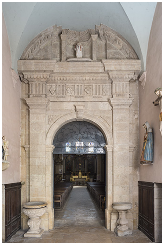
Porte, vue depuis le clocher-porche vers la nef. 70, Scey-sur-Saône-et-Saint-Albin rue de l' Église
