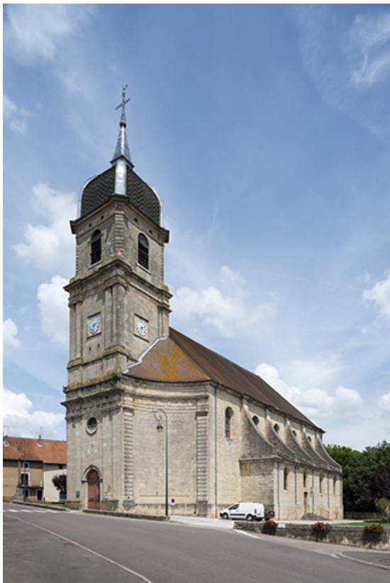
Vue d'ensemble depuis la rue de l'Église.
