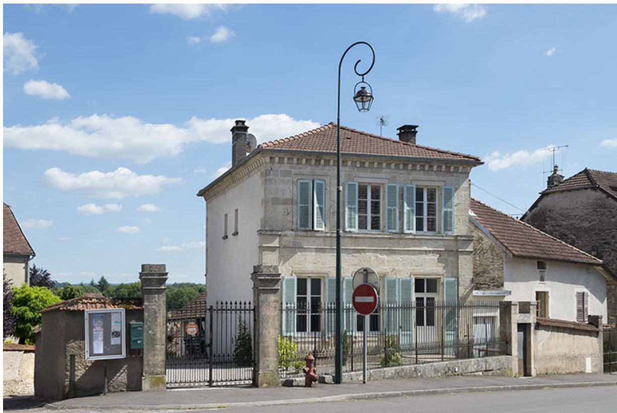
Ancienne école des filles, rue de l'Eglise. 70, Scey-sur-Saône-et-Saint-Albin
