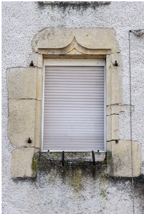
Fenêtre avec linteau en accolade.
