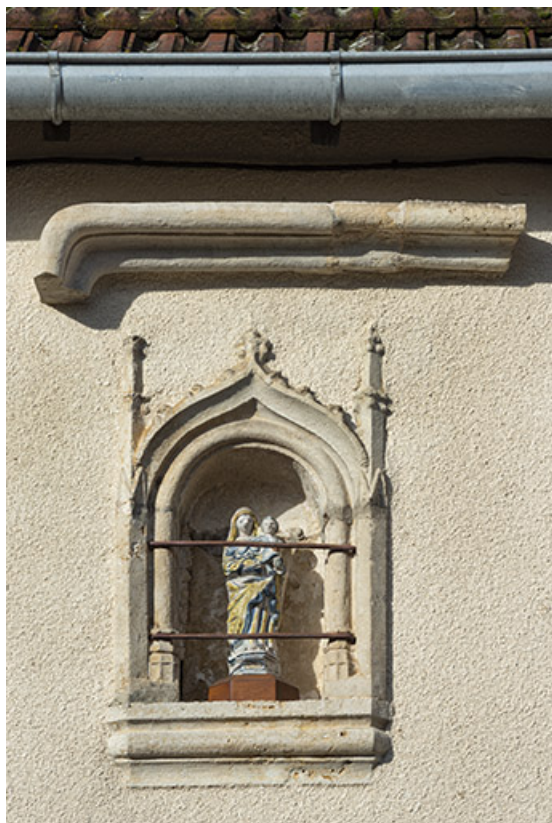
Niche et statuette surmontées d'un fragment de corniche.
