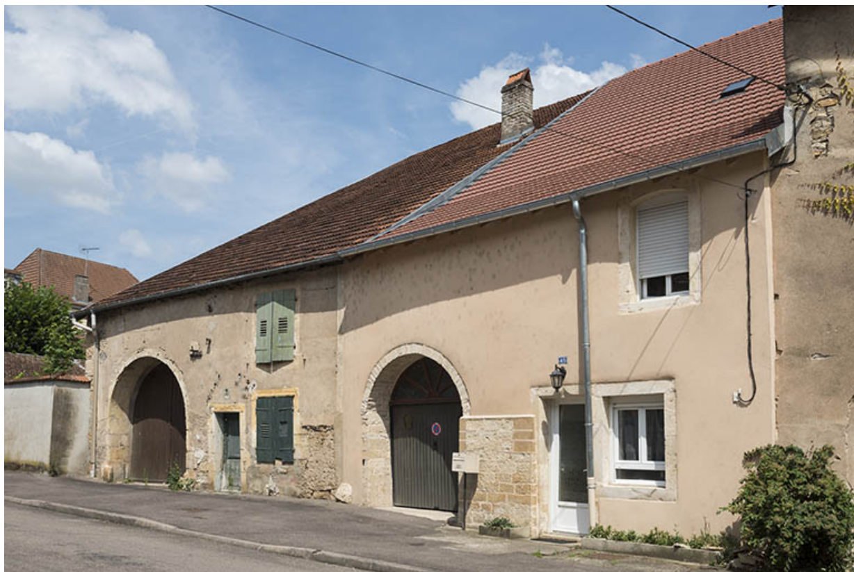
Détail de la façade antérieure de la ferme située au numéro 45. 70, Scey-sur-Saône-et-Saint-Albin, 43 Grande Rue du Bourg
