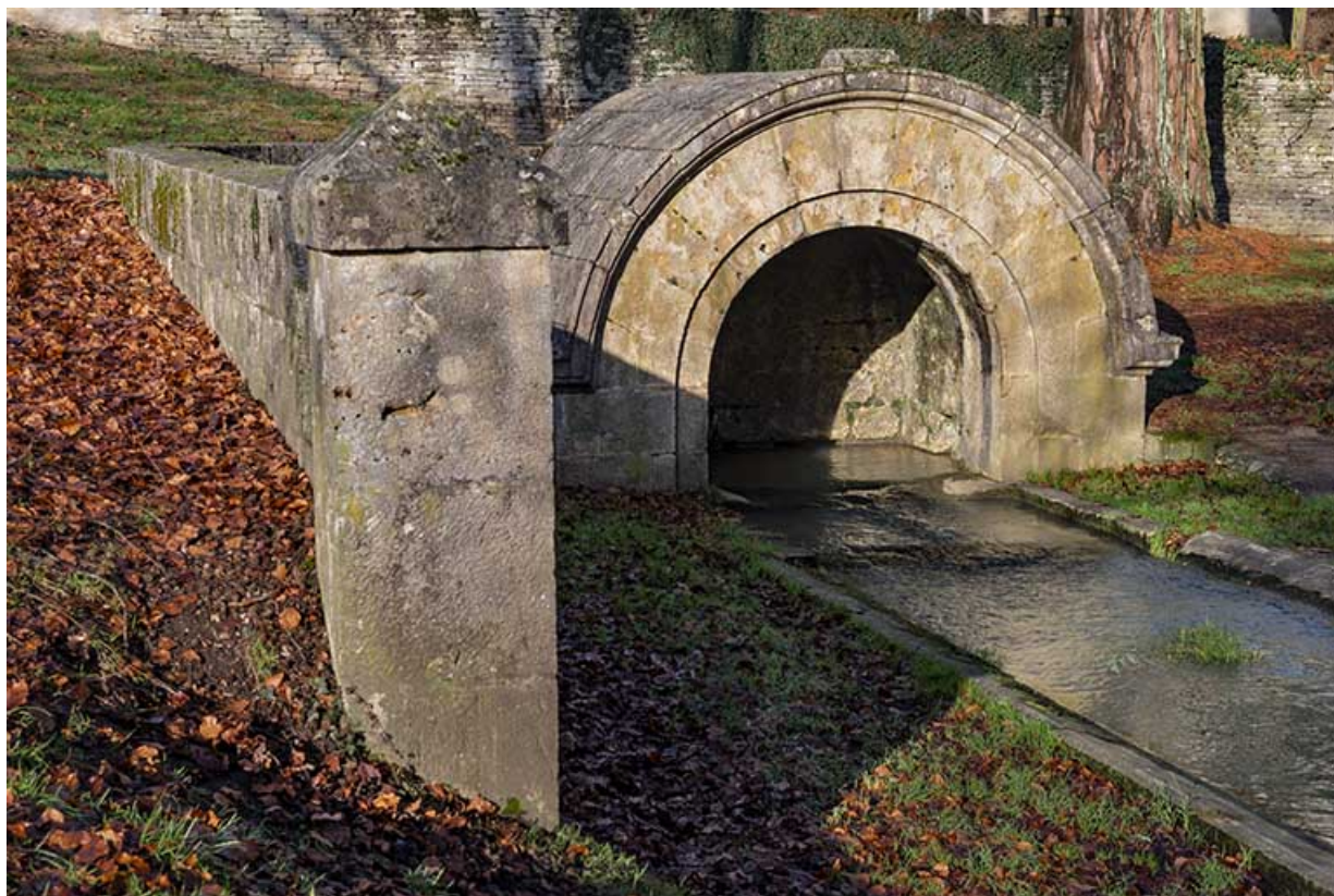
Mur de soutènement, vue depuis le sud.
