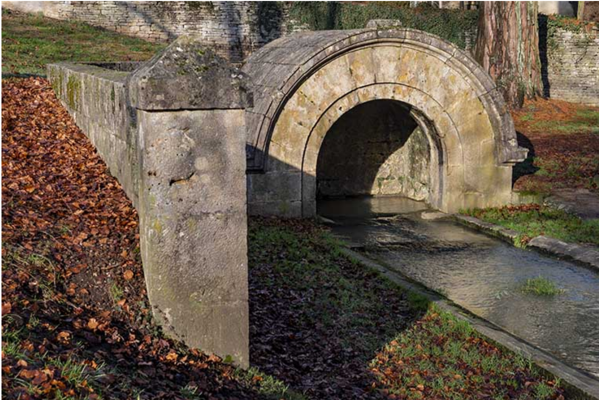
Mur de soutènement, vue depuis le sud.
