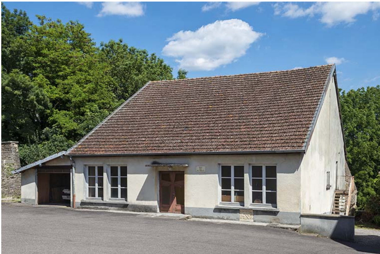
La salle paroissiale installée dans l'ancien presbytère appelé "vieille cure". 70, Scey-sur-Saône-et-Saint-Albin, 2 rue du Presbytère
