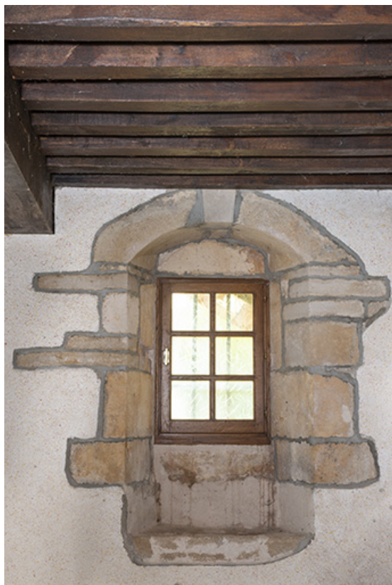
Détail d'une fenêtre, ancienne cure.
