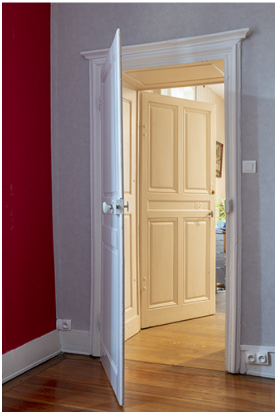
Portes d'enfilade, rez-de-chaussée du presbytère. 70, Scey-sur-Saône-et-Saint-Albin, 2 rue du Presbytère
