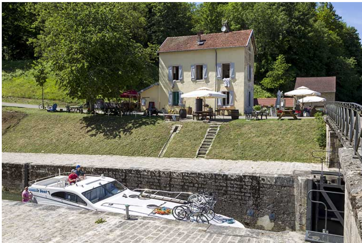
Entrée amont du tunnel Saint-Albin.
