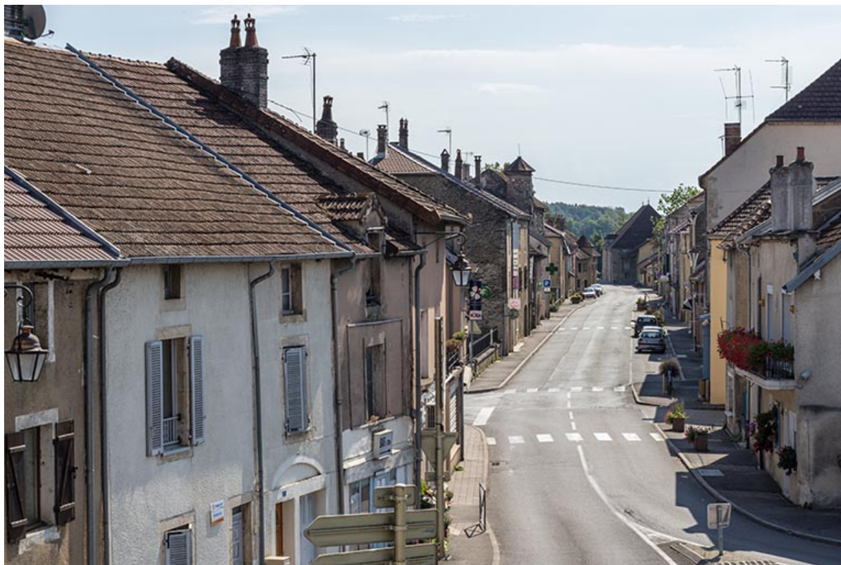
Emplacement de l'ancienne porte du Bourg, vue du nord. 70, Sceaux-sur-Saône-et-Saint-Albin rue Armand Paulmard
