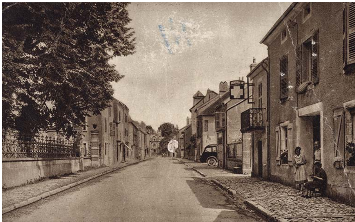
Vue d'ensemble de la rue, du sud vers le nord.
