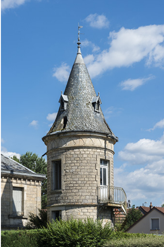
Tour, vue depuis le nord.
