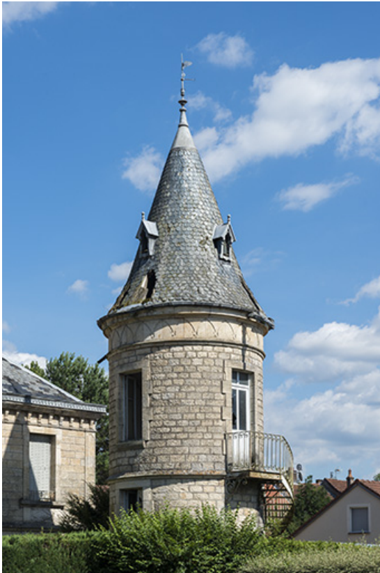
Tour, vue depuis le nord.
